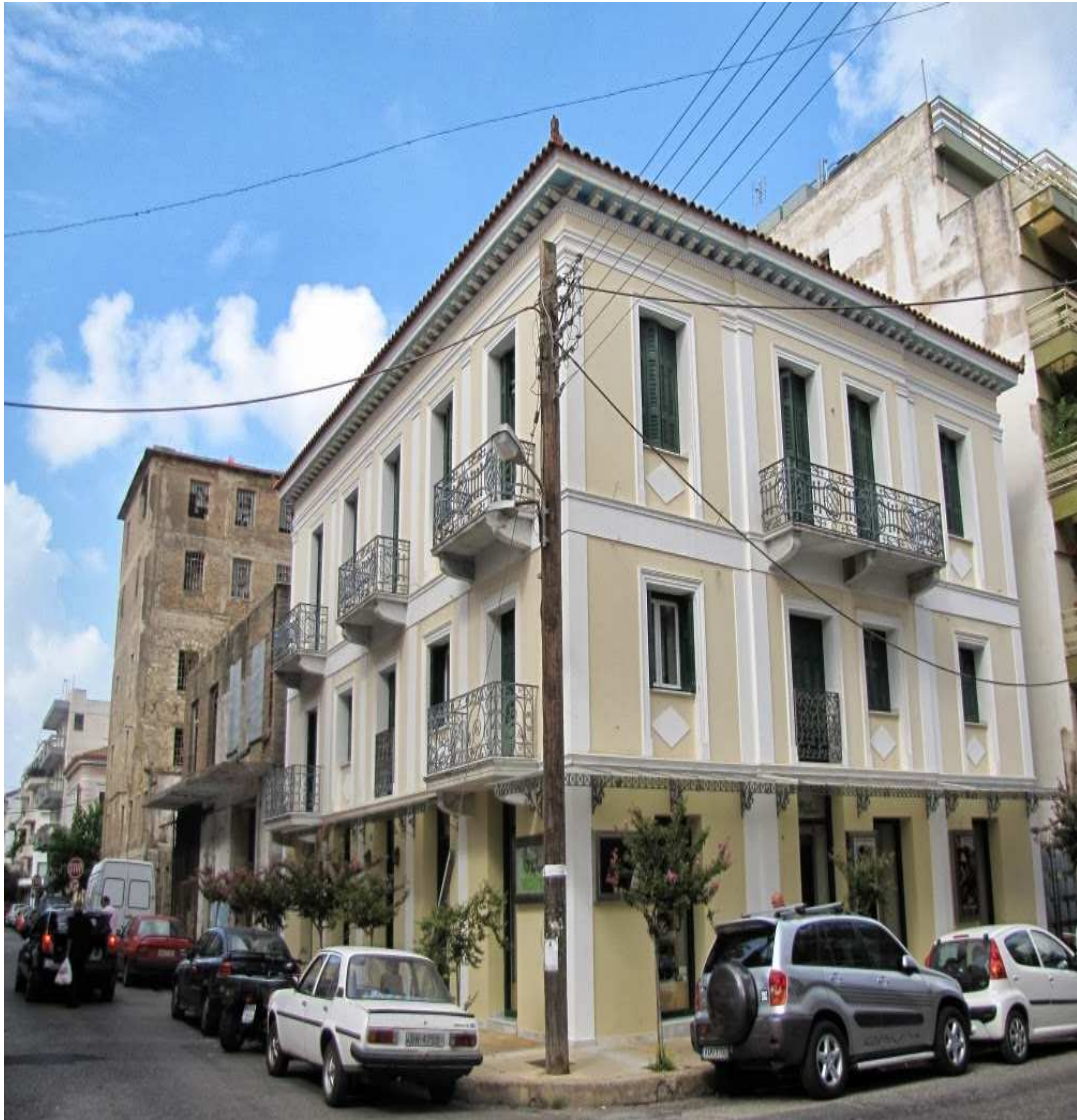
Εικ. 46 Κτήριο επί των οδών Ζαΐμη και Θεμιστοκλέους στον Πόργο
