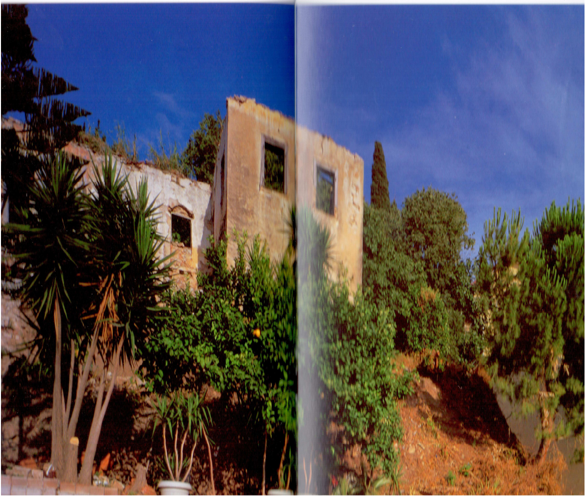
Εικ. 47 Άποψη τμήματος του παλαιού ημιορεινού οικισμού στην Άνω Πόλη της Κυπαρισσίας
