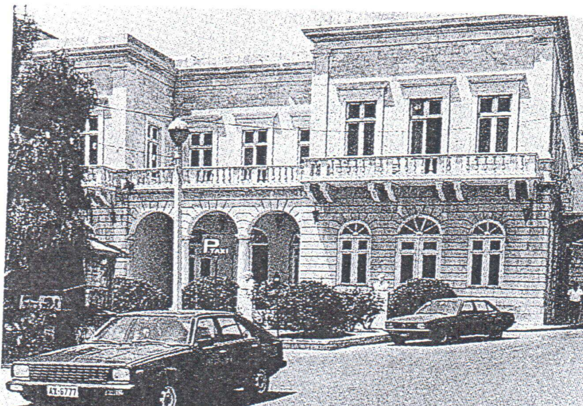
Εικ. 5 Η Λέσχη Ελλάς στην Ερμούπολη, έργο του Ιταλού αρχιτέκτονα P. Sampo (1862-1864)
