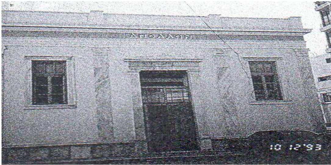
Εικ. 43 Θέατρο «Απόλλων» του Πύργου, έργο του Ερνέστου Τσίλλερ (1878)
