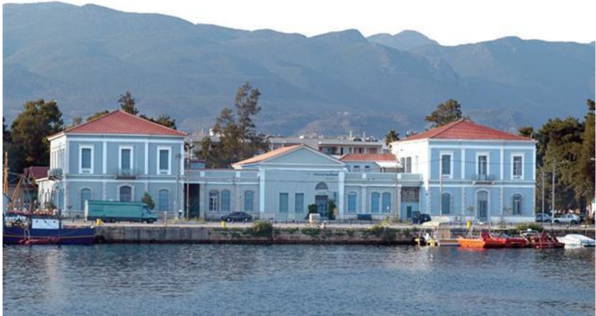
Εικ. 37 Το διατηρητέο κτήριο του νέου Τελωνείου (Ντουάνα) στο λιμάνι της Καλαμάτας
