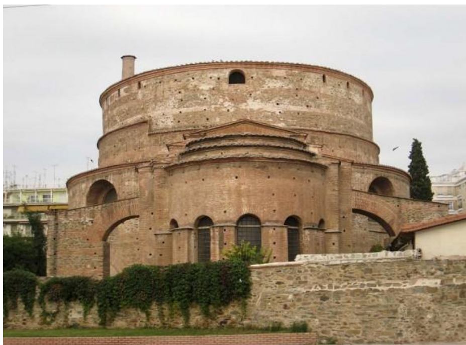
Εικ. 13 Άποψη του μνημείου της Ροτόντας στη Θεσσαλονίκη
