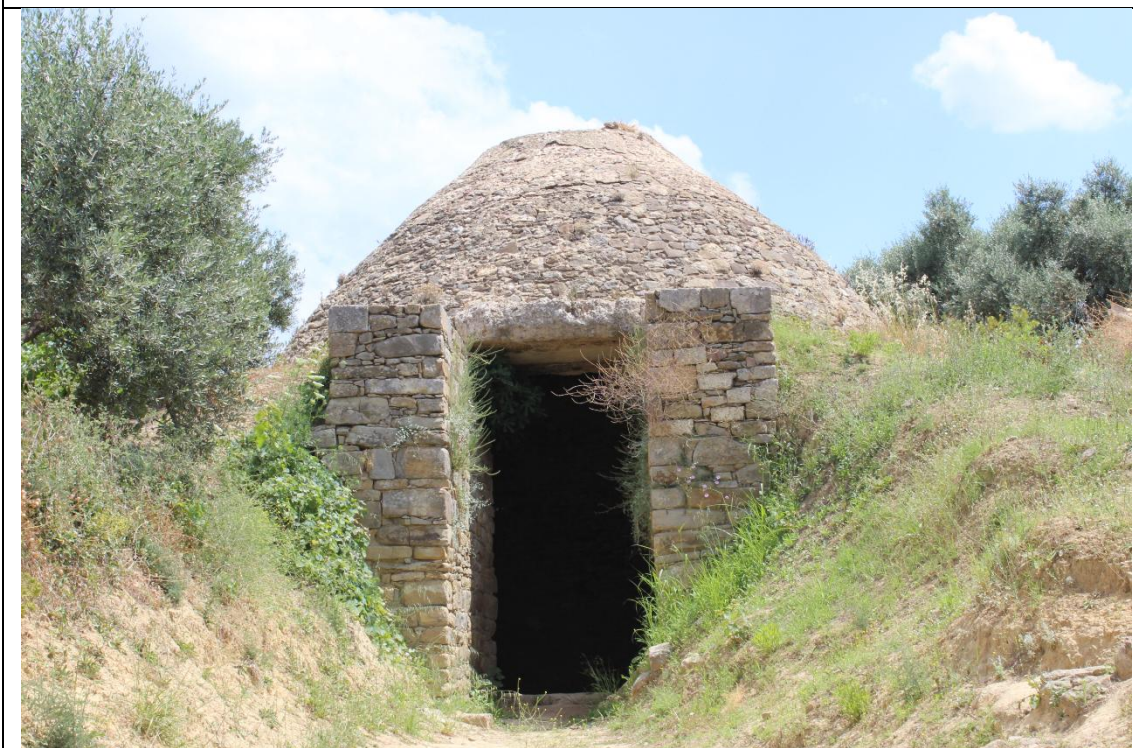
Εικόνα 2 - Ο Θολωτός Τάφος IV στην περιοχή του Ανακτόρου
