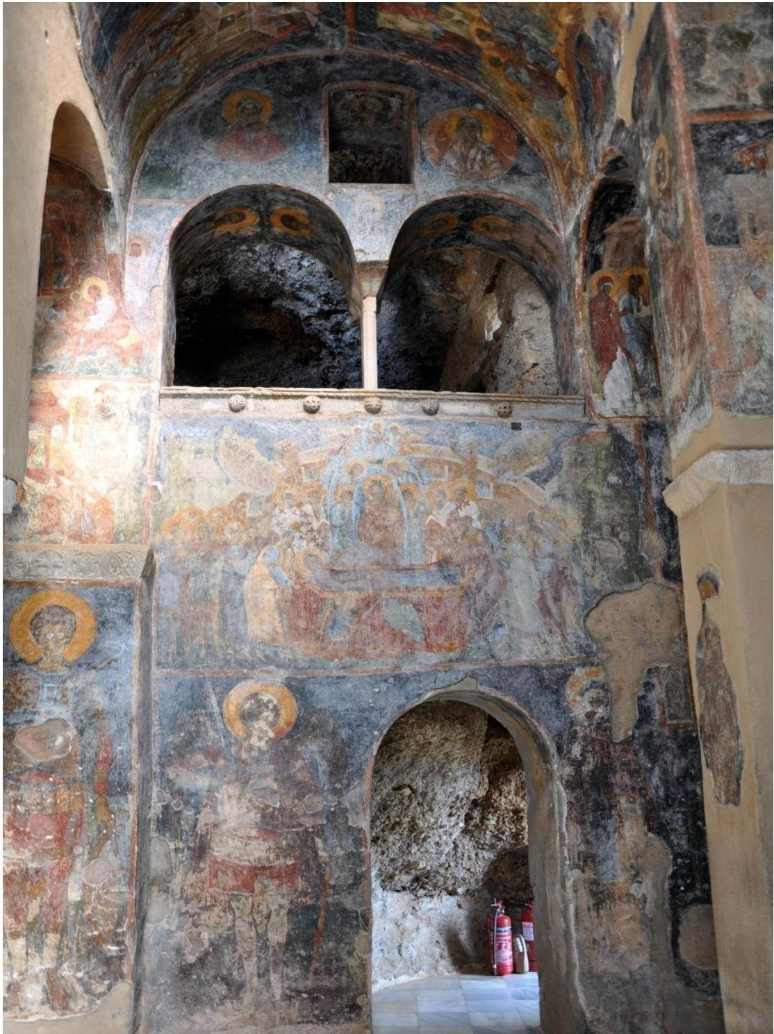
Εικ. 33. Τμήμα του βόρειου τοίχου κάτω από το δίλοβο άνοιγμα του υπερόου και επάνω από την κεντρική είσοδο του καθολικού
