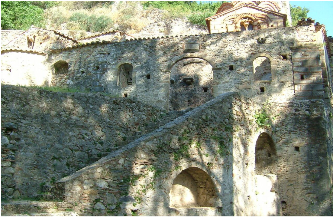
Εικ. 13. Σκάλα που οδηγεί από τον νάρθηκα στο πλάτωμα
