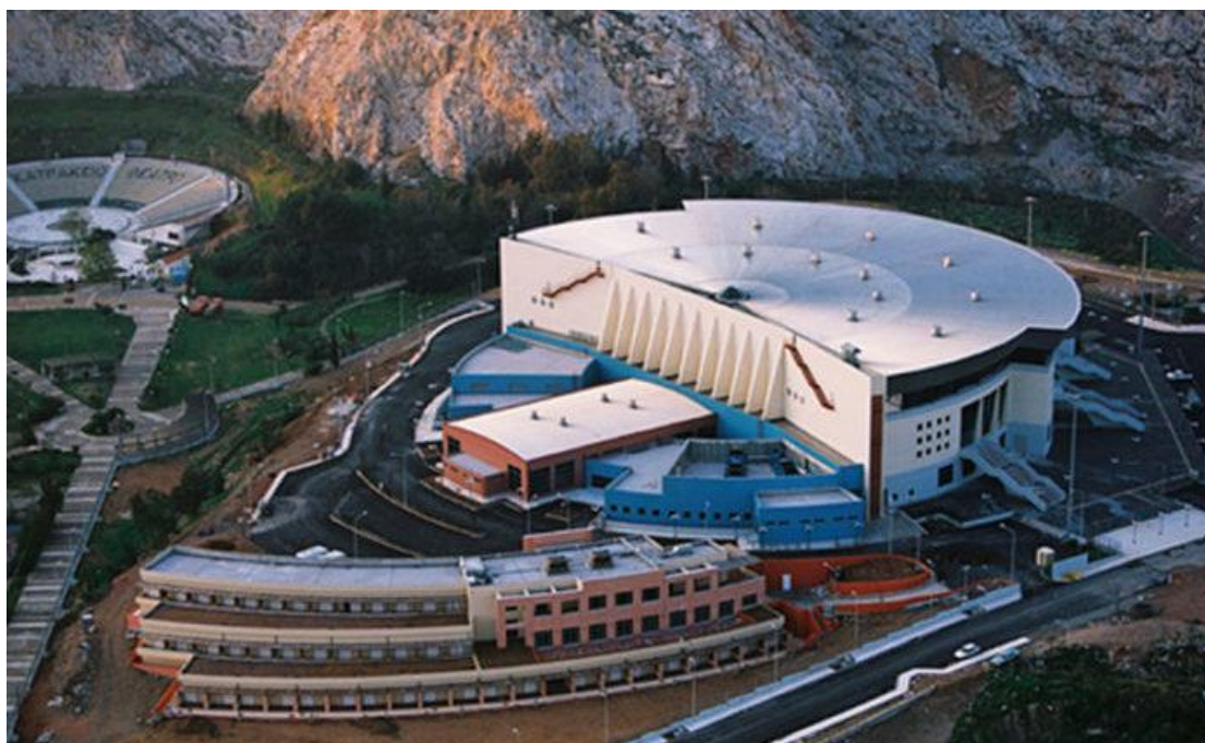
Εικόνα 6 : Το Ολυμπιακό Κλειστό Γυμναστήριο της Άρσης Βαρών
