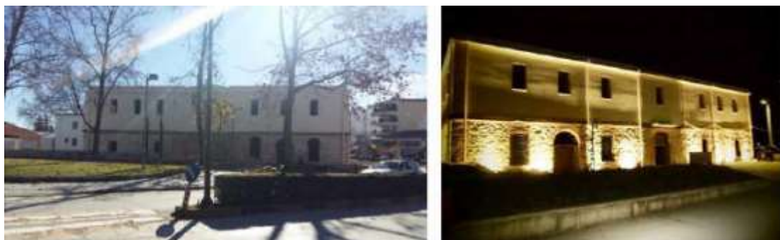
Εικόνα 2.4 - Κτίριο φυλακών Τρικάλων πριν την μετατροπή τους σε μουσείο Βασίλη Τσιτσάνη
