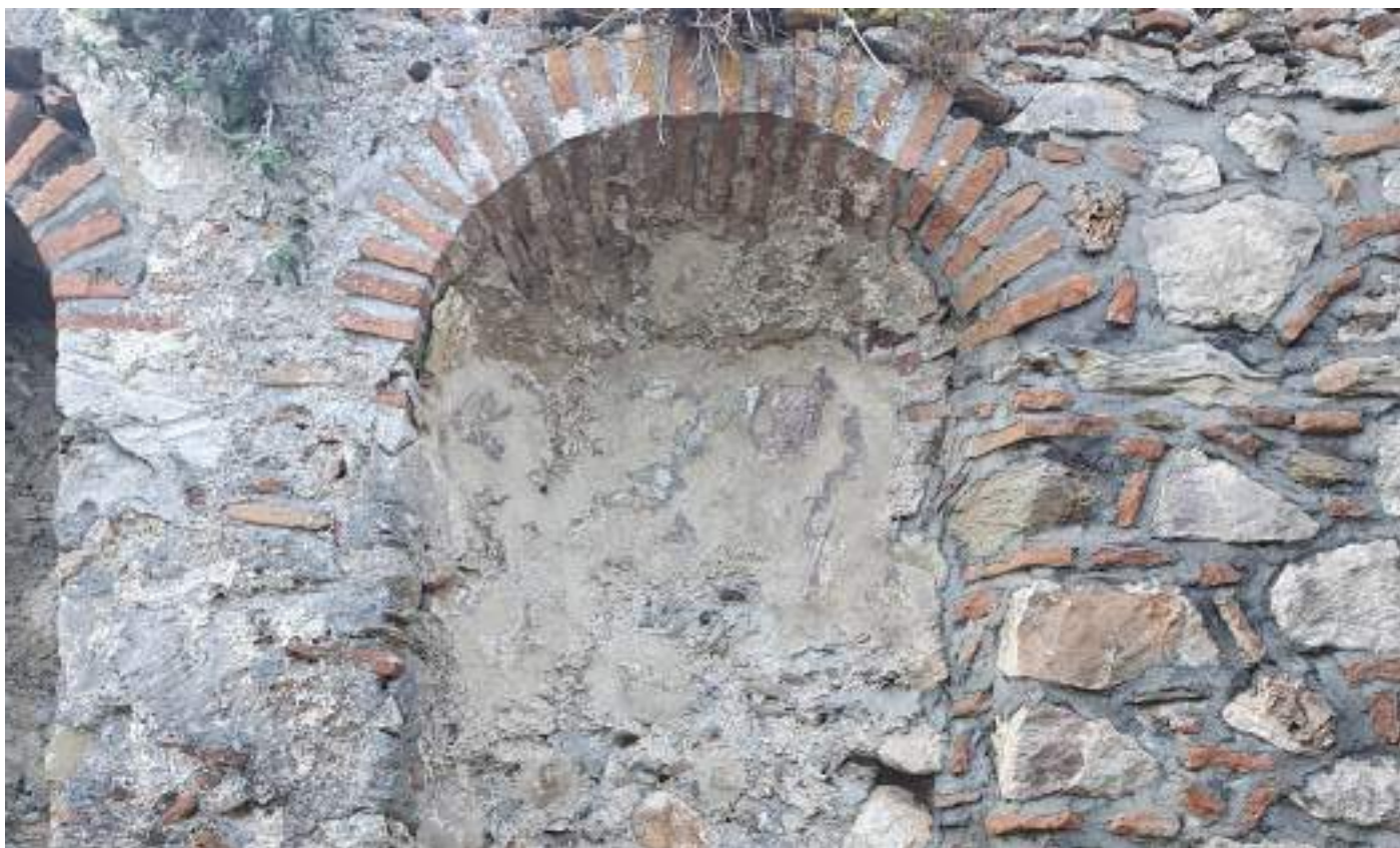
Εικόνα 74: Τυφλό κογχάριο στο εσωτερικό της Τράπεζας της Μ. Ζωοδότου Χριστού με σπαράγματα τοιχογραφιών, 2022.
