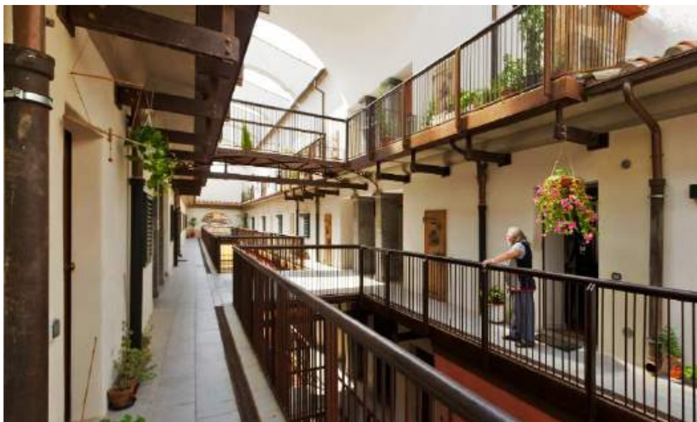
Εικόνα 98: Le murate, Φλωρεντία. Εσωτερικοί κοινόχρηστοι εξώστες μετά από τις εργασίες αποκατάστασης.
