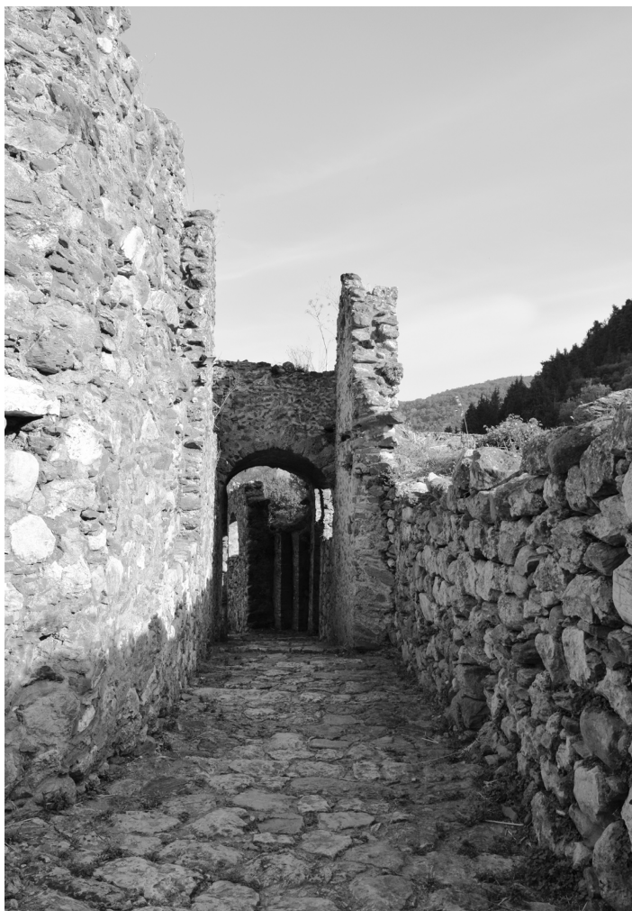
Εικόνα 8: Κάτω Χώρα Μυστρά. Συνέχεια ιδιοκτησίας (διαβατικό) πάνω από το δημόσιο δρόμο, 2018.
