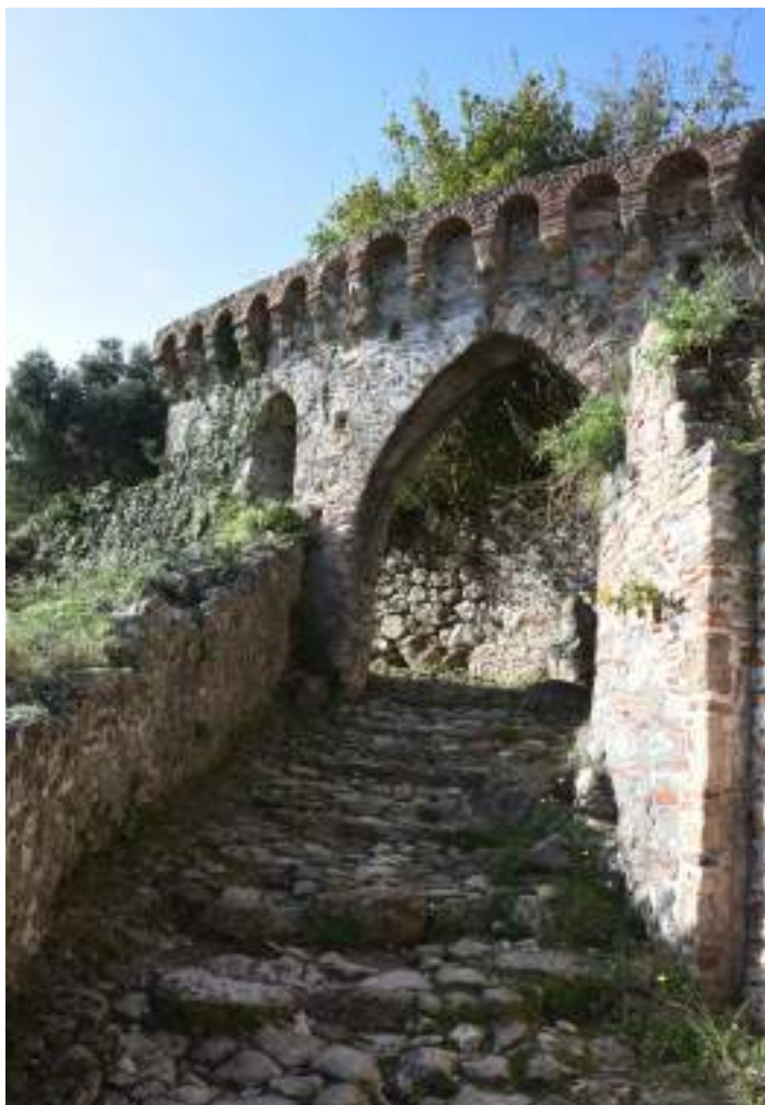
Εικόνα 90: Κάτω Χώρα Μυστρά. Οξυκόρυφο τόξο διαβατικού και σειρά διακοσμητικών τοξυλίων, 2022.
