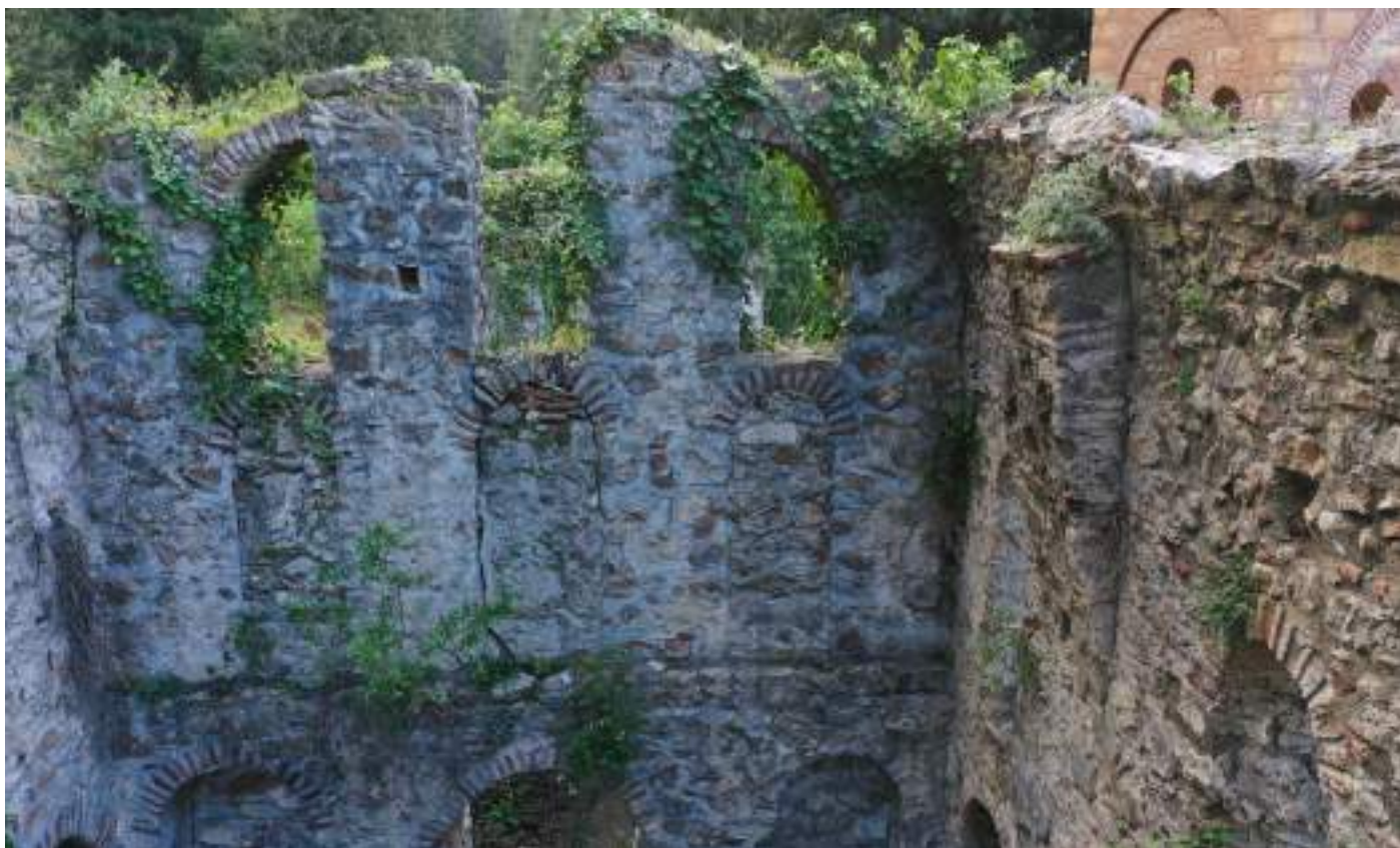
Εικόνα 106: Άποψη από το εσωτερικό της Τραπέζης της Μ. Βροντοχίου, όπου διακρίνεται η τοξωτή απόληξη της στενής πλευράς του κτίσματος, 2022.
