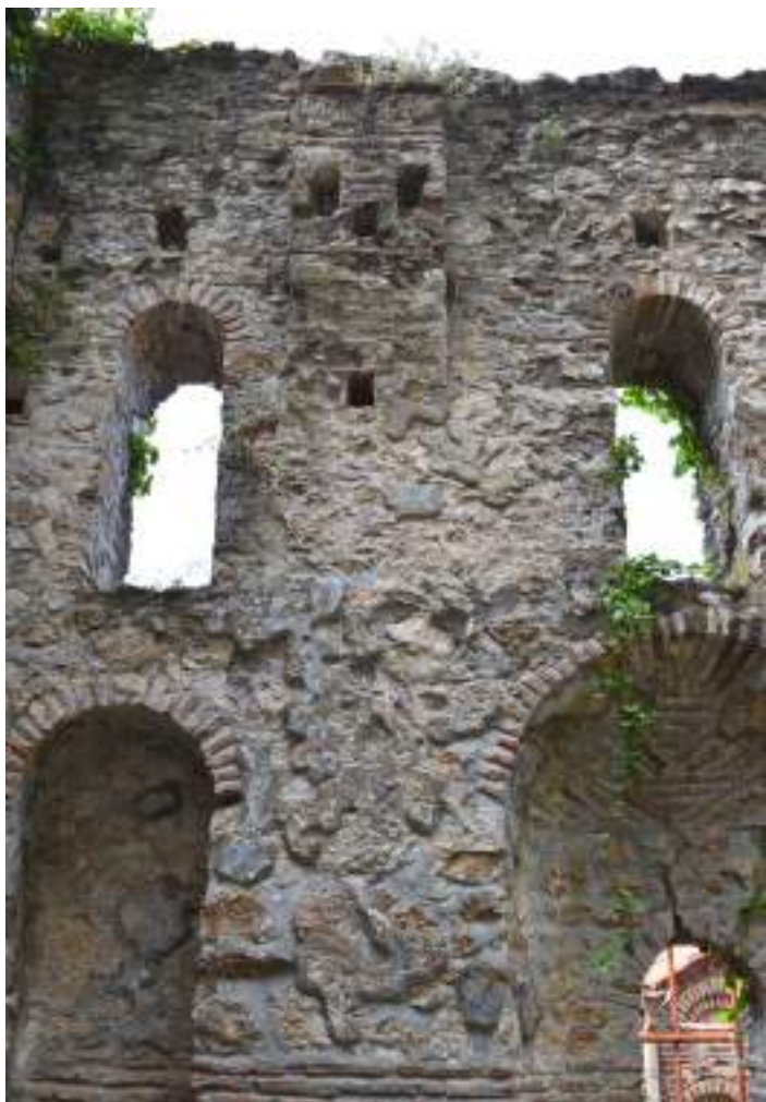
Εικόνα 63: Η εσωτερική τοιχοποιία της Τραπεζίς της Μ. Βροντοχίου με σπαράγματα τοιχογραφιών, 2022.
