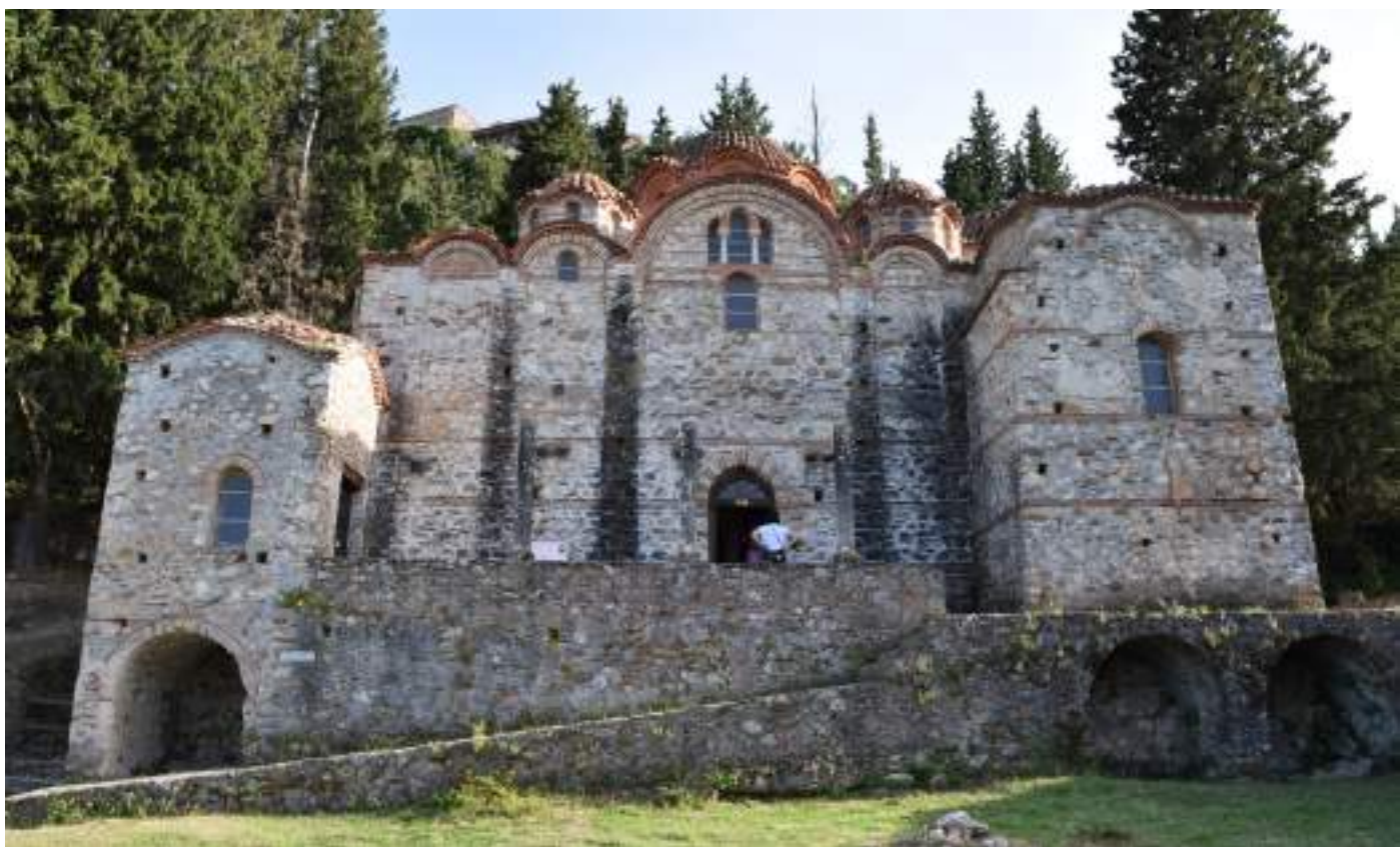
Εικόνα 47: Η βόρεια όψη του αναστηλωμένου Καθολικού της Μ. Βροντοχίου, 2018.
