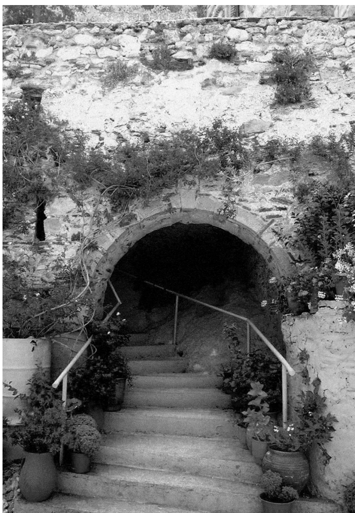
Εικόνα 44: Κλίμακα που συνδέει το επίπεδο του Καθολικού με το επίπεδο των βοηθητικών κτισμάτων της Μ. Παντανάσσης, 2009.
