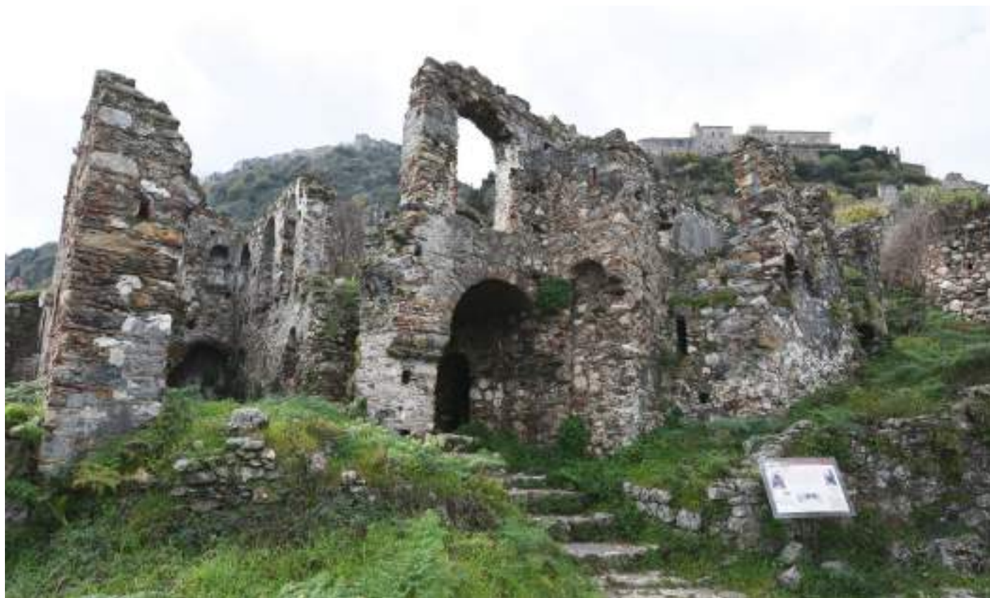
Εικόνα 88: Κάτω Χώρα Μυστρά. Συγκρότημα κατοικιών όπου διαμορφώνεται διαβατικό στην ισόγεια στάθμη, από όπου περνάει η κεντρική οδική αρτηρία του οικισμού, 2022.
