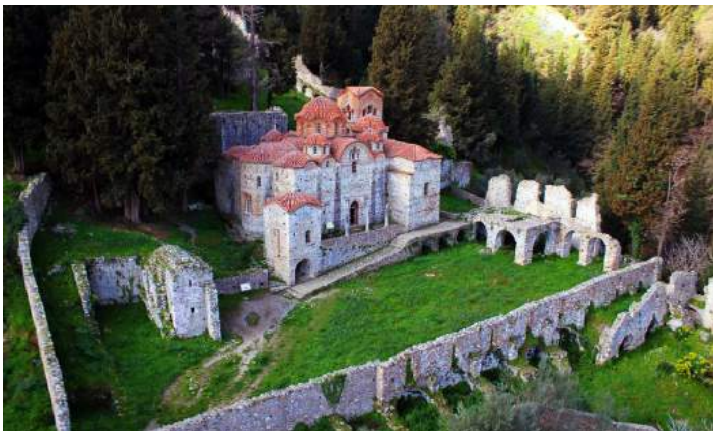
Εικόνα 99: Γενική άποψη της Οδηγήτριας από τα βορειοανατολικά και των βοηθητικών κτισμάτων που την περιβάλλουν.
