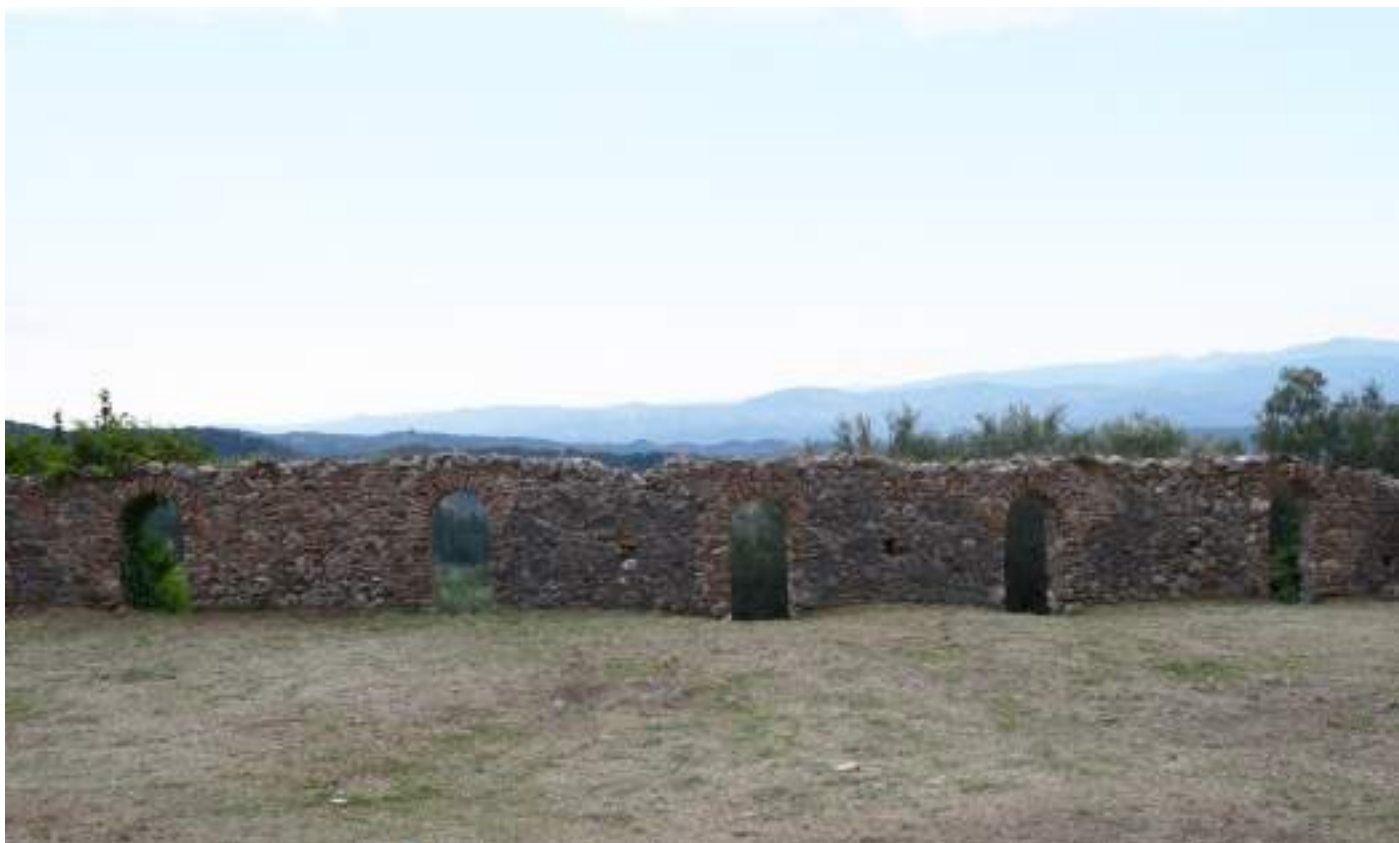
Εικόνα 53: Τμήμα της νότιας όψης της βόρειας πτέρυγας των κελιών της Μ. Βροντοχίου, 2022.
