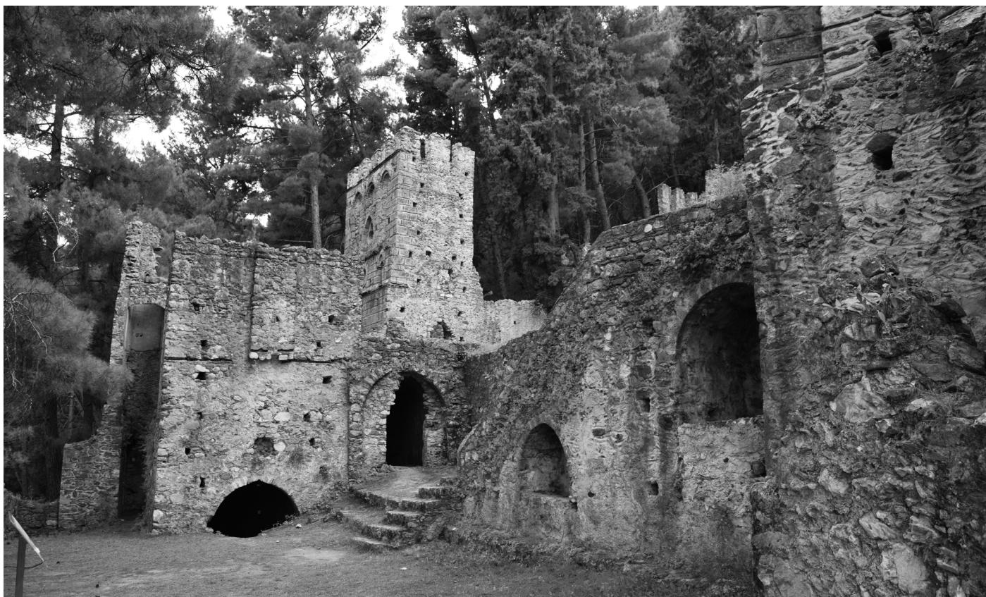
Εικόνα 40: Ο πύργος και άλλα βοηθητικά κτίσματα της Μ. Περιβλέπτου, 2018.
