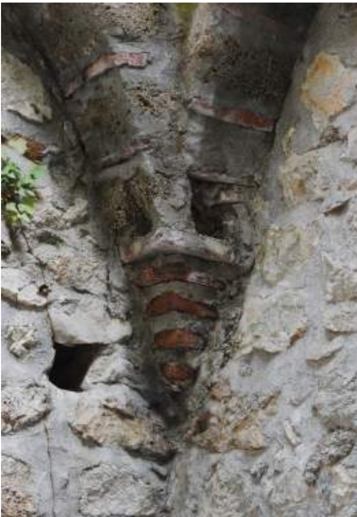
Εικόνα 68: Κάθε κιλίβαντας στις εσωτερικές γωνίες της Εστίας της Μ. Βροντοχίου στηρίζει δυο τόξα, 2022.
