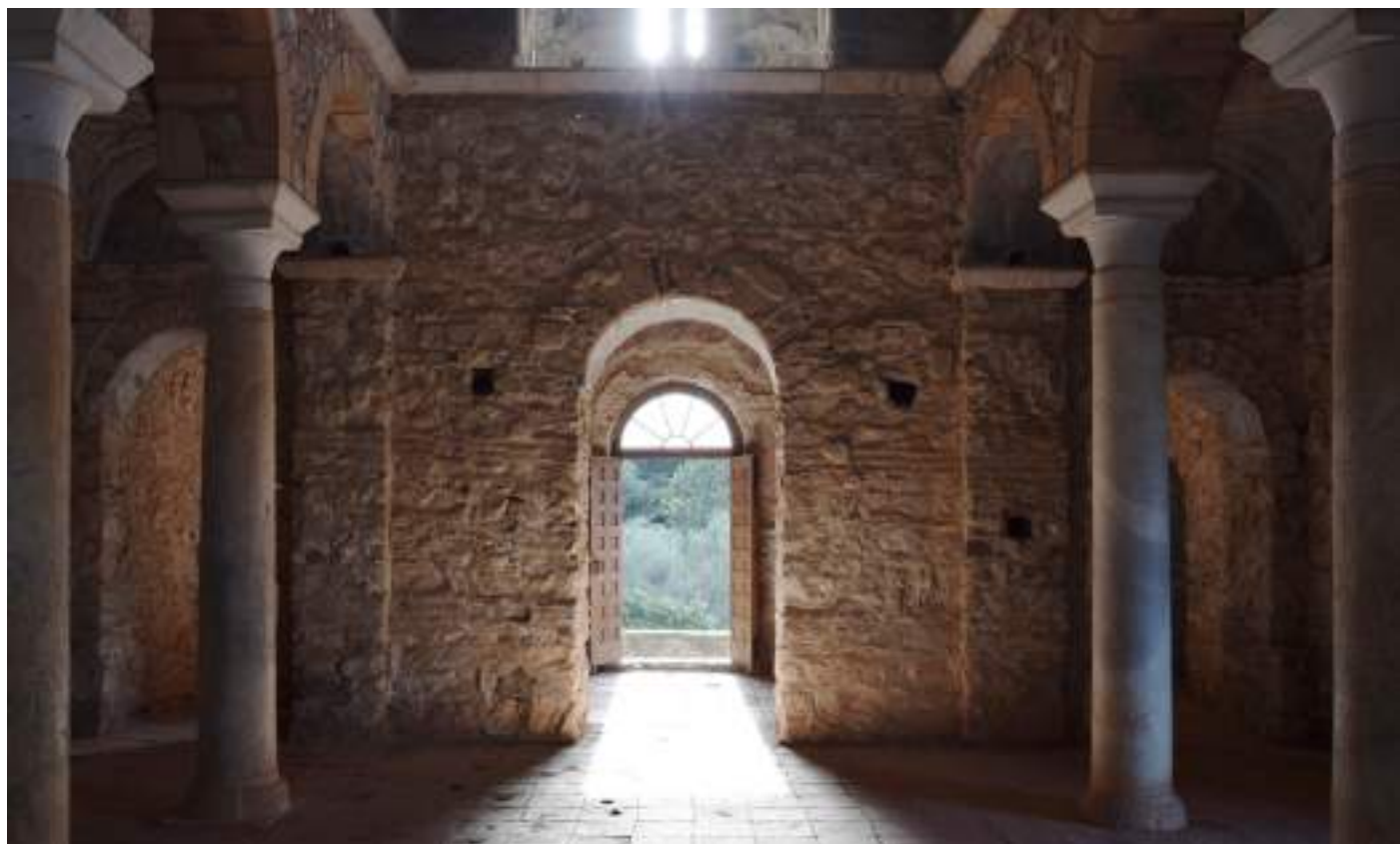
Εικόνα 87: Εσωτερική άποψη του αναστηλωμένου Καθολικού της Μ. Βροντοχίου, 2018.
