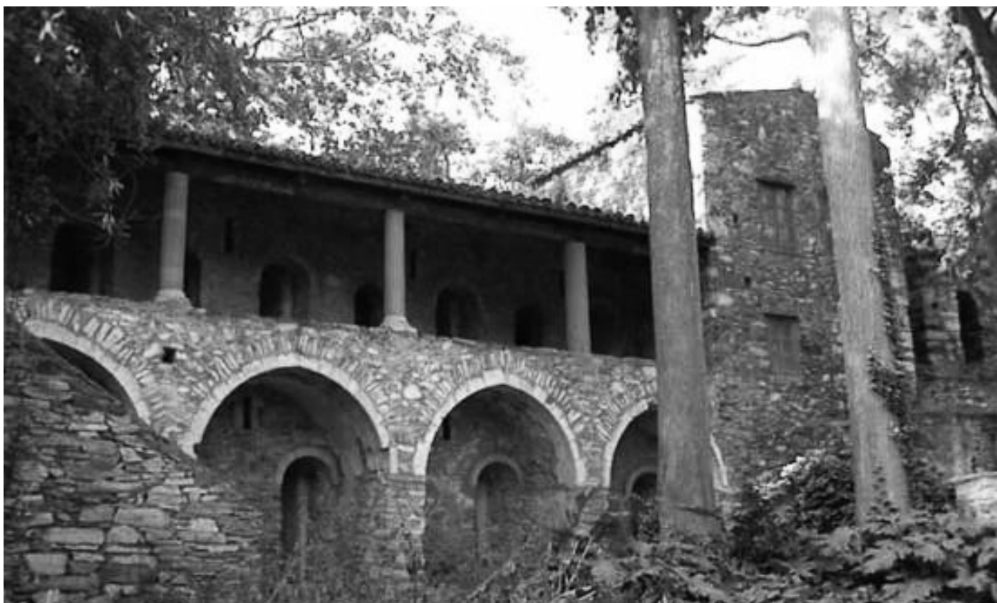
Εικόνα 32: Άποψη της διάροφης μεταβυζαντινής πτέρυγας κελιών, στην νότια πλευρά του περιβόλου της Μ. Καισαριανής. Στο ισόγειο αναπτύσσεται ένα ενιαίο τοξωτό προστώο και στον όροφο η στέγη στηρίζεται σε μαρμάρινους κίονες.
