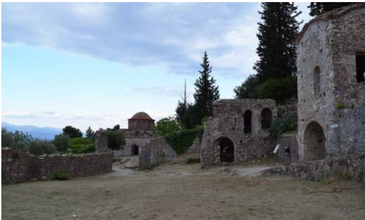
Εικόνα 62: Η θέαση του ναού των Αγίων Θεοδώρων από τον περίβολο μπροστά στον ναό της Οδηγήτριας, 2022.
