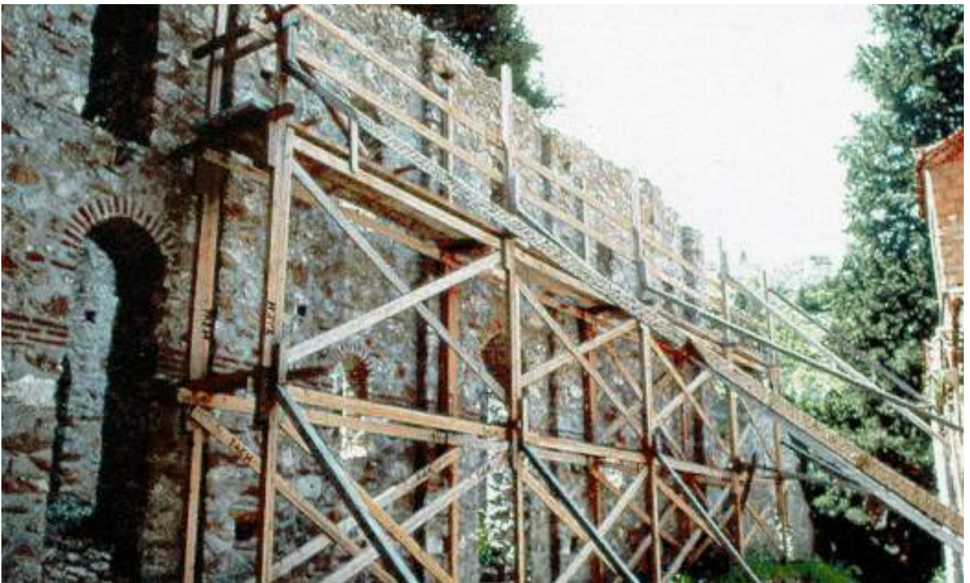
Εικόνα 70: Εργασίες συντήρησης και στερεώσεων της τοιχοποιίας της Τραπέζης της Μ. Βροντοχίου, 1998.
