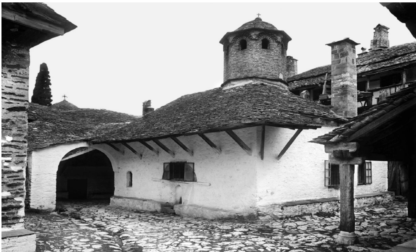
Εικόνα 34: Άποψη της εστίας της Μ. Μεγίστης Λαύρας Αγίου Όρους, όπου διακρίνεται το προστέγασμα επί ξύλινων αντηρίδων, 2014.
