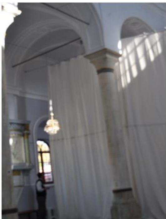
Εικ. 40: Εσωτερικό ναού Εισοδίων Θεοτόκου
