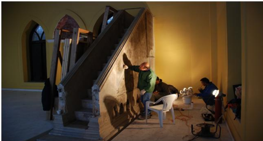
Εικ. 11: Επισκευαστικές εργασίες στο εσωτερικό του τεμένους Μετζητιέ
