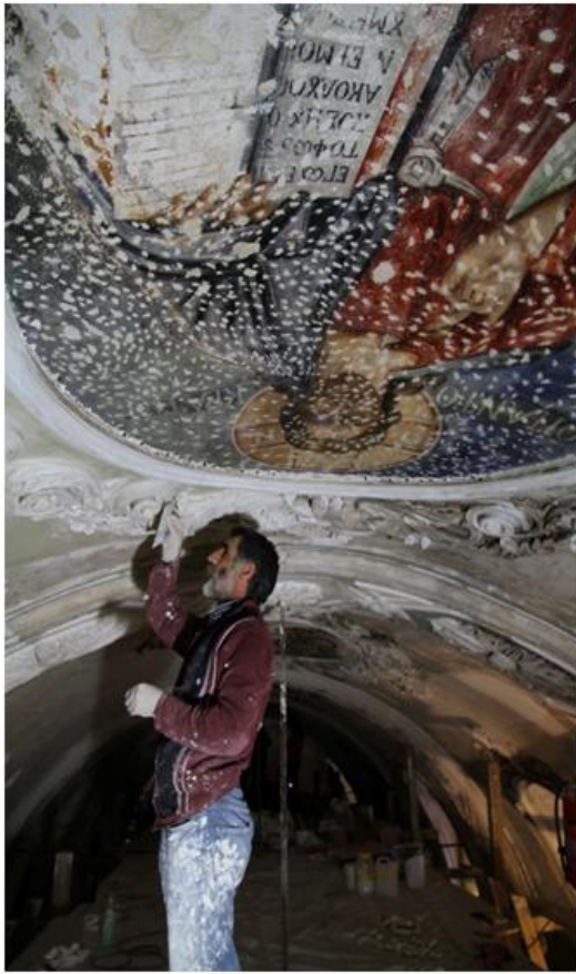
Εικ. 26: Εργασίες αποκατάστασης στον ναό
