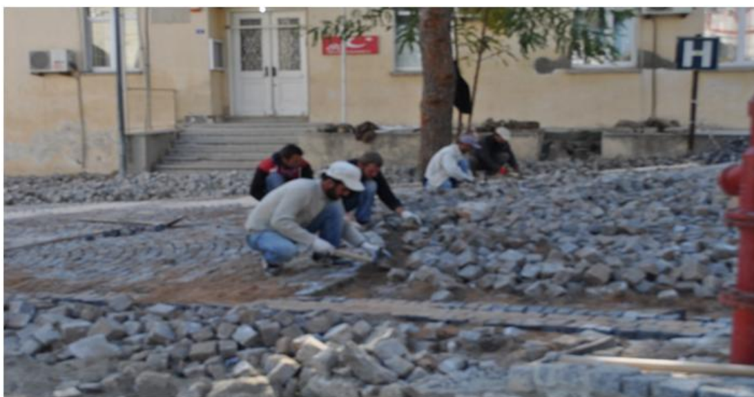
Εικ. 39: Συντήρηση βοτσαλωτού στον προαύλιο χώρο του ναού των Εισοδίων της Θεοτόκου
