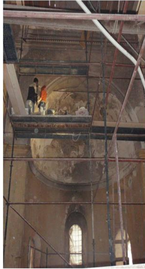
Εικ. 27: Εργασίες αποκατάστασης
