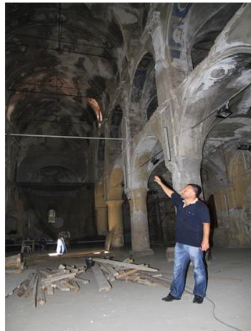
Εικ. 25: Εργασίες στο εσωτερικό του ναού
