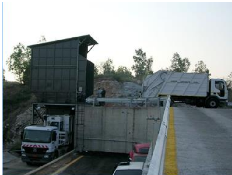
Εικόνα 5.4 - Κινητός ΣΜΑ Ελευσίνας για βιοαποδομήσιμα οικιακά απόβλητα
