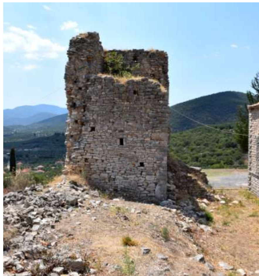
Εικ. 149. Πολίχνη. Κάστρο. Νοτιοδυτικός πύργος.
