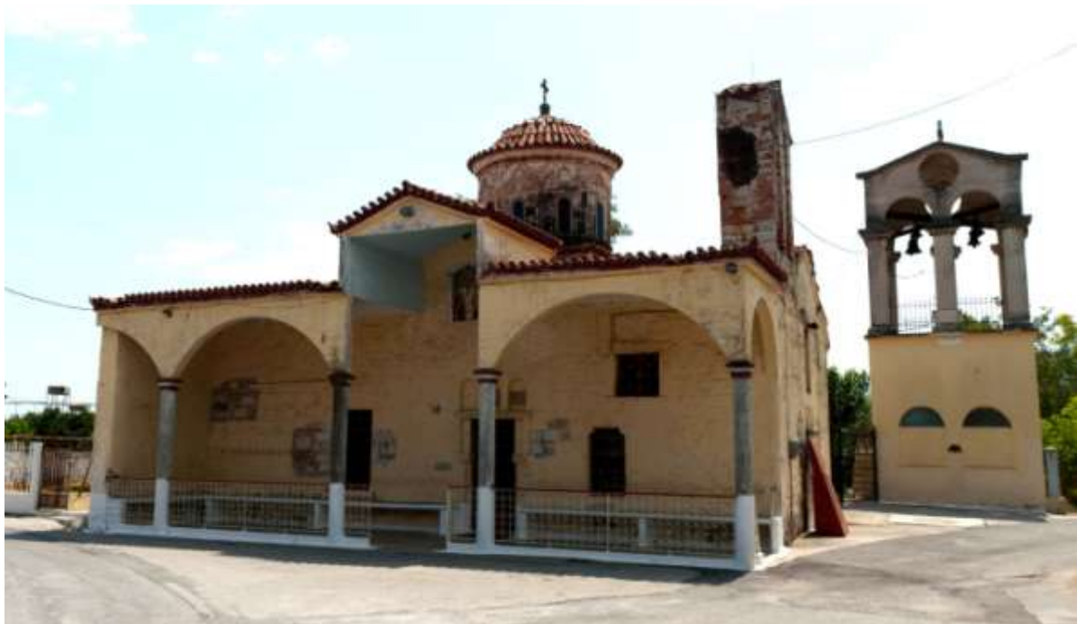
Εικ. 79. Σπάρτη. Καλογωνιά. Ναός Αγίου Νικολάου. Βόρεια όψη.
