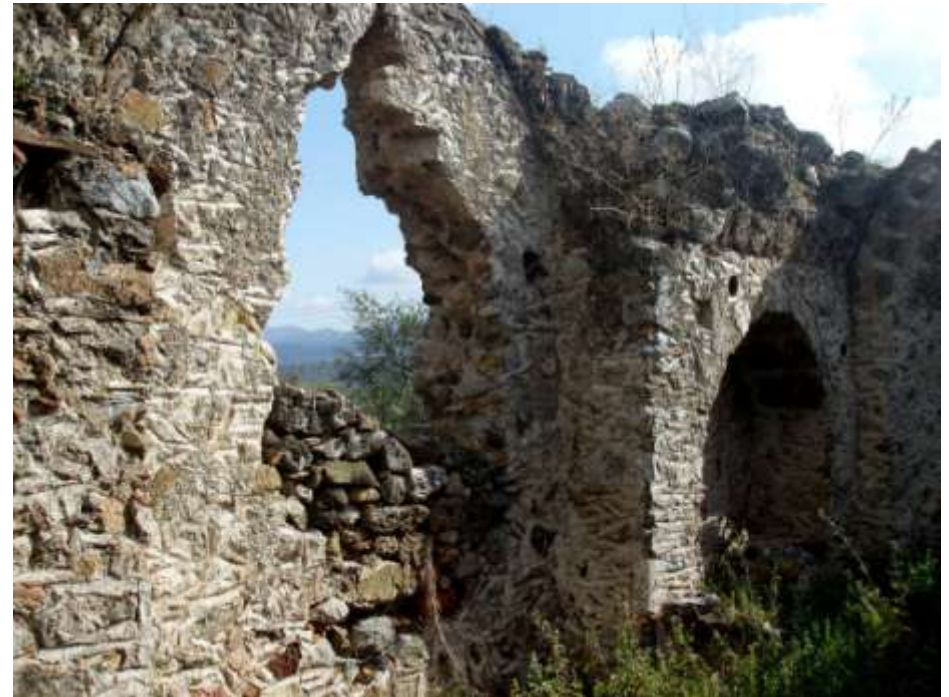
Εικ. 124. Απιδιά. Ναός Αγίου Βασιλείου. Κεντρικό και ανατολικό τυφλό αψίδωμα βόρειου τοίχου.
