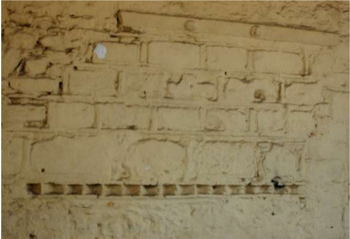
Εικ. 85. Σπάρτη. Καλογωνιά. Ναός Αγίου Νικολάου. Βόρεια όψη (λεπτομ.), εφαρμογή του πλινθοπερίκλειστου συστήματος δομής.
