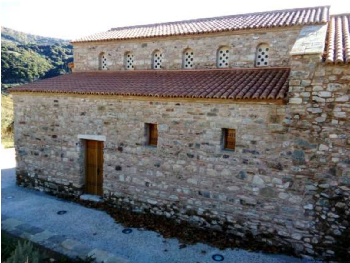
Εικ. 170. Νέα Φιγάλεια. Θέση Μοναστήρι. Ναός Κοίμησης της Θεοτόκου. Βόρεια όψη.
