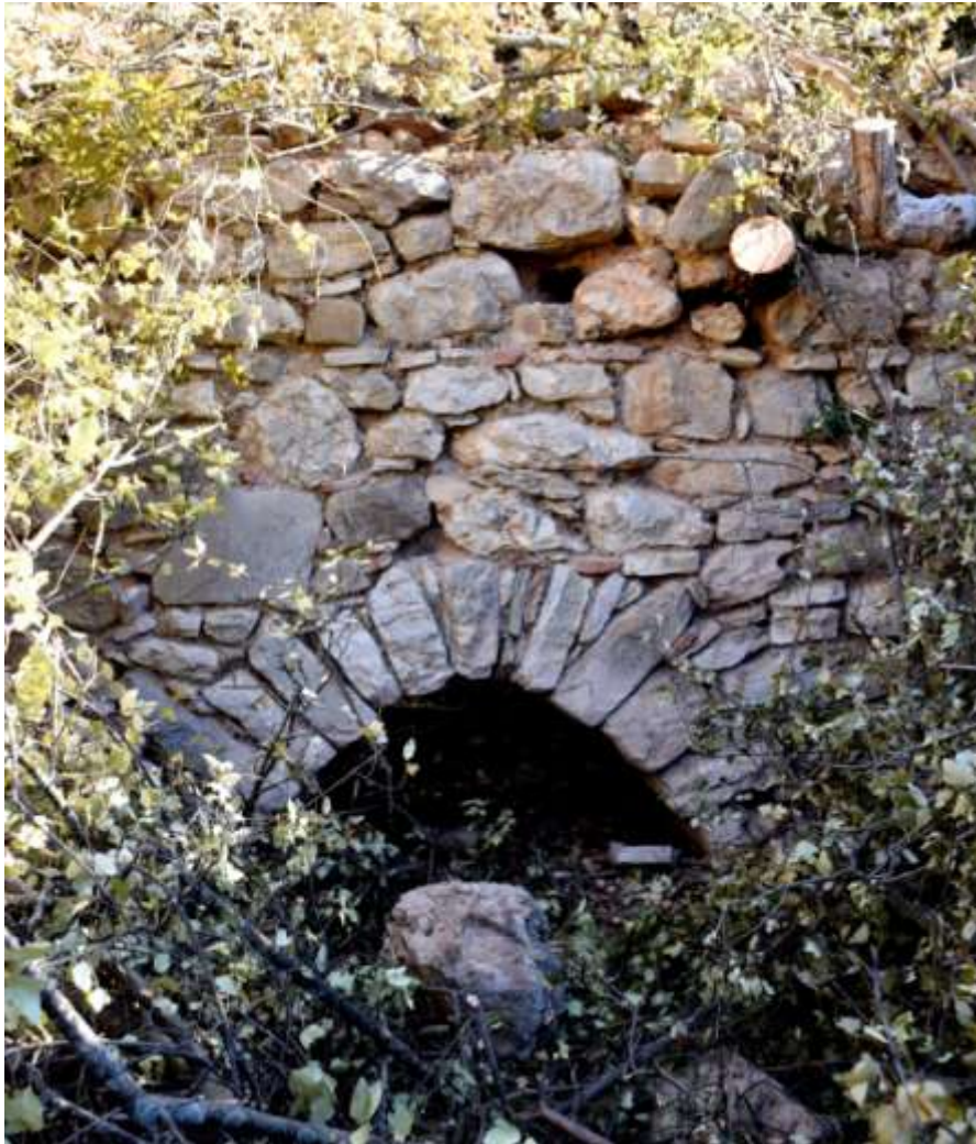
Εικ. 136. Αχλαδόκαμπος. Θέση Παλιόμυλος. Υδρόμυλος. Νότια όψη. Άνοιγμα απορροής υδάτων.
