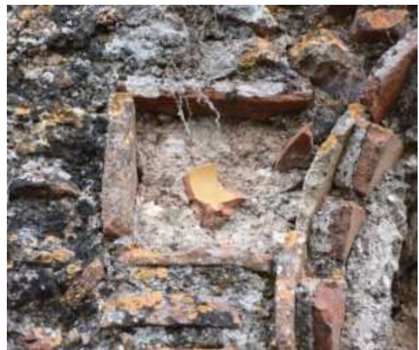
Εικ. 122. Απιδιά. Ναός Αγίου Βασιλείου. Βόρεια όψη (λεπτομ.), υποδοχή πλινθοπερίκλειστου αγγείου αριστερά του βορείου παραθύρου.
