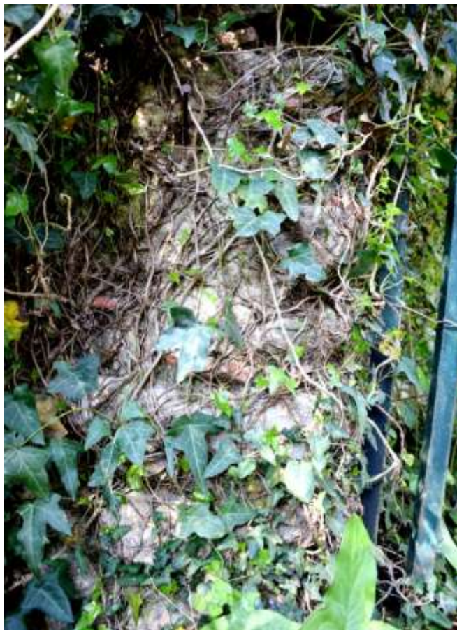
Εικ. 73.β. Κλαδάς. Θέση Βαρδούκα. Μεταβυζαντινός υδρόμυλος. Τμήμα της τοιχοποιίας με σποραδική χρήση πλίνθων στους αρμούς.
