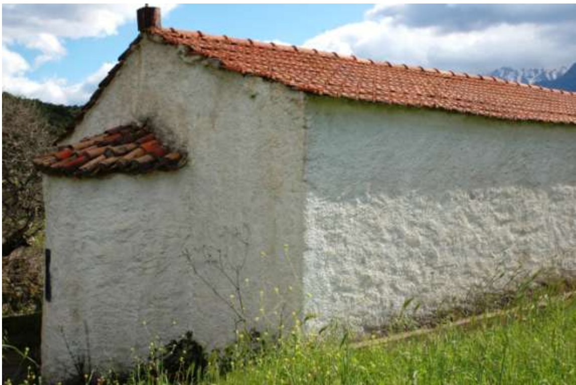
Εικ. 95. Καραβάς. Θέση Αγραπιδούλα (Μιτάτοβα). Ναός Αγίας Σολομονής.
