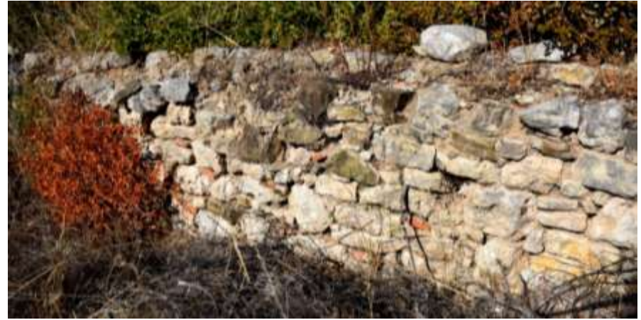
Εικ. 140. Αχλαδόκαμπος. Θέση Παλιόμυλος. Υδρόμυλος, τοίχιο έδρασης υδαταγωγού (υδραγωγείο).
