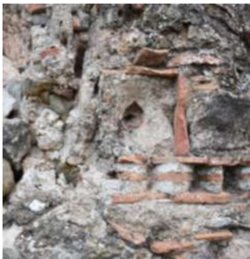
Εικ. 121. Απιδιά. Ναός Αγίου Βασιλείου. Ανατολική όψη (λεπτομ.), υποδοχή πλινθοπερίκλειστου αγγείου δεξιά της φωτιστικής θυρίδας της αψίδας.
