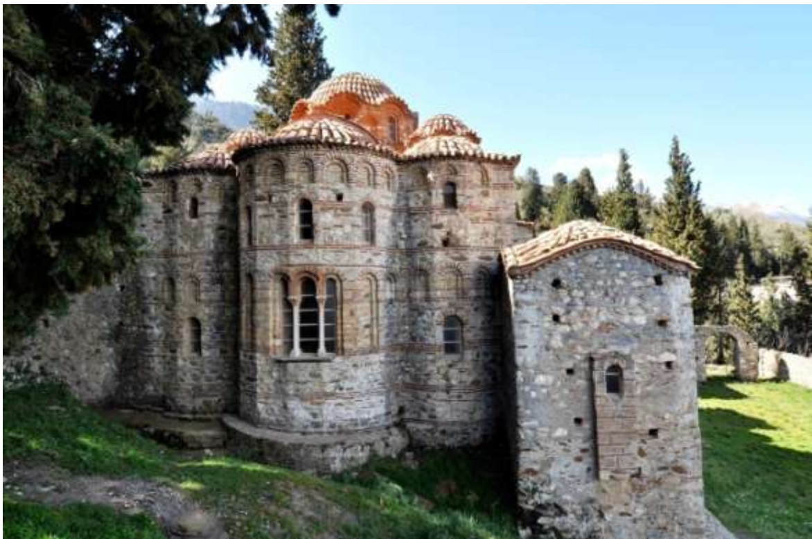
Εικ. 8. Αρχαιολογικός χώρος Μυστρά. Ναός Οδηγήτριας (Αφεντικό). Ανατολική όψη.
