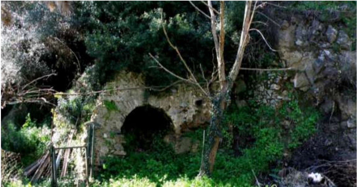
Εικ. 73.α. Κλαδάς. Θέση Βαρδούκα. Μεταβυζαντινός υδρόμυλος. Άνοιγμα απορροής υδάτων.
