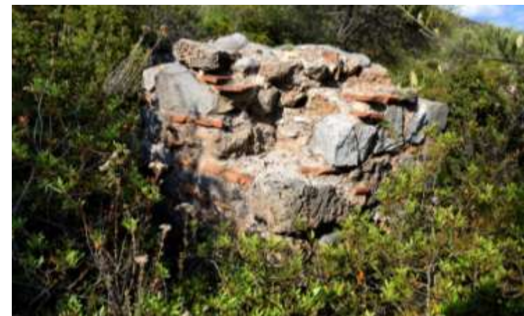
Εικ. 112. Απιδιά. Θέση Πριπίφτη. Ναός Ελεούσας. Τμήμα της τοιχοποιίας..
