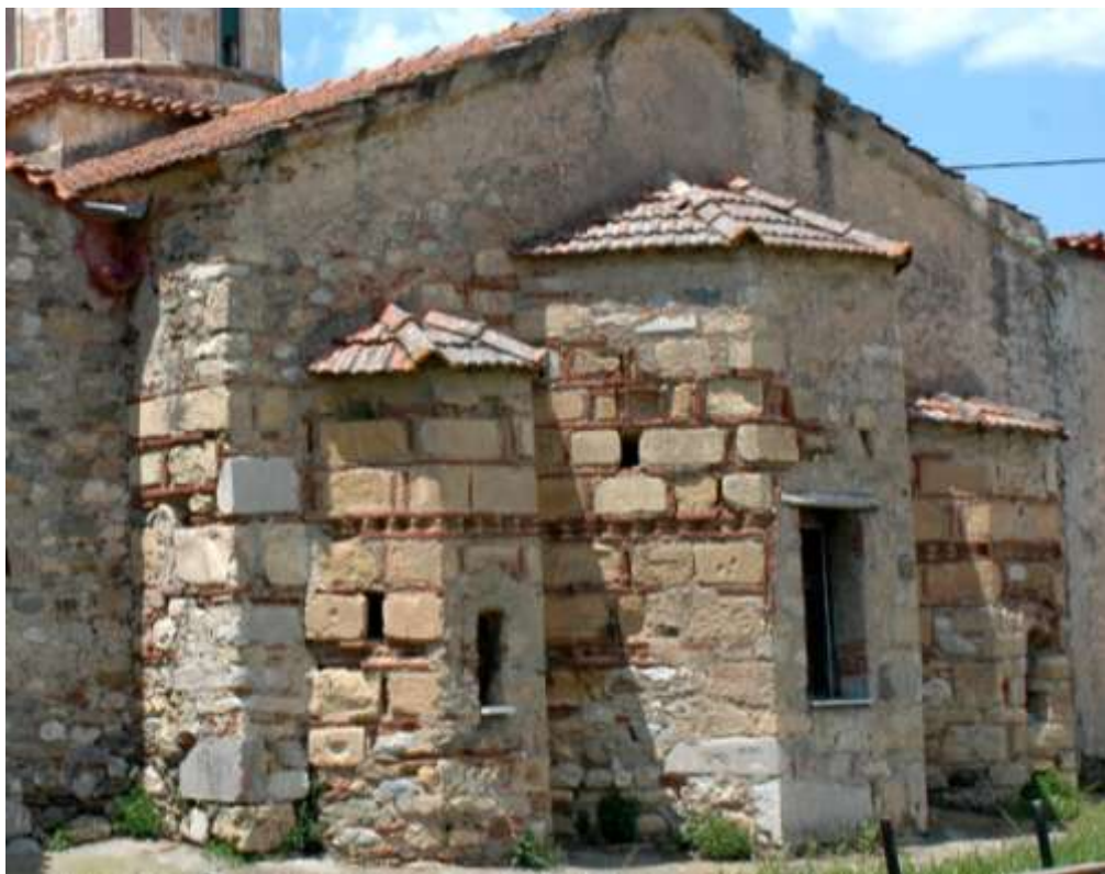
88. Σπάρτη. Καλογωνιά. Ναός Αγίου Νικολάου. Ανατολική όψη και τμήμα της νότιας.
