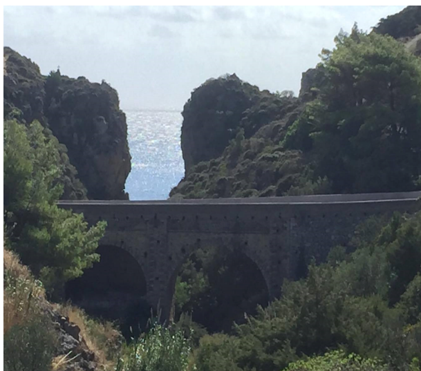
Εικόνα 41: : Γέφυρα στο φαράγγι - ρεματιά Σπαραγαρίου
