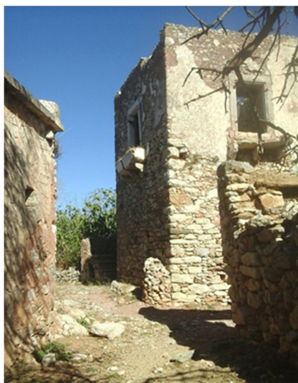
Εικόνα 58: Περιβολίστρες, Κάστρο Μυλοποτάμου
