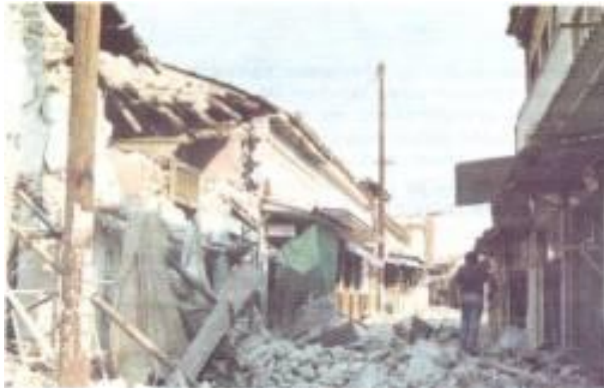
Εικ.134 Καταστροφές στο ιστορικό κέντρο.
