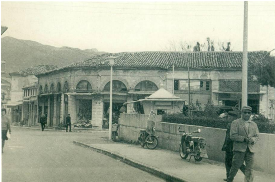
Εικ. 88 Το Αρχοντικό Μαυρομιχάλη στη θέση του Πύργου Μπενάκη, που είχε καταστραφεί στα Ορλωφικά. Κατεδαφίστηκε το 1972.
