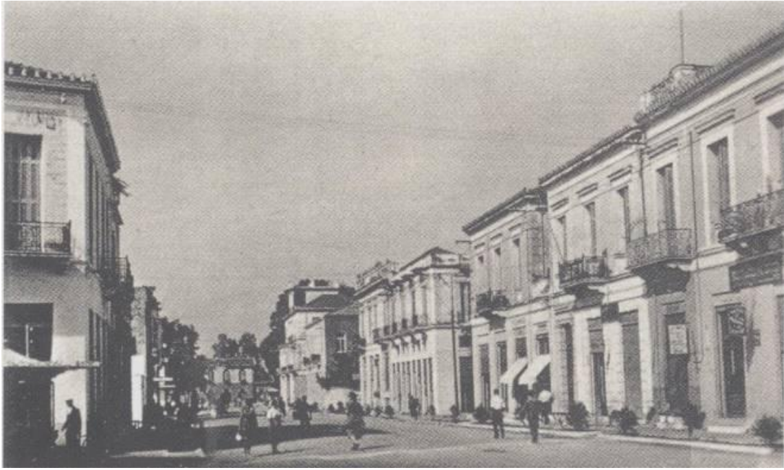
Εικ.170α Λεωφόρος Σταθμού Σ.Π.Α.Π., 1937.
