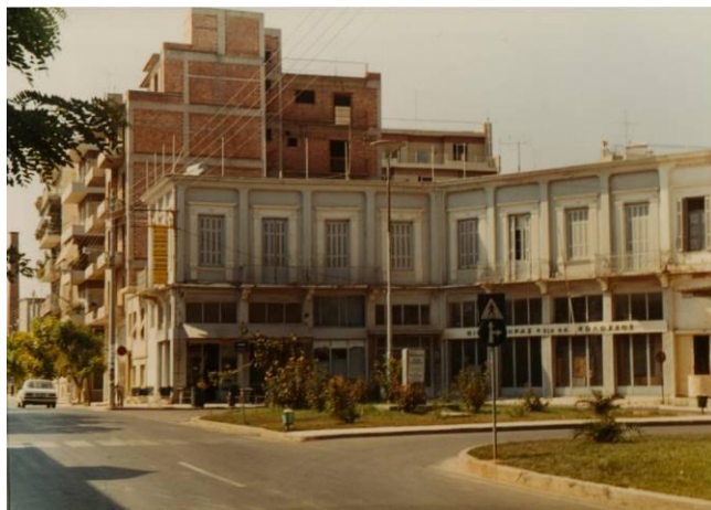
Εικ. 106β Κτήριο του όψιμου κλασικισμού, στο οποίο έχει γίνει και χρήση μετόν.
