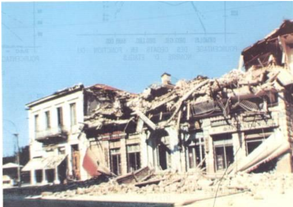
Εικ.132 Καταστροφές κτηρίων στο κέντρο της πόλης.
