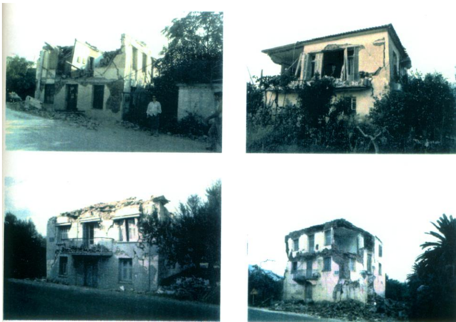
Εικ.141α Καταρρεύσεις – βλάβες διαφόρων οικιών από φέρουσα τοιχοποιία.
