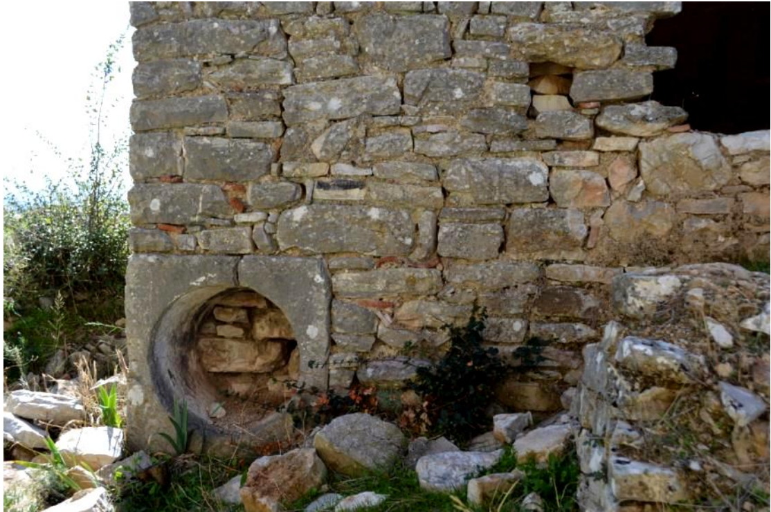
Εικ. 135β Πολίχνη. Κάστρο Αρχαγγέλου. Λίθινο στόμιο πηγαδιού εντοιχισμένο στην κάτω δεξιά γωνία του ορθογώνιου πύργου.
