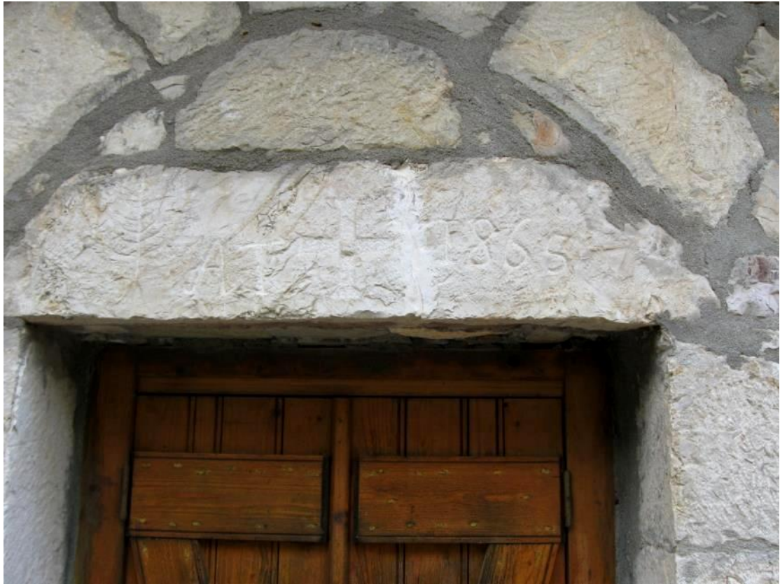
Εικ. 139γ Κωνσταντίνοι. Υπέρθυρο με τα σημάδια του λαϊκού τεχνίτη και τη χρονολογία κατασκευής, ενσωματωμένο πάνω από το παράθυρο νεώτερης πετρόκτιστης κατοικίας.
