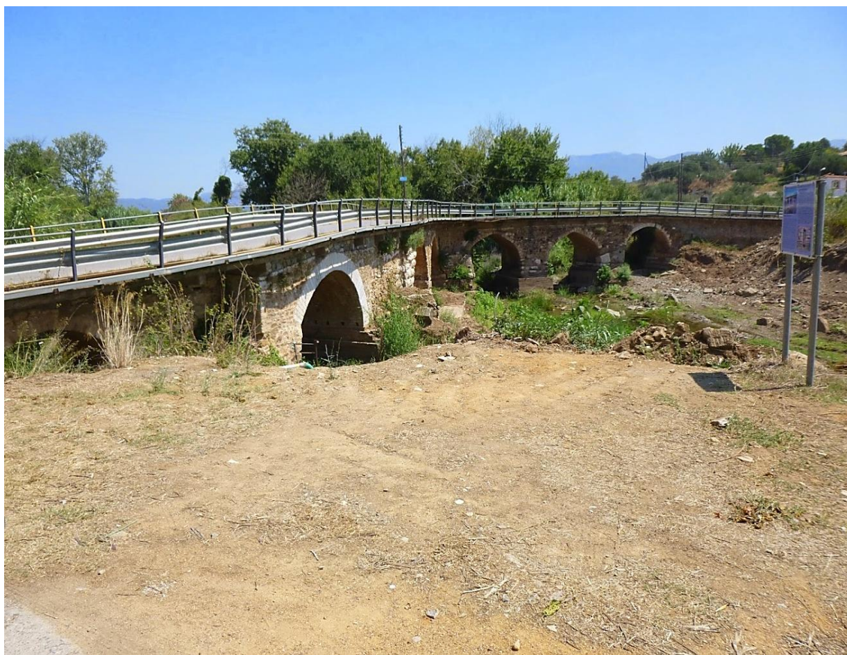
Εικ. 88 Νεοχώριον Ιθώμης. Άλλη όψη του γεφυριού.
