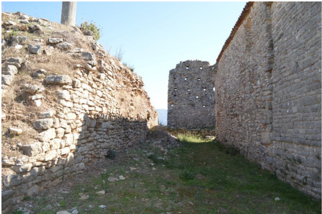
Εικ. 134α Πολίχνη. Κάστρο Αρχαγγέλου. Τμήμα του εξωτερικού περιβόλου του στην ανατ. πλευρά.
