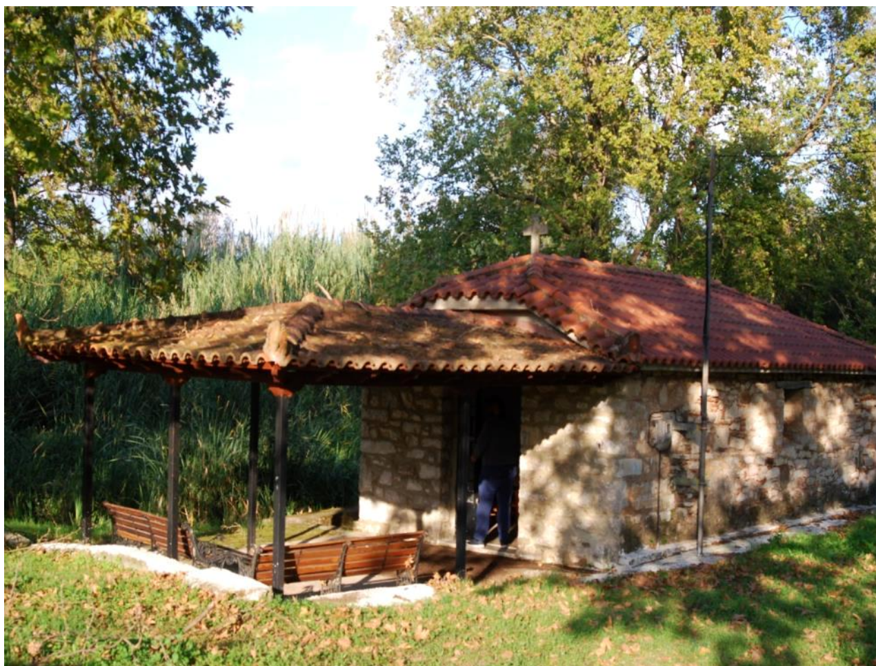
Εικ. 38 Στενούκλαρος (τ. Αλιτούργι). Εκκλησία του Αγ. Ι. Προδρόμου.
