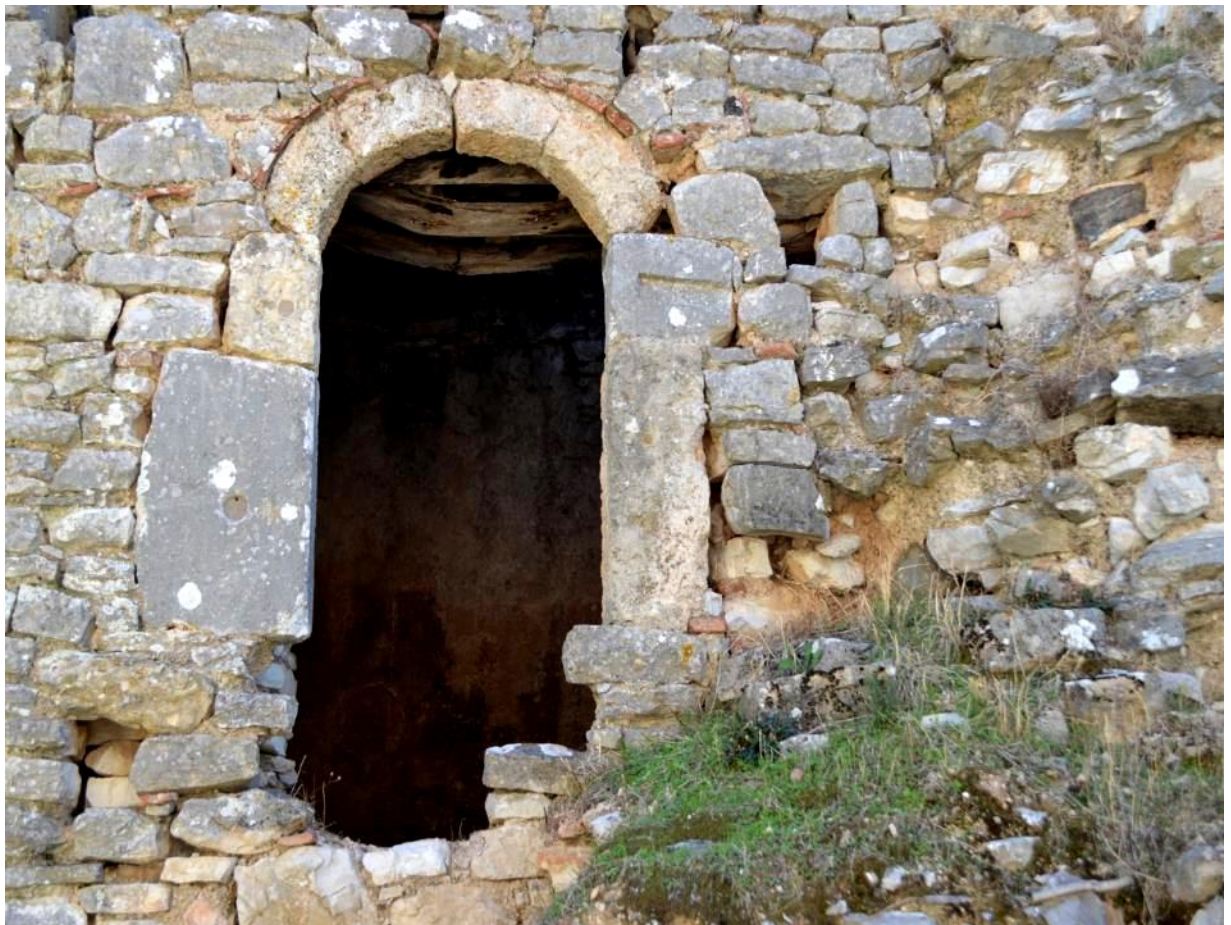
Εικ. 135α Πολίχνη. Κάστρο Αρχαγγέλου. Λεπτομέρεια από τον ορθογώνιο πύργο στη νότια πλευρά με εντοιχισμένο αρχαίο υλικό.
