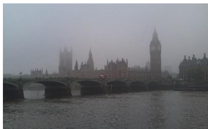
Εικόνα 2.2 Η γέφυρα του Ουέστμινστερ με το ομώνυμο ανάκτορο και τον πύργο του Μπιγκ Μπεν στο βάθος
