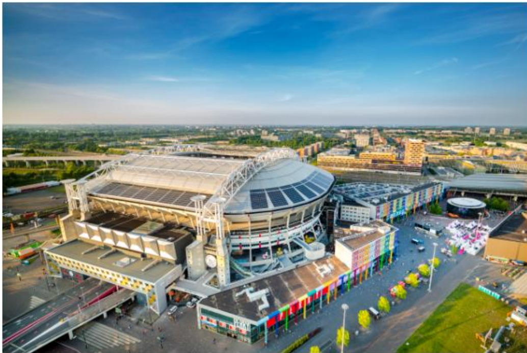
Εικόνα 2. Γήπεδο Άγιαξ εξωτερικά
