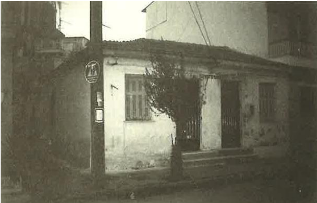
Εικ. 5: Α΄ προσφυγικός συνοικισμός, οδός Σμύρνης. Πηγή: Μαρινέλλης Λ. Χ., ό. π. , σ. 194
