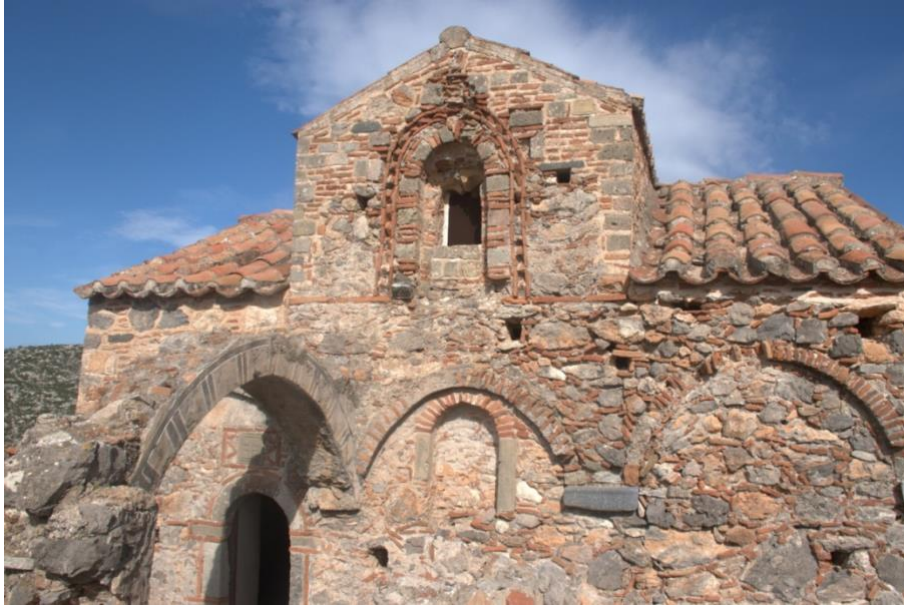
Εικόνα 36: Αγία Παρασκευή, νότια όψη
