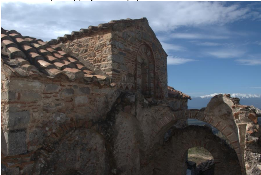
Εικόνα 34; Αγία Παρασκευή, βόρεια όψη
