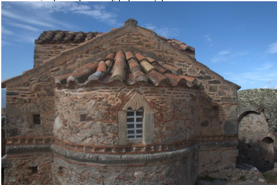
Εικόνα 35: Αγία Παρασκευή, η εξωτερική πλευρά της κόγχης
