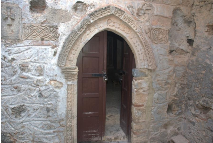
Εικόνα 46: Ζωοδόχος Πηγή, δυτική όψη, η θύρα εισόδου
