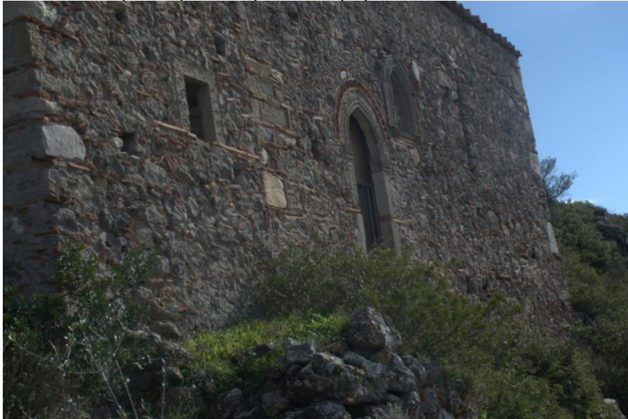
Εικόνα 45: Ζωοδόχος Πηγή, νότια όψη
