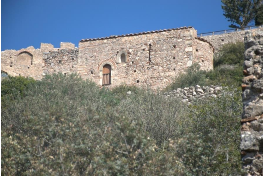
Εικόνα 19: Ζωοδόχος Πηγή, νότια όψη
