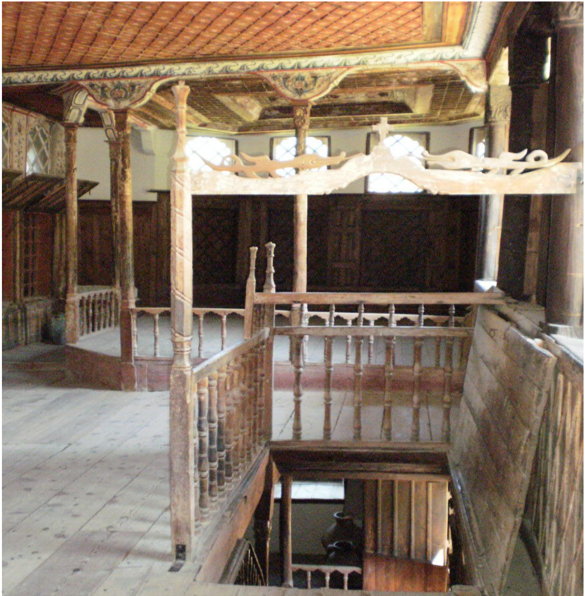
Εικ. 75 Σκάλα που οδηγεί στο ξάνογο. Η καταπακτή απομονώνει τους δύο ορόφους
