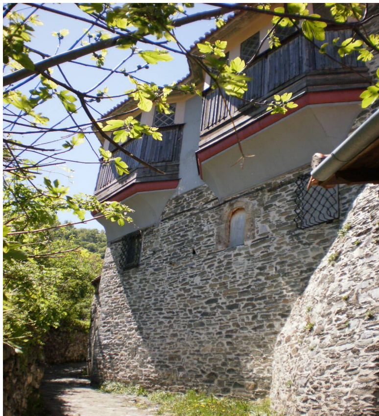
Εικ. 33 Ανατολική πλευρά του Αρχοντικού του Γ. Σβαρτς χαρακτηριστική της οικοδομικής του 18 ου αι. με φρουριακή διαμόρφωση του ισογείου
