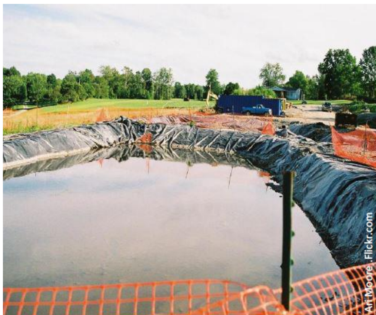
Εικόνα 7: Λύματα και επεξεργασμένα απόβλητα αποθηκεύονται σε ανοιχτές δεξαμενές
