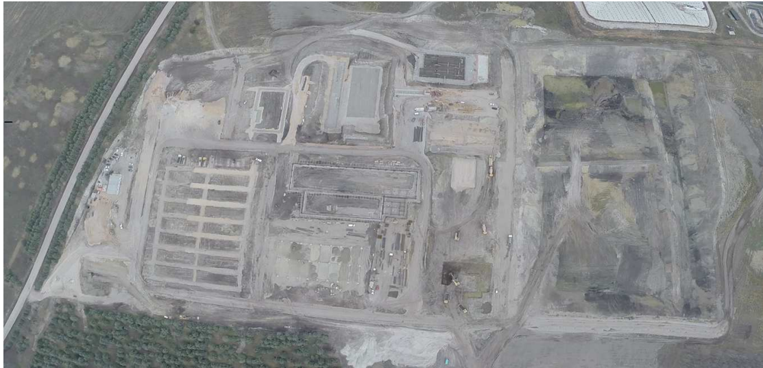
Εικόνα : 4.1.Εργασίες κατασκευής υποδομών του Ολοκληρωμένου Συστήματος Διαχείρισης Απορριμμάτων
