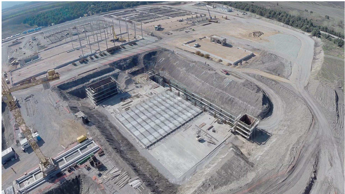
Εικόνα : 4.2 : Εργασίες κατασκευής υποδομών του Ολοκληρωμένου Συστήματος Διαχείρισης Απορριμμάτων
