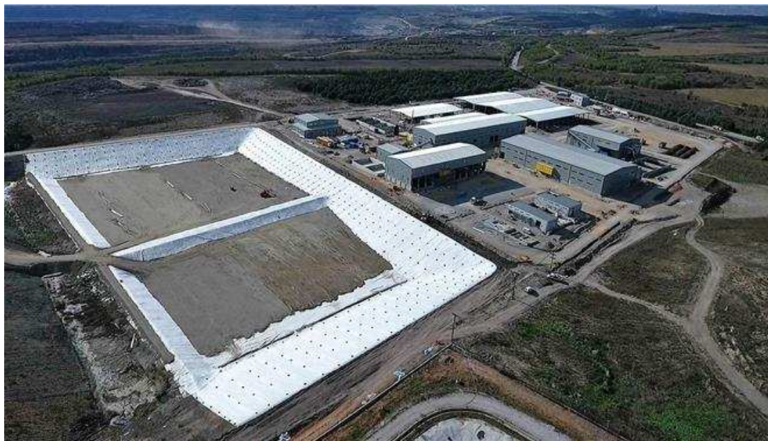
Εικόνα:4.4 Οι εγκαταστάσεις του Ολοκληρωμένου Συστήματος Διαχείρισης Απορριμμάτων
