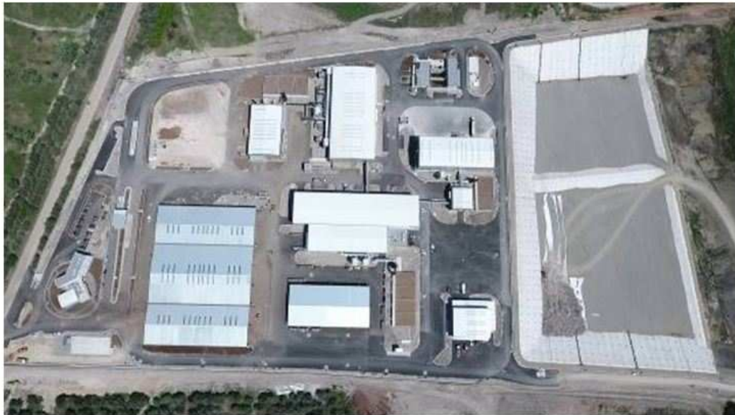
Εικόνα:4.3 Οι εγκαταστάσεις του Ολοκληρωμένου Συστήματος Διαχείρισης Απορριμμάτων
