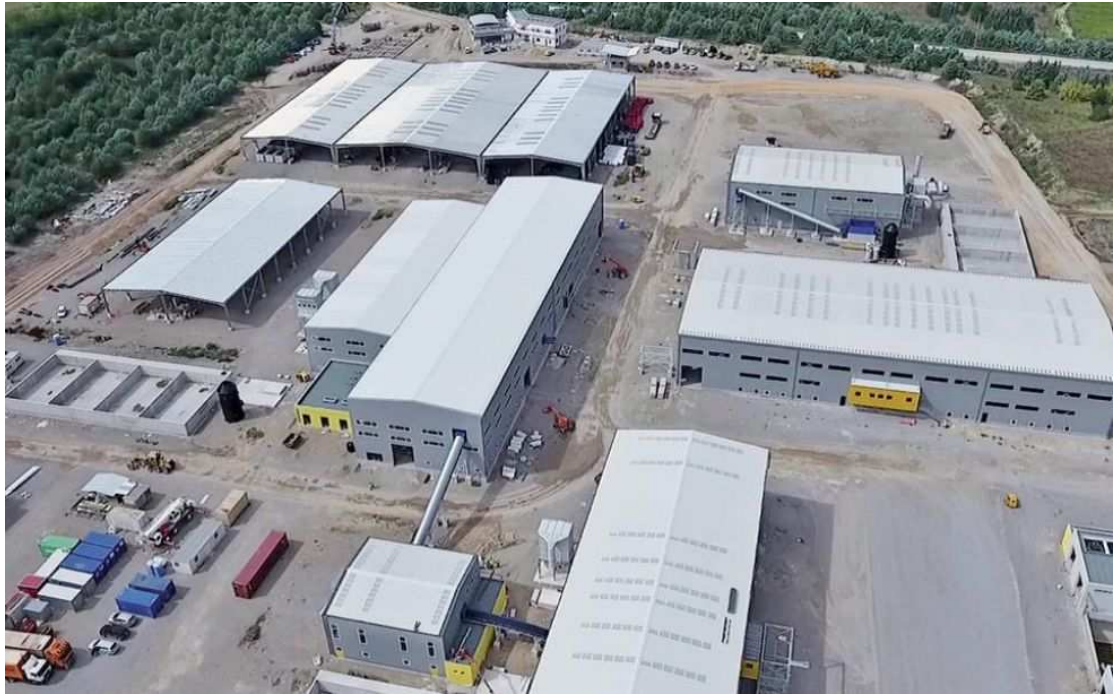
Εικόνα:4.5 Οι εγκαταστάσεις του Ολοκληρωμένου Συστήματος Διαχείρισης Απορριμμάτων
