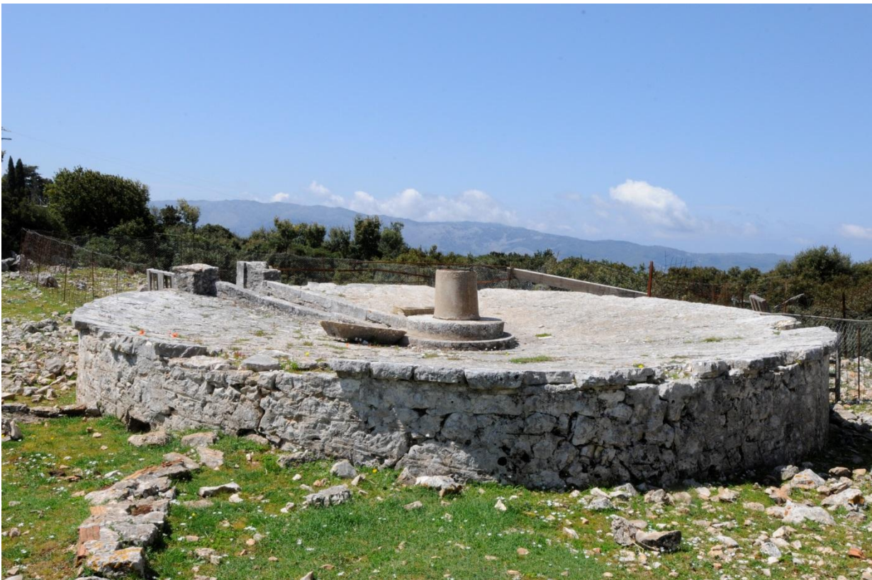
Εικ. 88. Στέρνα συλλογής βρόχινου νερού στην περιοχή Μονής Καθαρών Πηγή: Προσωπικό αρχείο
