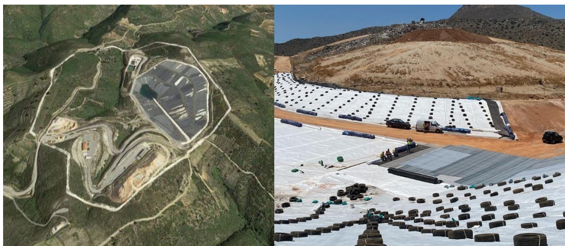
Εικόνα 6 : Κατασκευή νέου ΧΥΤΥ στα Χανιά – (Πηγή :www.greenagenda.gr, 2019)
