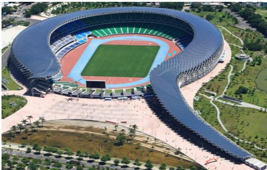
Εικόνα 2: Φωτοβολταϊκά εγκατεστημένα στην οροφή του Εθνικού Σταδίου «Kaohsiung» στην Ταιβάν
