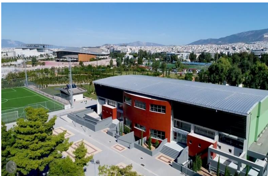
Εικόνα 7: Άποψη του κλειστού γυμναστηρίου «Σοφία Μπεφόν» και του περιβάλλοντος χώρου Πηγή https://observatory.sustainablegreece2020.com/
