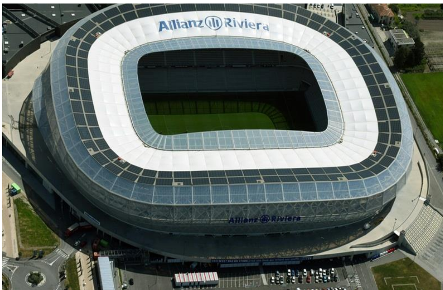
Εικόνα 6: Πανοραμική άποψη του «Allianz Riviera» και των φωτοβολταϊκών πάνελ στην οροφή του Πηγή: https://www.goalzz.com/
