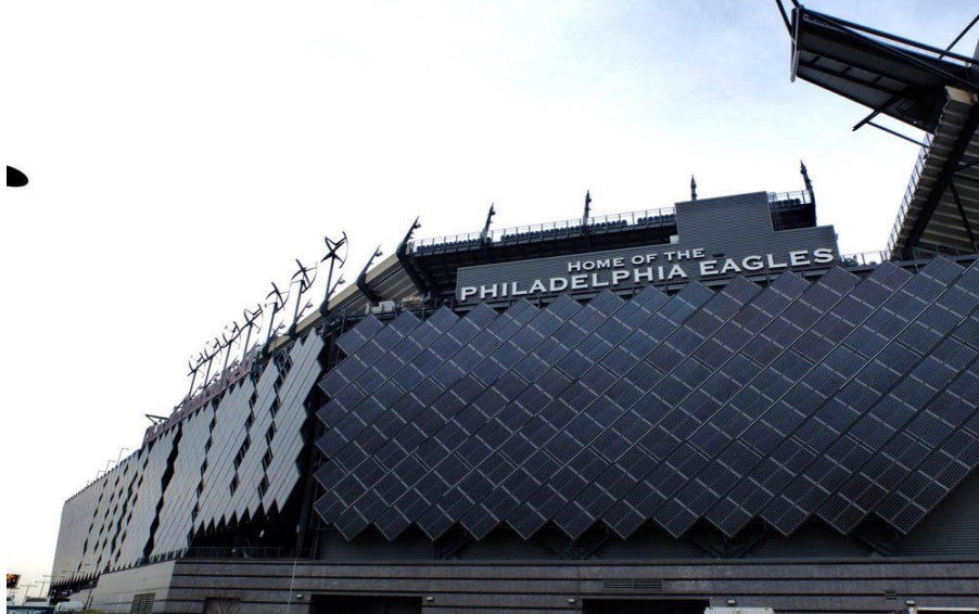
Εικόνα 5: Άποψη του «Lincoln Financial Field» όπου φαίνονται τα φωτοβολταϊκά και οι ανεμογεννήτριες Πηγή: http://stadiumdb.com/
