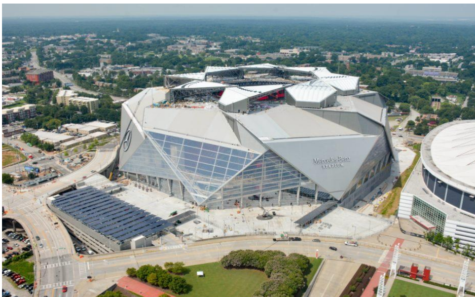
Εικόνα 4: Άποψη του «Mercedes-Benz Stadium» και των εγκατεστημένων φωτοβολταϊκών πάνελ Πηγή: http://stadiumdb.com/
