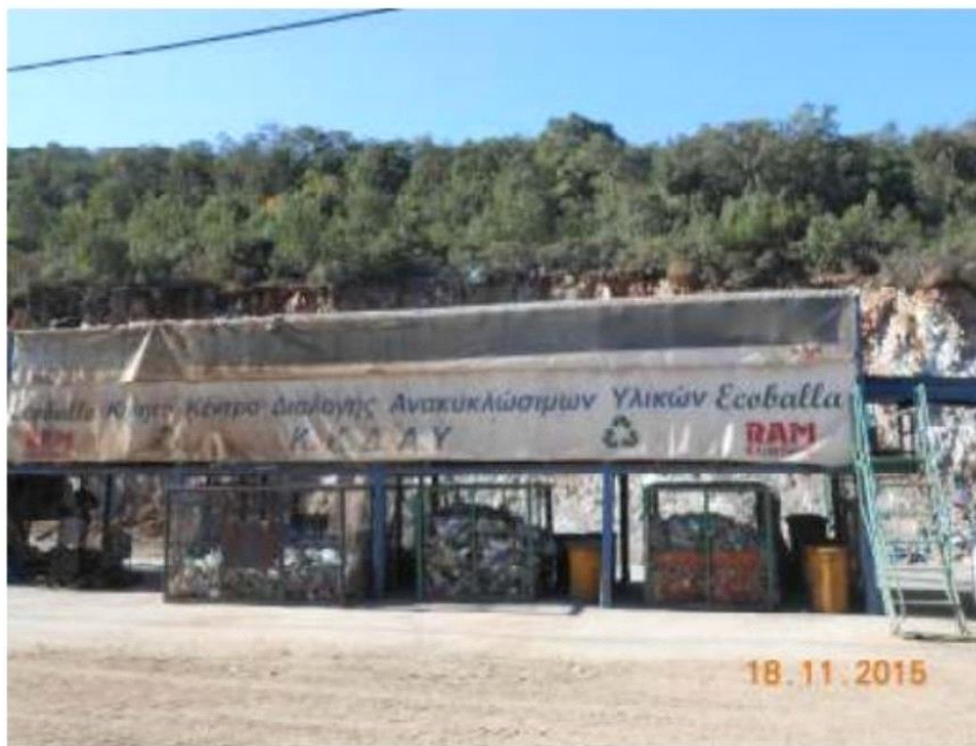
Ταινία χειροδιαλογής ανακυκλώσιμων υλικών (ΚΔΑΥ1)
