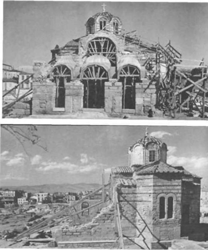
Από τις εργασίες αποκατάστασης της αρχικής μορφής του ναού (1954-1956).
