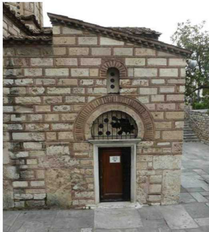
Η θύρα με το πεταλόμορφο τόξο στη βόρεια πλευρά του νάρθηκα (πρβλ. με την Καπνικαρέα).
