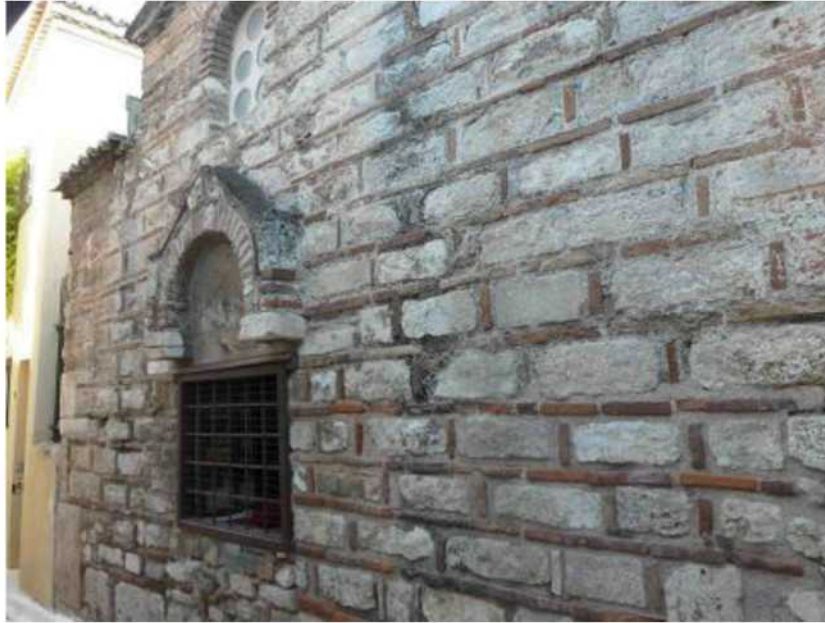
Η βόρεια πλευρά από τα Δ. Διακρίνεται η τοιχισμένη πλέον βόρεια είσοδος με το δεύτερο υπέρθυρο προσκυνητάρι του ναού.
