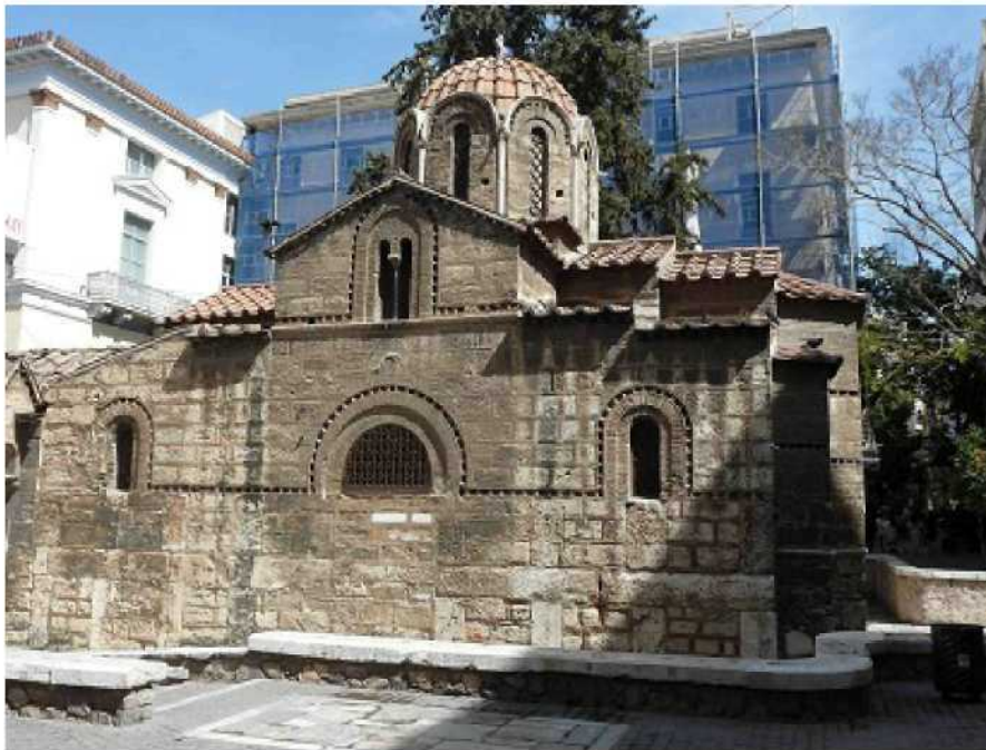
Καπνικαρέα, από τα Ν. Στη νότια κεραία του σταυρού διακρίνονται το πεταλόμορφο τόξο της χτισμένης πλέον εισόδου και ο μαρμάρινος κοσμήτης κάτω από το δίλοβο παράθυρο. Στο κάτω μέρος της τοιχοποιίας διακρίνονται οι λίθινοι σταυροί.
