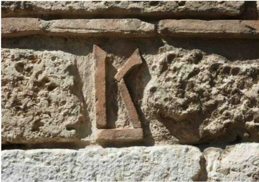
Λεπτομέρεια από την τοιχοποιία της βόρειας πλευράς. Μεμονωμένο εγχόρηγο κουφικό κόσμημα στη θέση κάθετου αρμού της τοιχοποιίας.
