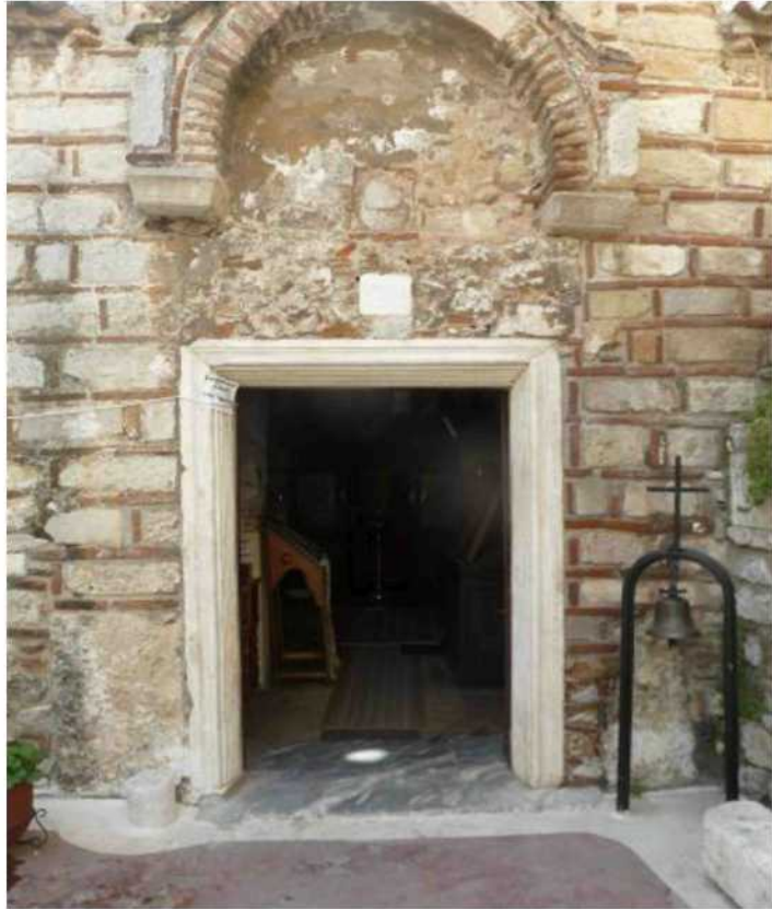
Δυτική πλευρά. Το μαρμάρινο θύρωμα της εισόδου που ίσως έχει υποστεί βράχυνση στο ύψος. Ένδειξη είναι η πρόχειρη τοιχοποιία πάνω από το υπέρθυρο.
