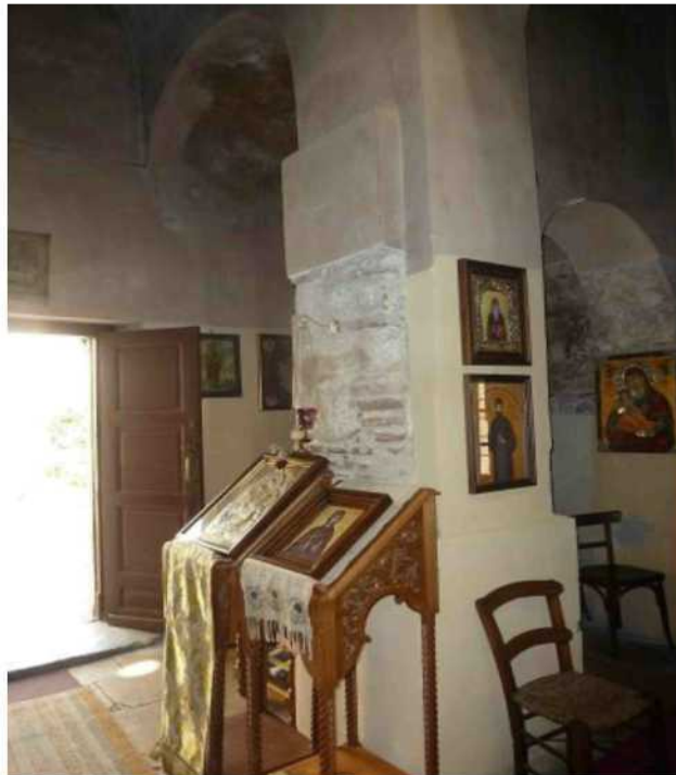
Πάνω στους πεσσούς του κεντρικού περάσματος από το νάρθηκα στο ναό διακρίνονται ίχνη από παραστάδες που πιθανότατα ανήκουν στο προϋπάρχον τρίβηλο άνοιγμα.
