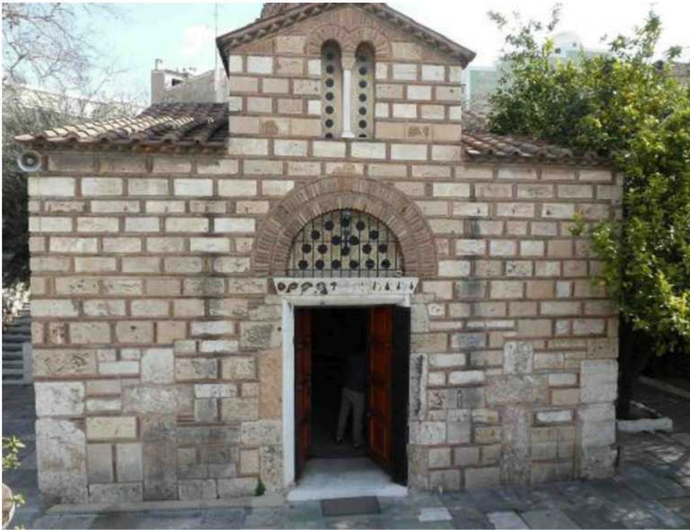
Αγ. Ασώματοι. Δυτική πλευρά.
