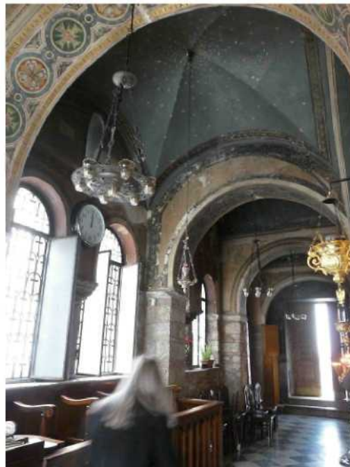
Καπνικαρέα, το εσωτερικό του εξωνάρθηκα από τα νότια. Διακρίνεται το σταυροθόλιο που αντιστοιχεί στον κεντρικό άξονα του ναού.
