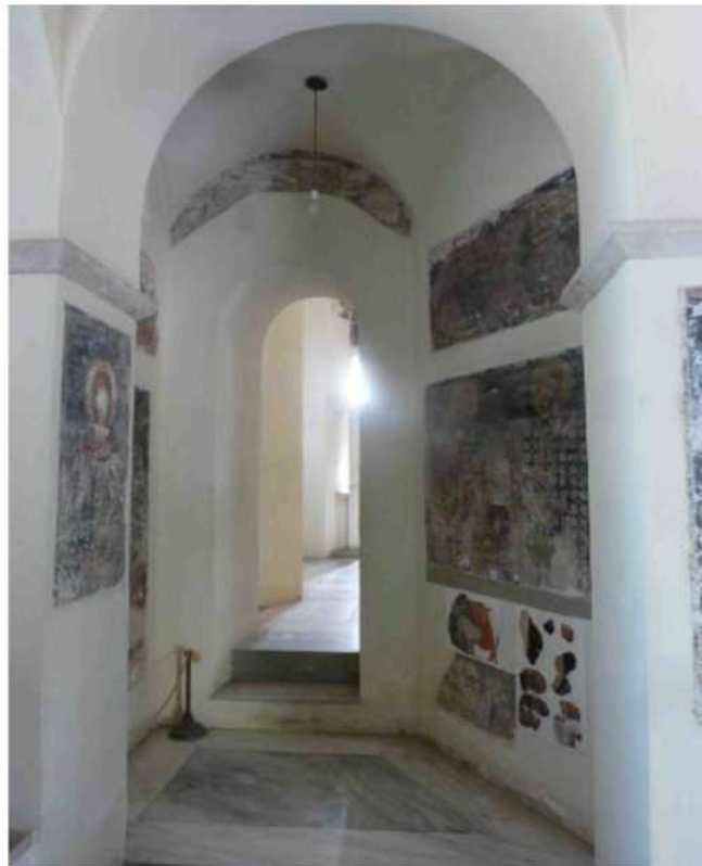
Το βόρειο μικρό πλάγιο τμήμα του πίσσχημου νάρθηκα που οδηγεί στον κυρίως ναό. Διακρίνεται η κάλυψή του με σταυροθόλιο.
