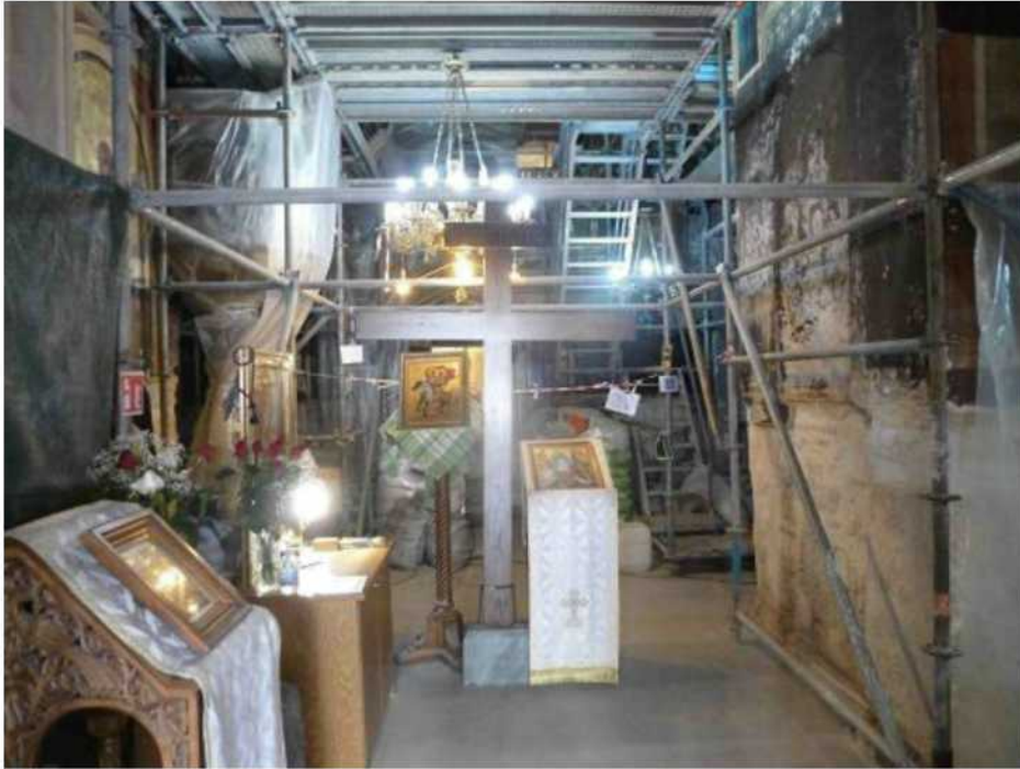
Εσωτερικό του ναού. Οι εργασίες στερέωσης και συντήρησης (2022). Διακρίνονται οι δυτικοί τοίχοι στους οποίους στηρίζονται οι καμάρες και ο τρούλλος.
