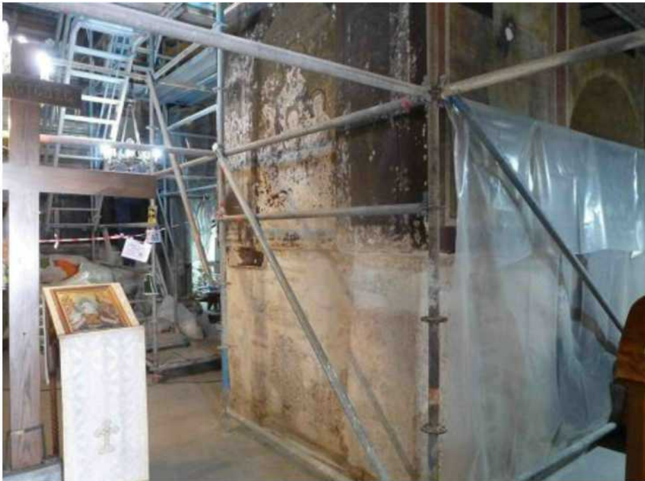
Ο νοτιοδυτικός τοίχος στήριξης του τρούλλου που διαχωρίζει το χώρο της κεντρικής κεραίας του σταυρού από το νοτιοδυτικό γωνιακό διαμέρισμα.
