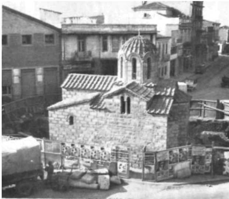
Η νότια πλευρά μετά την αποκατάσταση.
