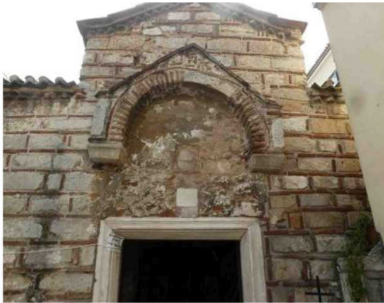
Πάνω από τη δυτική είσοδο το τοξωτό υπέρθυρο προσκυνητάρι (ή «συνεπτυγμένο πρόπυλο») με αετωματική επιστέγαση.
