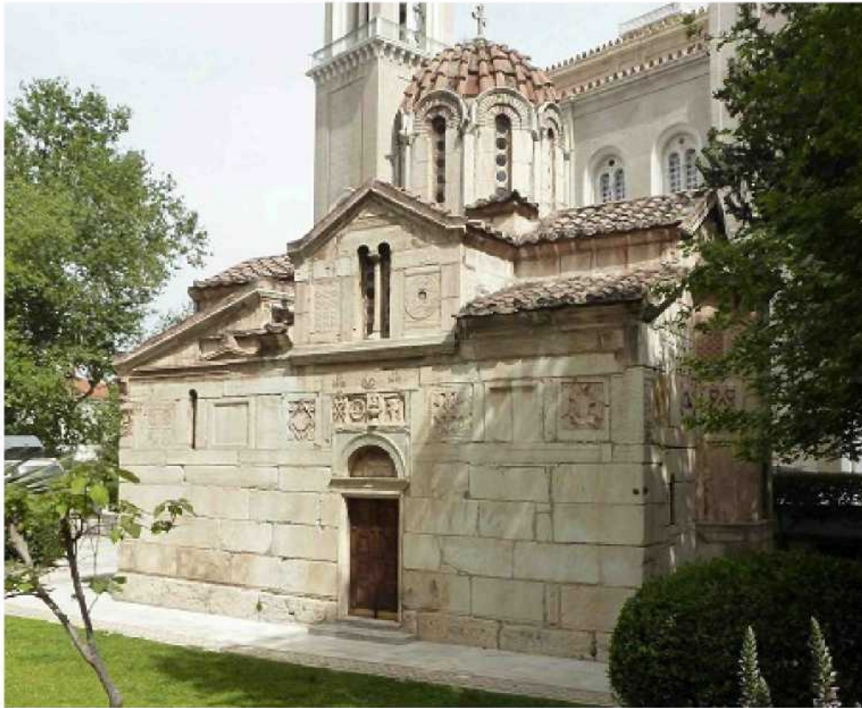
Γοργοπήκοος. Η νότια πλευρά.
