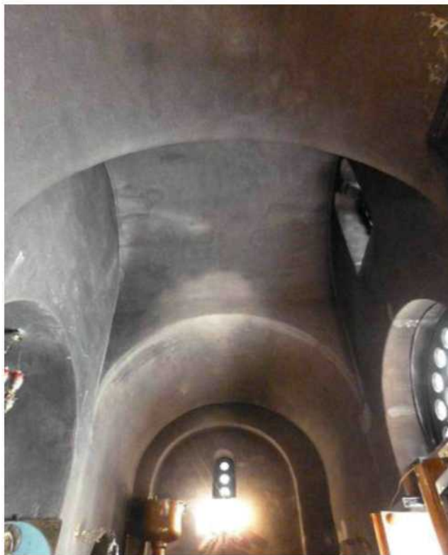
Εσωτερικό του νάρθηκα. Η σταυρεπίστεγη οροφή του και αγίδωμα στο νότιο πέρας του πάνω από τάφο (ίσως του κτήτορα).
