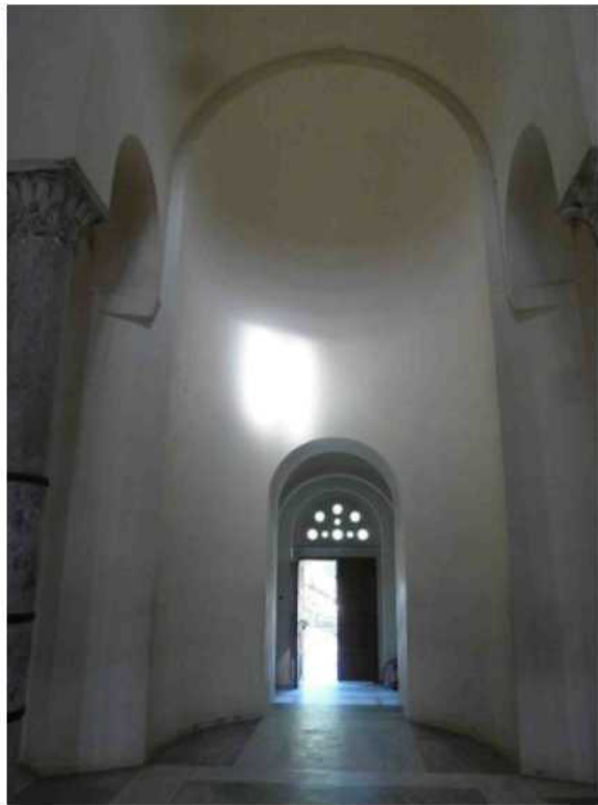
Η δυτική μεγάλη κόγχη που αναστηλώθηκε με τις εργασίες αποκατάστασης του ναού.
