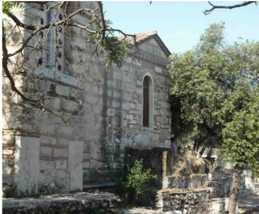
Λεπτομέρεια από τη βόρεια πλευρά του ναού. Στη βόρεια πλευρά του νάρθηκα, εξωτερικά, διακρίνονται σε ύψος 1,50 μ. τα κατάλοιπα του αρκοσολίου που προστέθηκε τον 12ο αι.
