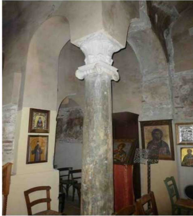
Ο βορειοδυτικός κίονας με χαρακτηριστικό διπλό κιονόκρανο, όπως και ο νοτιοδυτικός κίονας. Κάτω κιονόκρανο ιωνικό και άνω κορινθιάζον.
