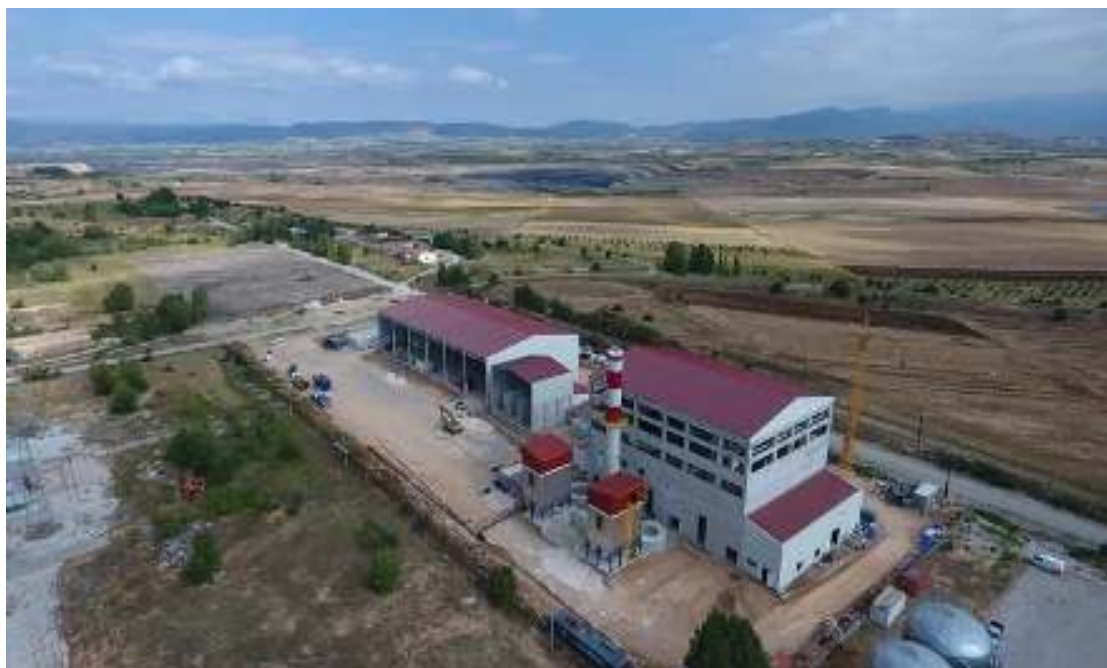
Εικόνα 10: Εγκαταστάσεις Δ.Ε.Τ.Ε.Π.Α. (Detepa, n.d.).
