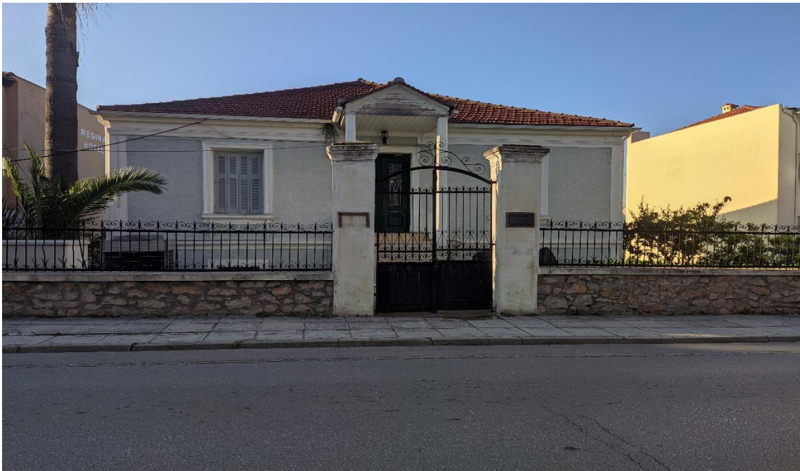
Εικόνα 24 : Κτίριο Τσώνη μετά την συντήρηση(προσωπικό αρχείο)
