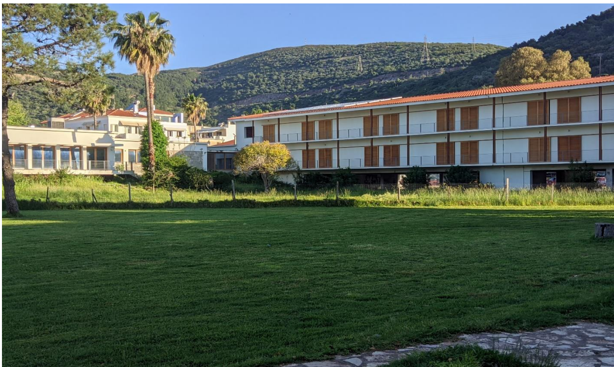
Εικόνα 27 : Κτιριακή Αναβάθμιση Ξενία Ναυπάκτου (προσωπικό αρχείο )
