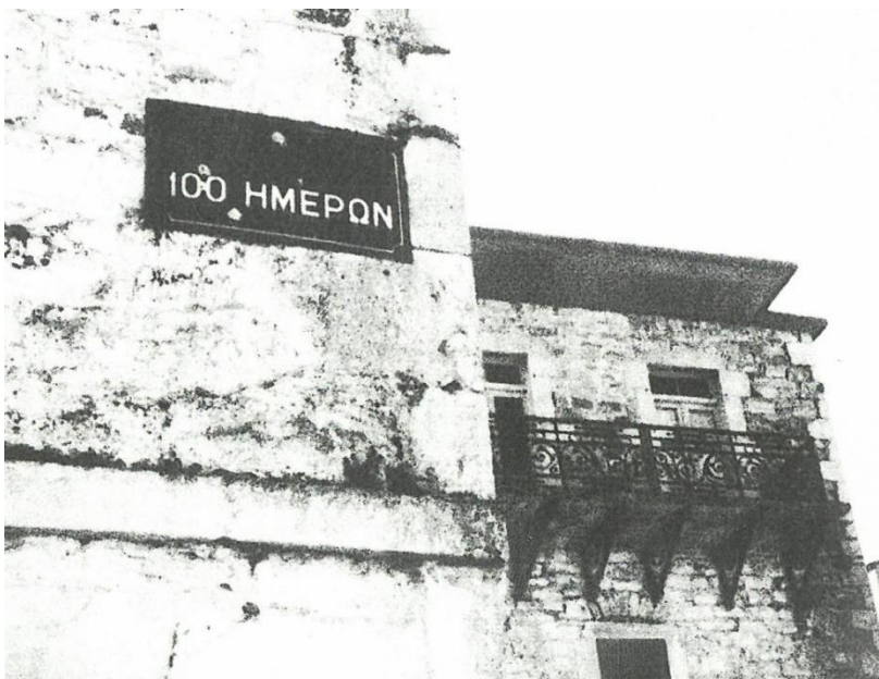
Εικόνα 8: Πινακίδα σε οδό του χωριού Κοσμά μετά την ολοκλήρωση των εργασιών Τομέας δημοσίων έργων – οδικές συγκοινωνίες – νομός Αρκαδίας
