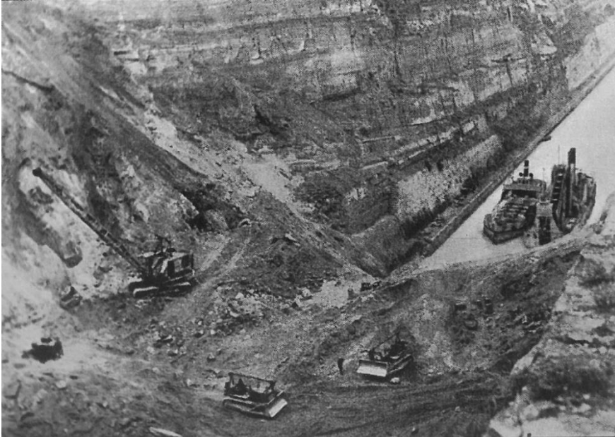
Εικόνα 11 : Εργασίες καθαρισμού της διώρυγας Κορίνθου
