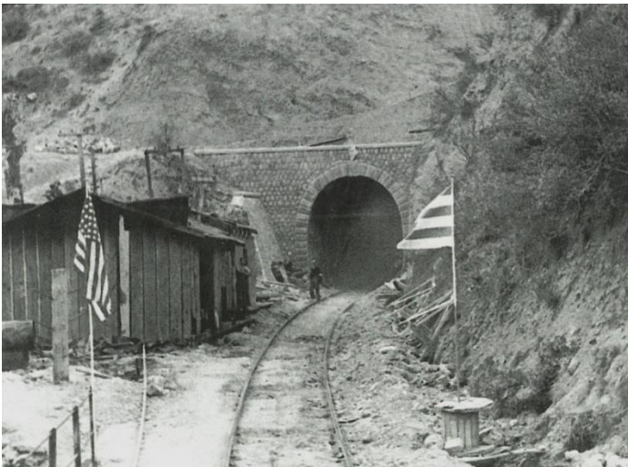
Εικόνα 10 : Σήραγγα του σιδηροδρομικού δικτύου στα Κιούρκα Αττικής. Δεξιά και αριστερά διακρίνονται οι σημαίες των δύο χωρών, της Ελλάδας και της Αμερικής.
