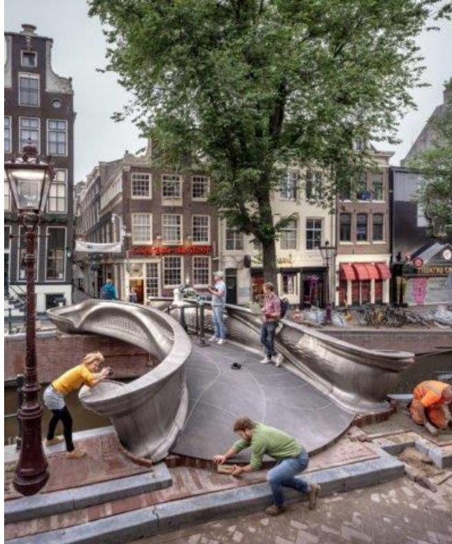
Εικόνα 5-2 Η Stoofbrug στο Άμστερνταμ, τοποθέτηση [ https://newsbeezer.com/belgium/de-eerste-3d-geprinte-stalen-brug-geinstalleerd-in-amsterdam/ ]
