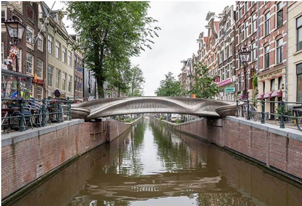
Εικόνα 5-1 Η Stoofbrug στο Άμστερνταμ, η πρώτη 3D-εκτυπωμένη μεταλλική γέφυρα στον κόσμο [ https://www.robotics247.com/article/steel_bridge_3d_printed_by_mx3d_officially_opens_in_amsterdam ]
