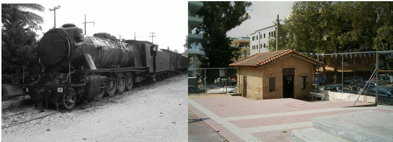
ΕΙΚΟΝΑ 3: Σταθμός Αττικού Σιδηροδρόμου Αθηνών-Λαυρίου
