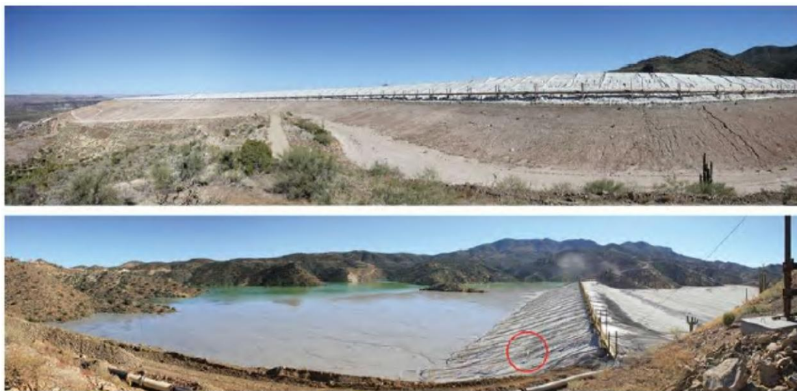
Σχήμα 69: Άποψη ενός χωμάτινου φράγματος από το εξωτερικό (επάνω) και μια λίμνη αποθήκευσης απόβλητων με ένα χωμάτινο φράγμα (κάτω).
