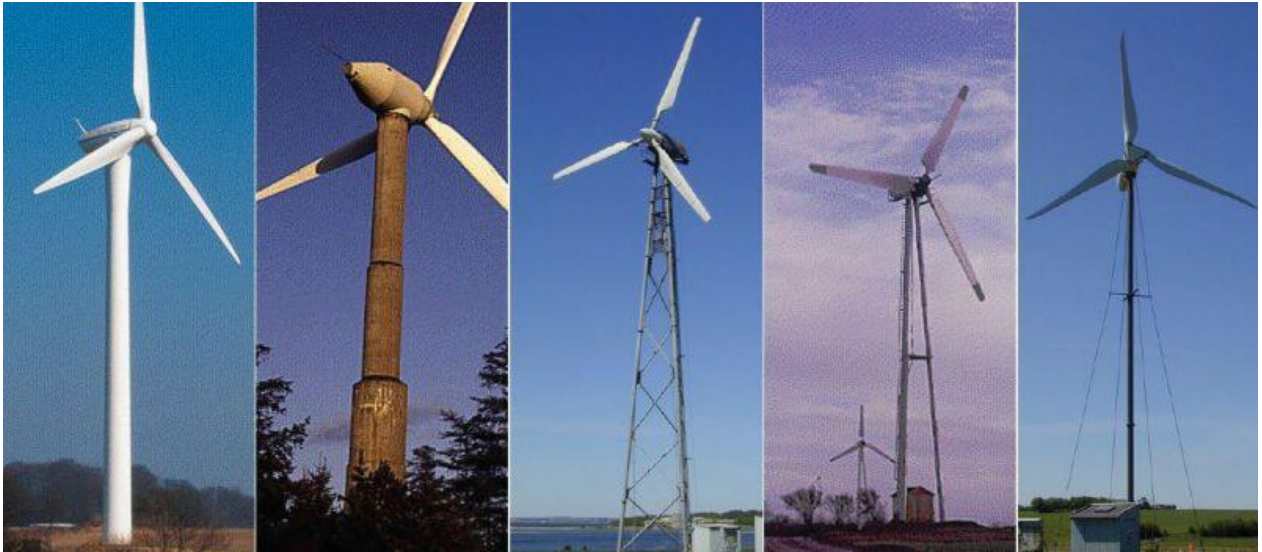
Εικόνα 34: Είδη πύργων ανεμογεννήτριας. ( http://www.steelwindtower.com/wind-turbine-tower-comparison-pros-and-cons-explained/ )
