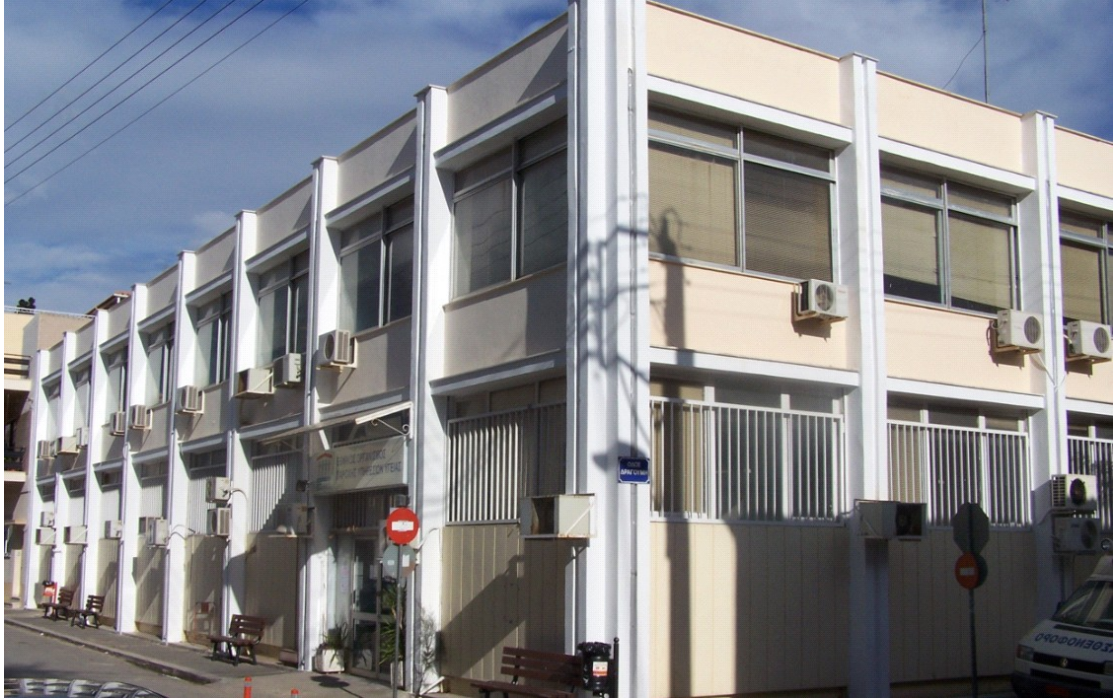
Φωτογραφία γενικής άποψης κτηρίου ΙΚΑ Ελευσίνας
