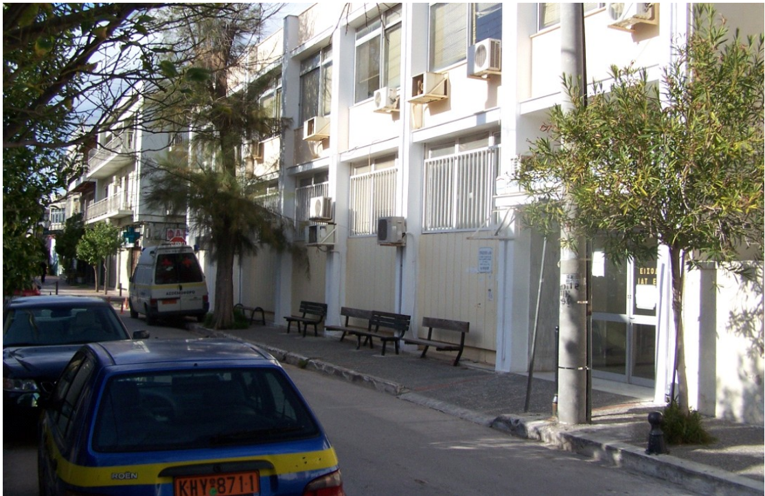
Φωτογραφία γενικής άποψης κτηρίου ΙΚΑ Ελευσίνας
