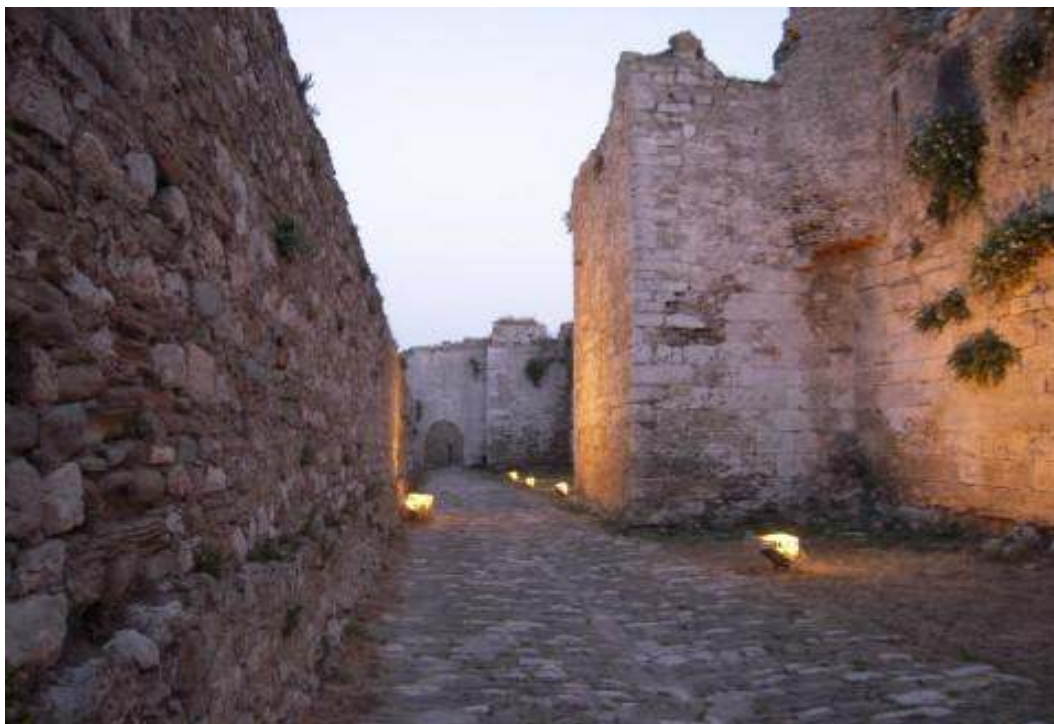
Εικ. 8: Η προστατευμένη από τα τείχη λιθόστρωτη οδός, που οδηγεί από την είσοδο στο εσωτερικό του κάστρου της Μεθώνης, φωτισμένη.
