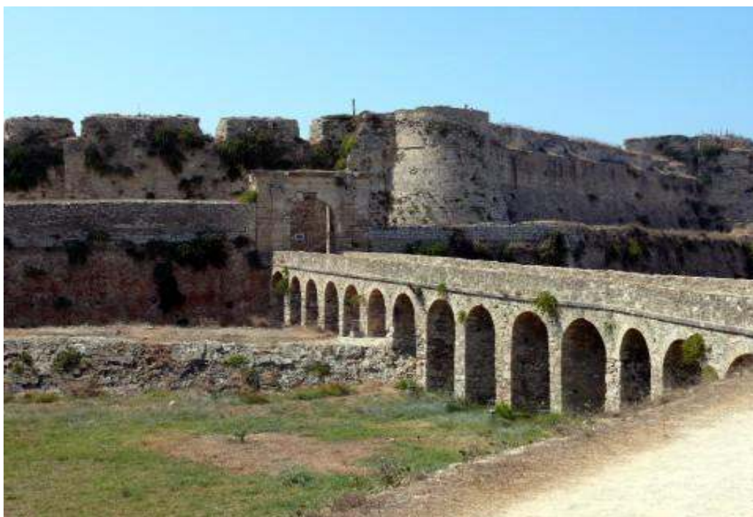
Εικ. 9: Άποψη της γέφυρας του κάστρου της Μεθώνης με τα δεκατέσσερα τόξα.
