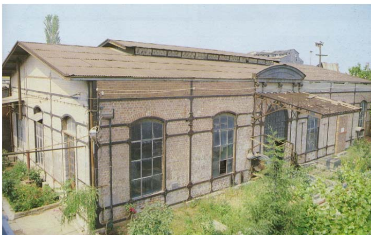
Εικόνα 2.4 Το αντλιοστάσιο της Εταιρείας Υδάτων
