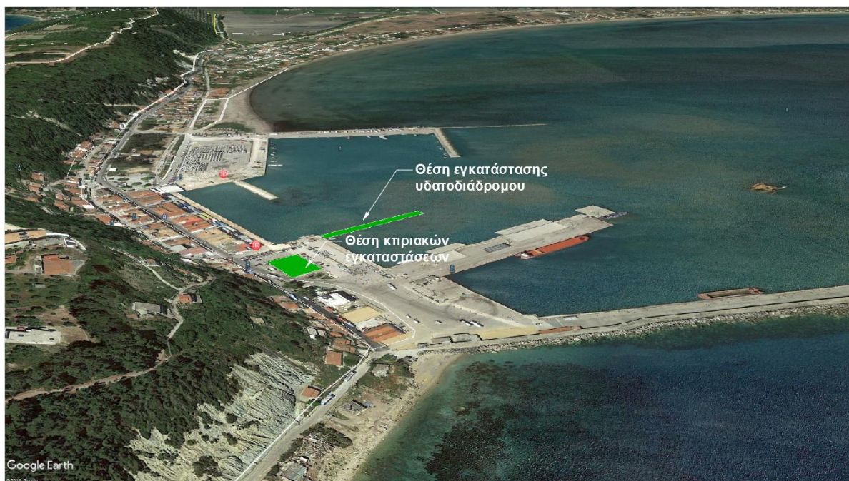
Εικόνα 7.2: Θέση εγκατάστασης της μονάδας
