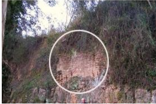
Εικ. 8 Η επιπρόσθετη τοιχοποιία στο τείχος του Κλαδέου από καλά τακτοποιημένες οπτόπλινθους πάνω από το αρχικό τείχος, κατά τις επιδιορθώσεις μετά τα πλημμυρικά γεγονότα του 2ου ή 3ου αι. μ.Χ.
