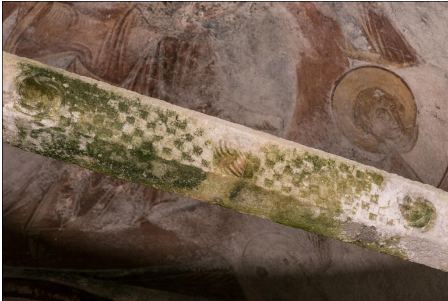
Εικ. 67: Ανατολικός ελκυστήρας, δυτική πλευρά.
