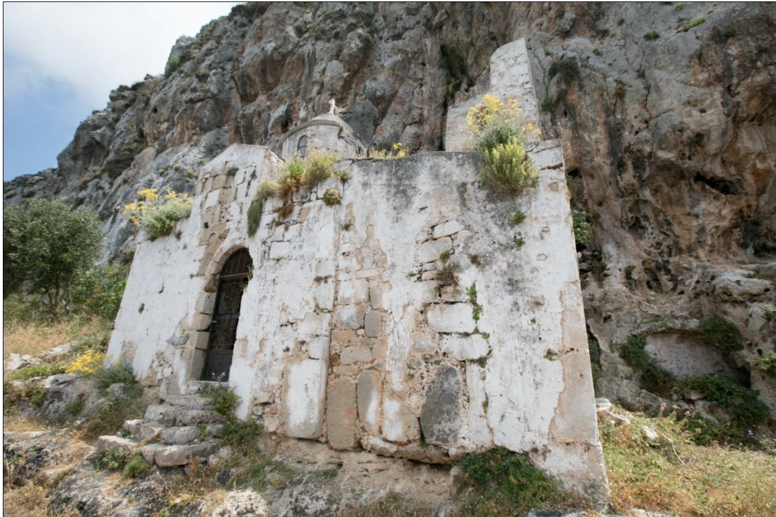
Εικ. 38: Η βόρεια πλευρά του ναού.
