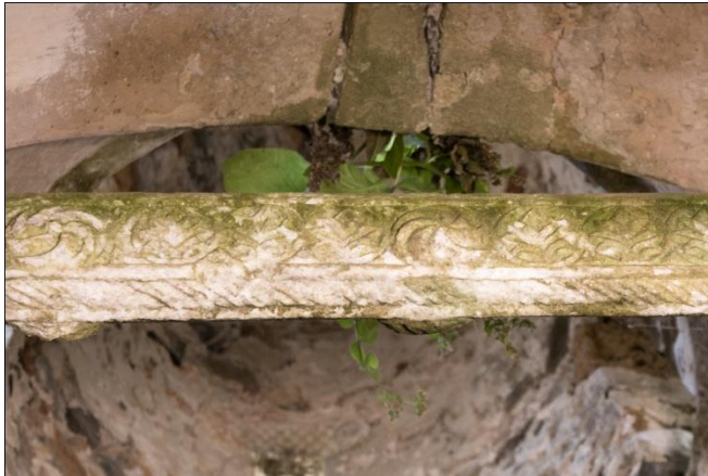
Εικ. 69: Δυτικός ελκυστήρας, πλευρές: δυτική και κάτω.
