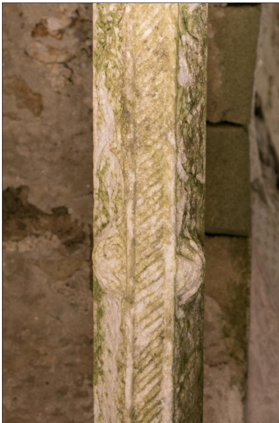
Εικ. 70: Βόρειος ελκυστήρας, πλευρές: βόρεια, κάτω και νότια.
