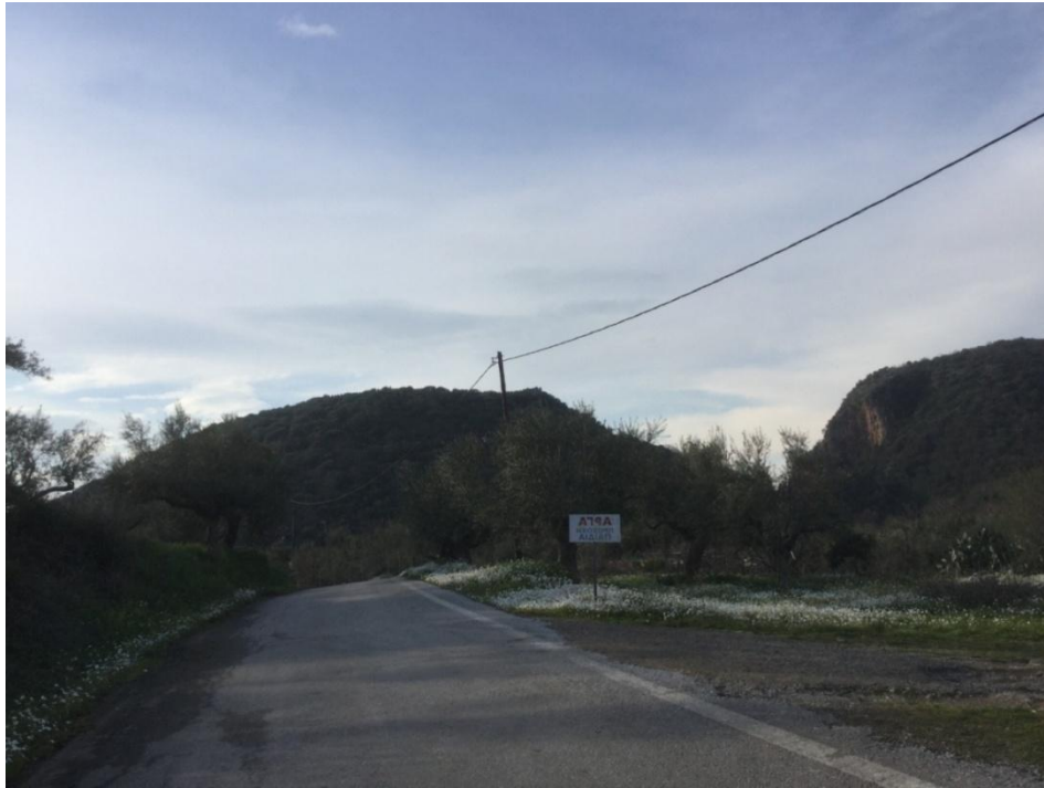
Εικ. 73: Ο δρόμος προς το Κάστρο του Πασσαβά. Στο βάθος διακρίνεται η κλεισούρα
