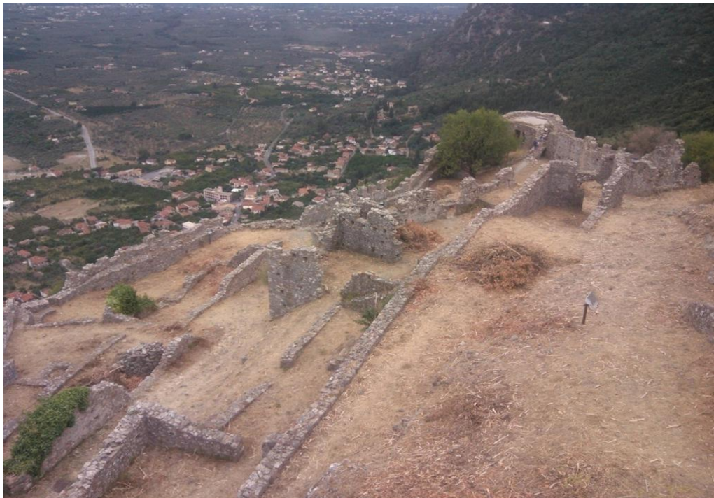
Εικ. 38: Το νοτιοδυτικό τμήμα της κάτω ζώνης της ακρόπολης
