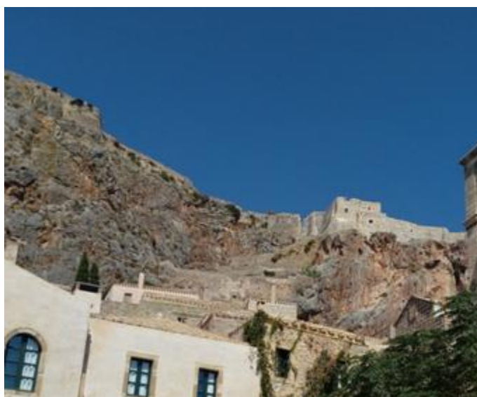
Εικ. 31: Γενική άποψη των τειχών της Άνω Πόλης
