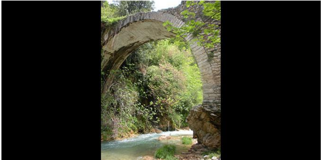
Εικ. 19 Πέτρινο γεφύρι στην περιοχή της Αμπελιώνας.
