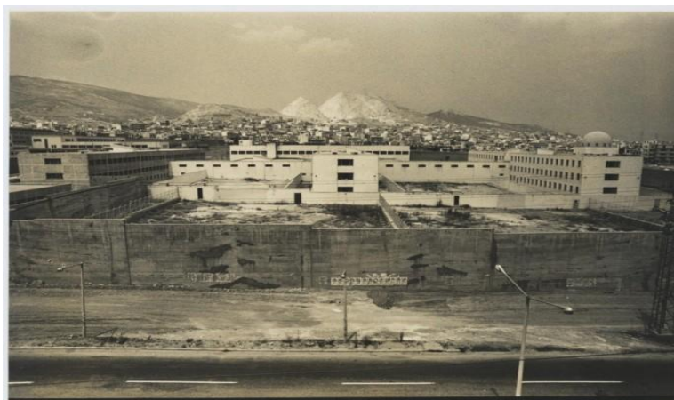
Εικόνα 2: Κατασκευή φυλακών Κορυδαλλού
