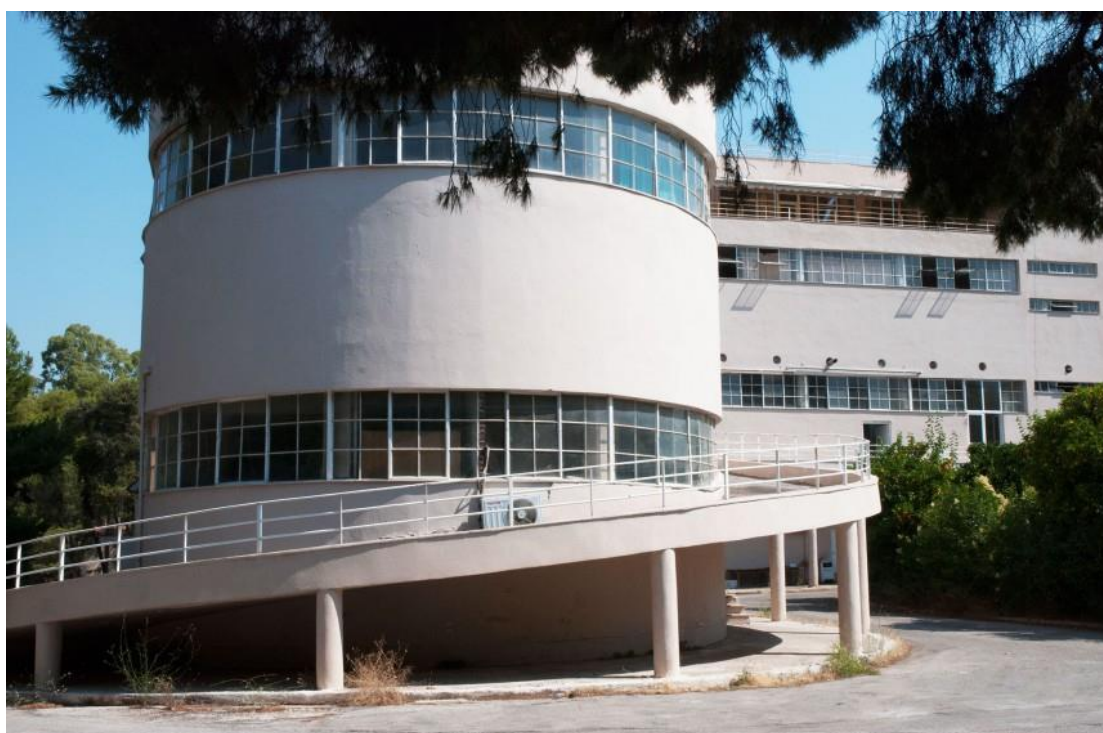
Εικόνα 32 : Το κτίριο των Μαγειρείων
