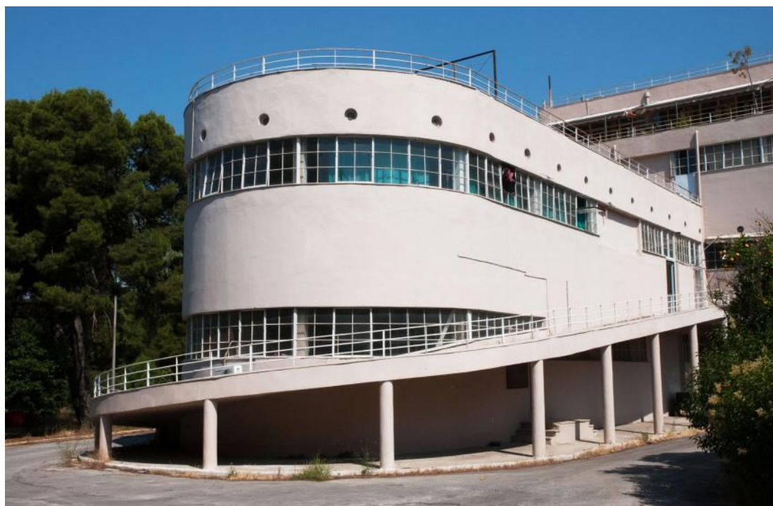
Εικόνα 31 : Το κτίριο των Μαγειρείων
