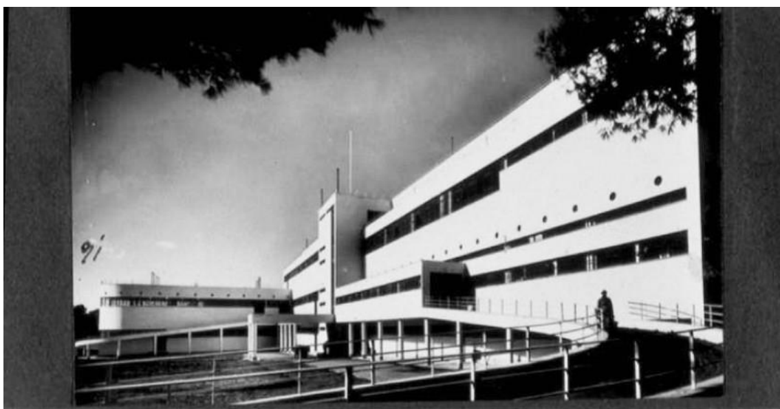
Εικόνα 24 Το κτίριο υπηρεσιών
