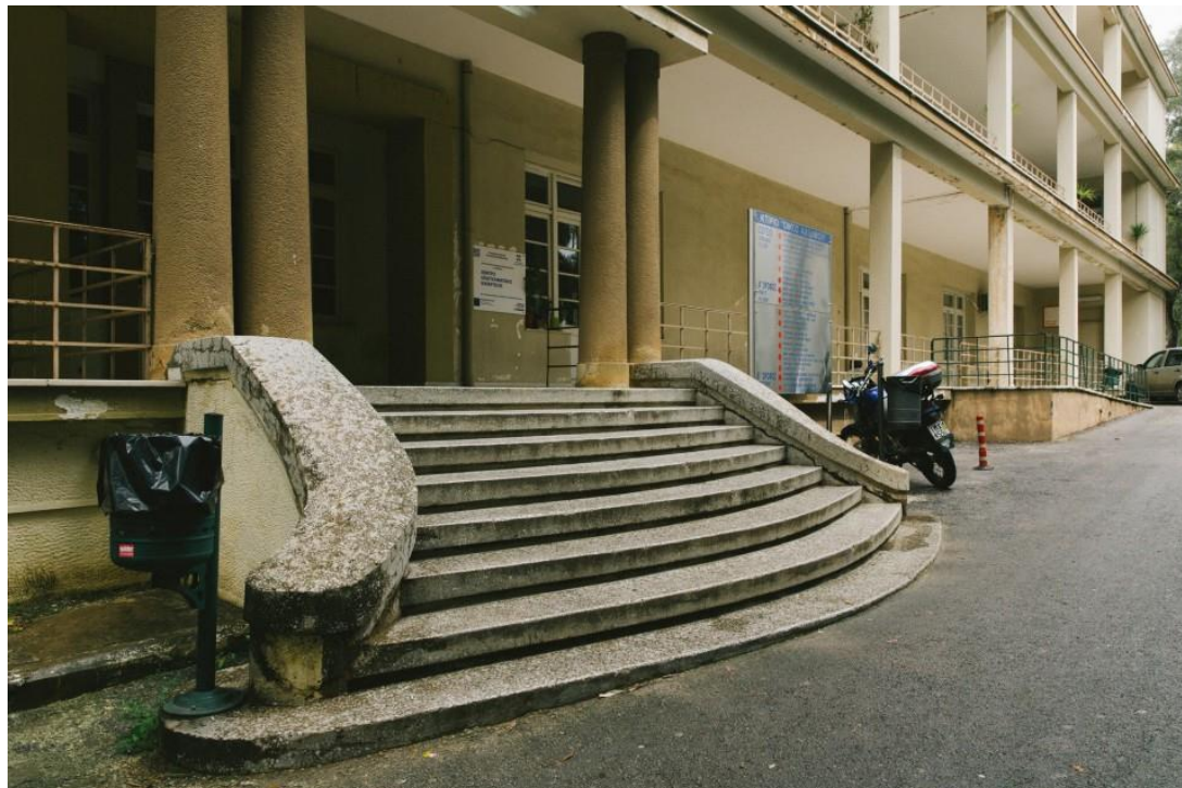
Εικόνα 30 : Το κτίριο «Λαναρά»
