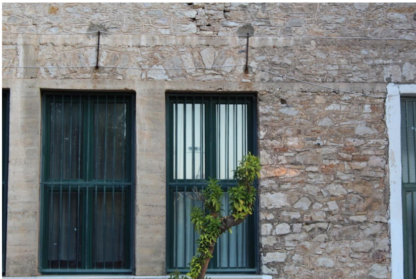
Εικ. 141: Το νέο υλικό, το μπετόν διαμορφώνει τα κατακόρυφα στοιχεία του κτηρίου του Γυμνασίου - Λυκείου Πεταλίου που επιδεικνύουν έντονα τη χρήση του.
