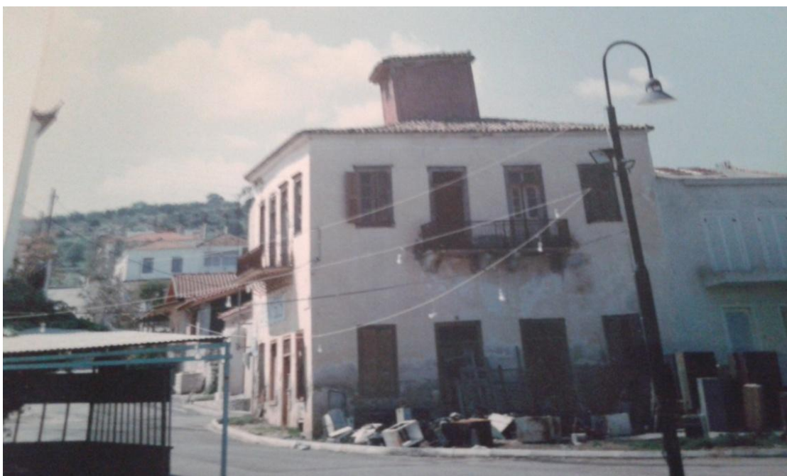
Εικ. 156: Η οικία της οικογένειας Κατσιμαντή, στην πλευρά της προς τον παραλιακό δρόμο, πριν την ερείπωση και τελικά την κατεδάφισή της.
