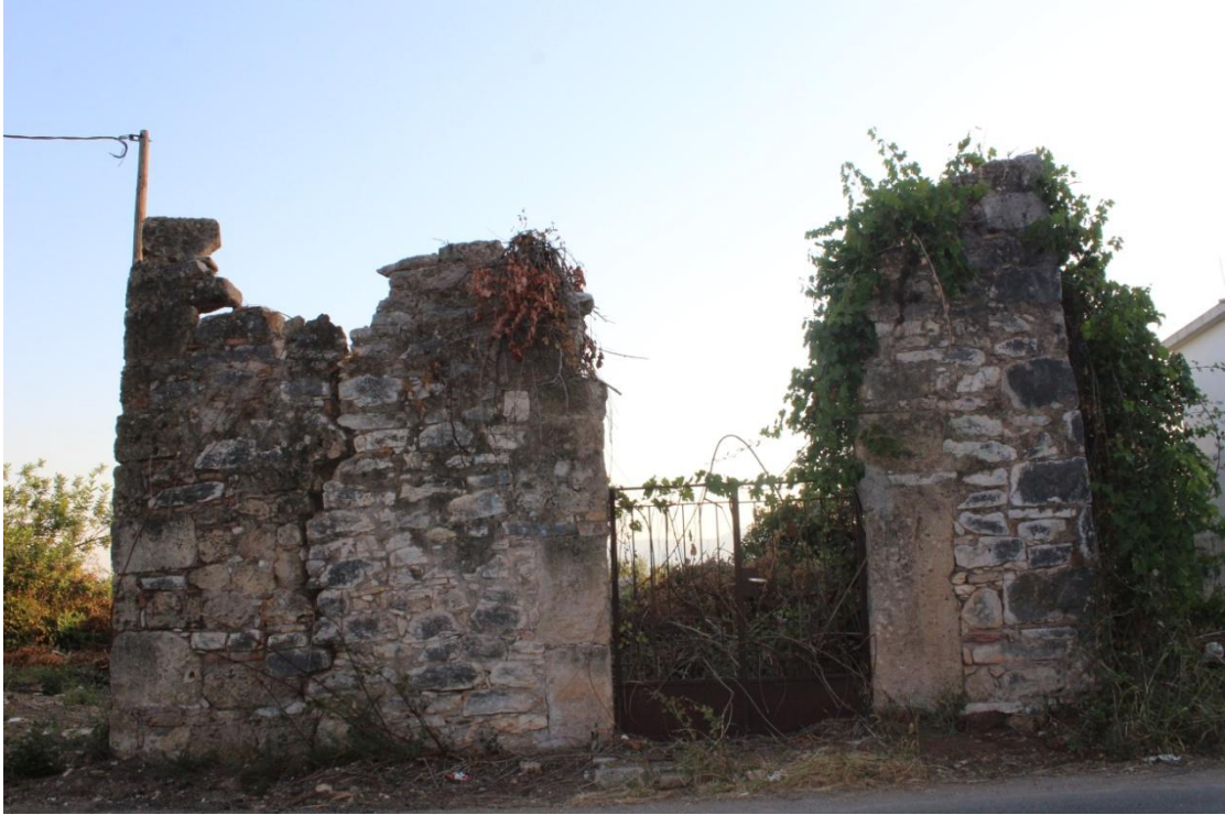
Εικ. 115: Ερειπωμένη παραδοσιακή οικία κοντά στην εκκλησία της Ζωοδόχου Πηγής. Από τα πρώτα σπίτι του οικισμού.
