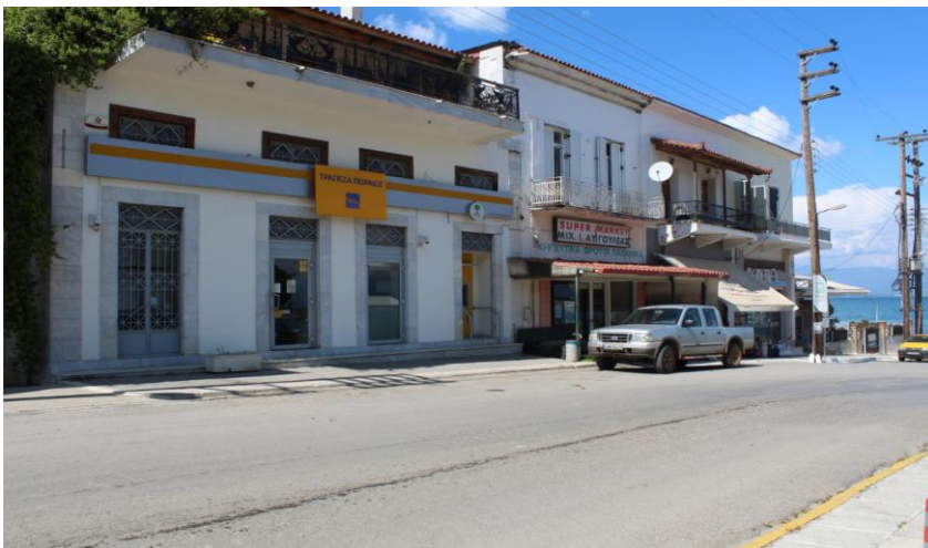
Εικ. 64: Η οικία Αλέπη σε πρόσφατη φωτογραφία, μετά την ανακαίνισή της.
