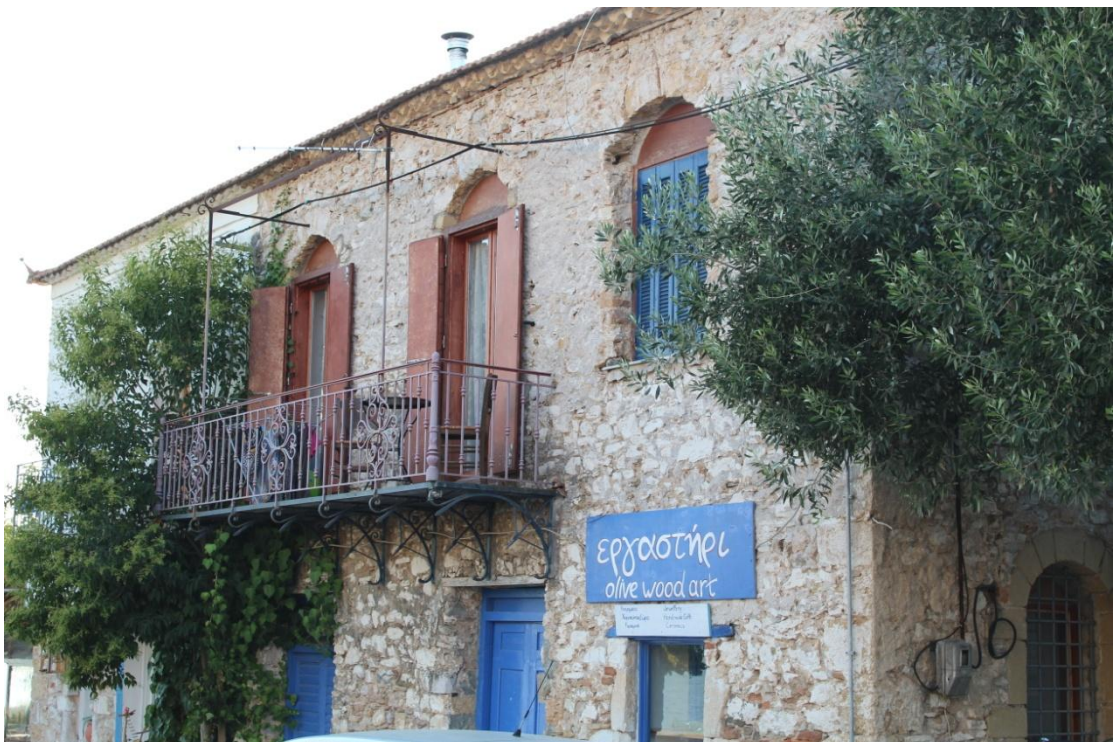
Εικ. 154: Πετρόχτιστη κατοικία στην παραλία με τοξοειδή παράθυρα και μεταλικά φουρούσια στα μπαλκόνια.
