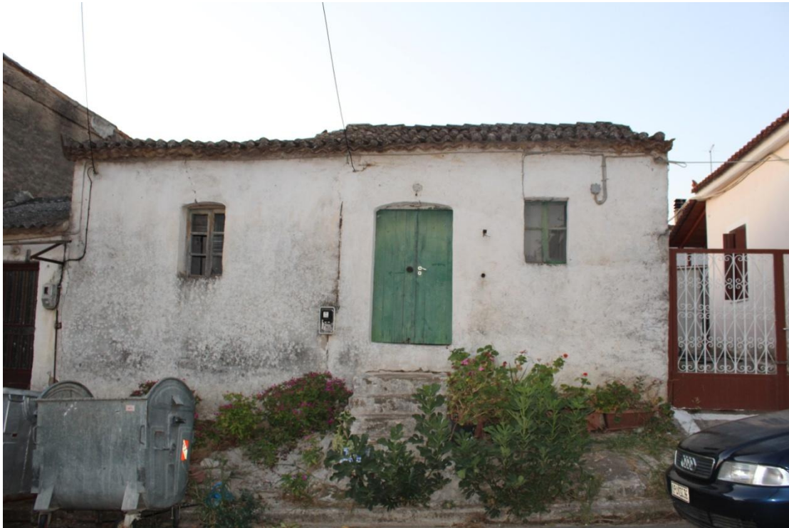
Εικ. 103: Ισόγεια λιθόκτιστη παραδοσιακή κατοικία του Πεταλιδίου, με καμάρα στην κεντρική είσοδο.
