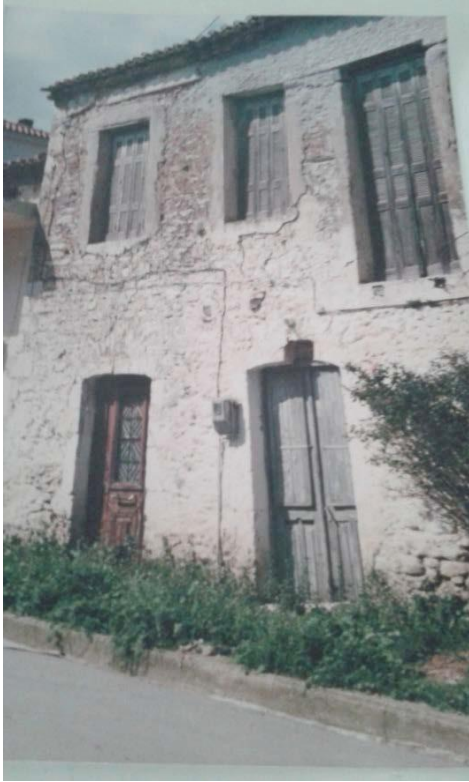
Εικ. 101: Λιθόκτιστη παραδοσιακή κατοικία στο Πεταλίδι. Η στέγη φέρει γείσο αποτελούμενο από τρεις σειρές κεραμιδιών, ενώ στο ανώφλι του κεντρικού θυρώματος υπήρχε λιθάρι που λέγεται «κλειδί».
