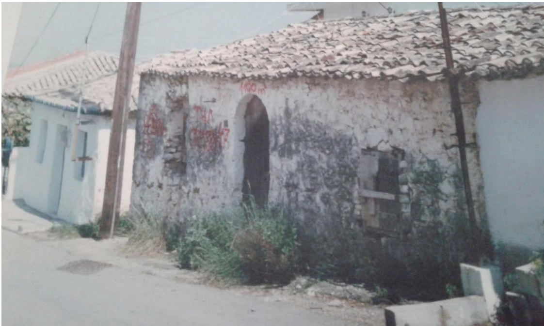
Εικ. 102: Ισόγεια λιθόκτιστη παραδοσιακή κατοικία του Πεταλιδίου, με καμάρα στην κεντρική είσοδο.
