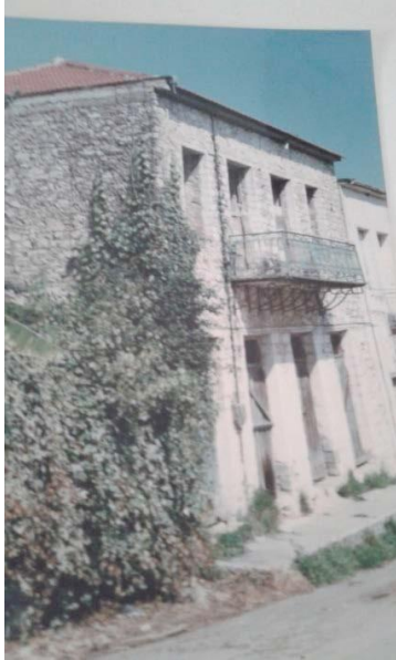
Εικ. 105: Λιθόκτιστη παραδοσιακή κατοικία στο Πεταλίδι με εμφανή τα χαρακτηριστικά του νεοκλασικού ρυθμού, όπως ο εξώστης με τα μεταλλικά φουρούσια στο κέντρο της πρόσοψης.
