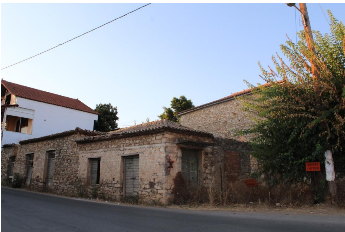
Εικ. 104: Ισόγεια λιθόκτιστη παραδοσιακή κατοικία του Πεταλιδίου.
