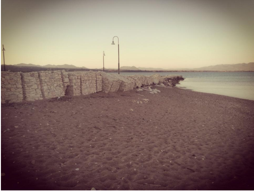
Εικ. 177: Τα πλόκα στην περιοχή του Φάρου. Σήμερα με τις προσχώσεις έχει στο μεγαλύτερο μέρος δημιουργηθεί αμμώδης παραλία μπροστά στα μπολκς που έπεσαν τότε μέσα στη θάλασσα.
