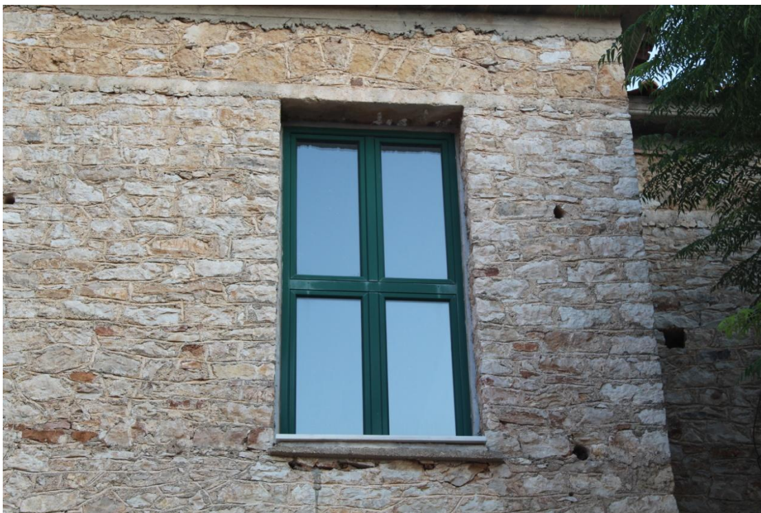
Εικ. 140: Τα ανοίγματα ορθογώνιας κατατομής του κτηρίου του Γυμνασίου-Λυκείου Πεταλιδίου που φέρουν ως επίστεψη ανακουφιστικά λίθινα τόξα.
