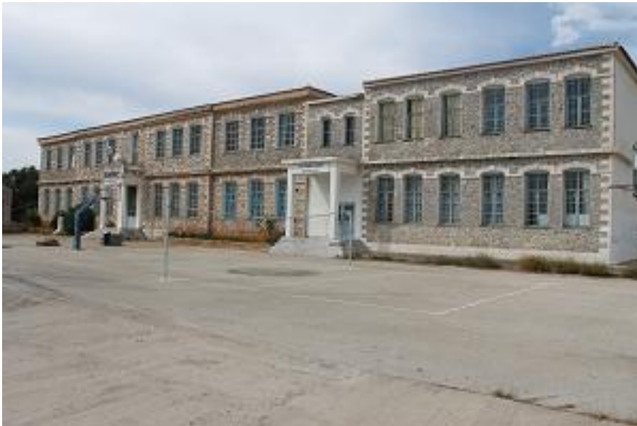
Εικ. 144: Το κτήριο του Γυμνασίου - Λυκείου Αρεόπολης.
