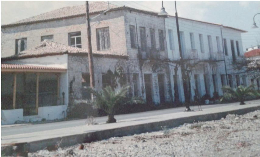
Εικ. 125: Πρώιμα κτήρια νεοκλασικισμού της οικογένειας Μαργέλη, τα οποία βρίσκονται στην παραλία, κοντά στη βρύση «του Ψεύτη».
