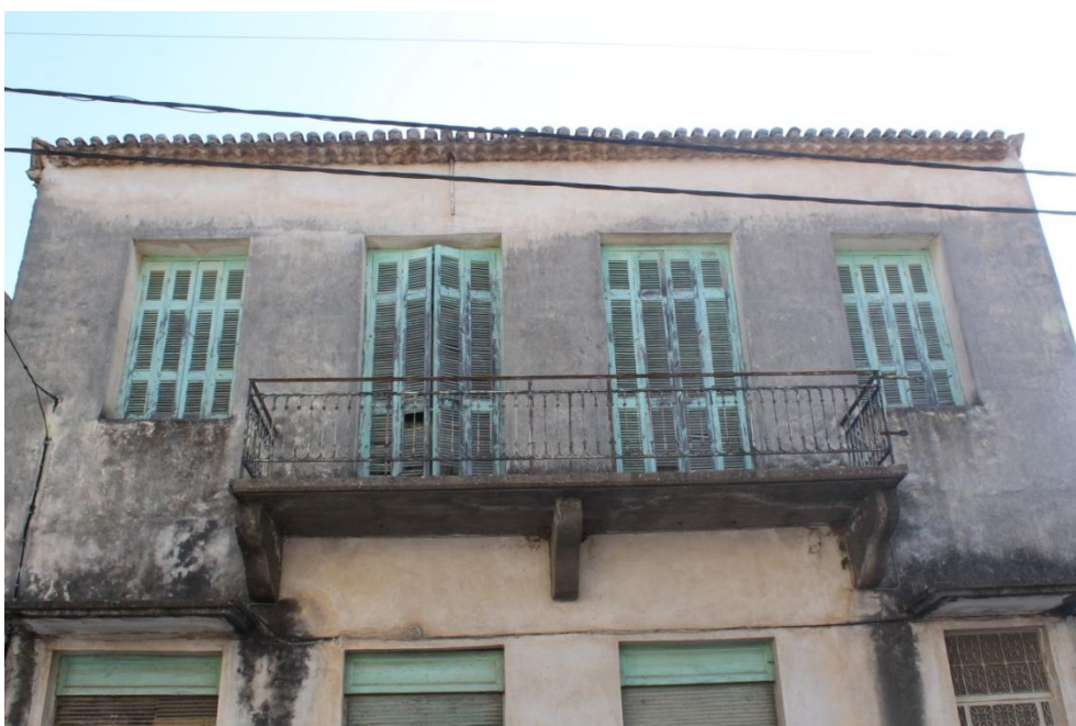
Εικ. 108: Λιθόκτιστη κατοικία στο Πεταλίδι με εμφανή τα χαρακτηριστικά του νεοκλασικού ρυθμού, όπως ο εξώστης με τα μαρμάρινα φουρούσια.
