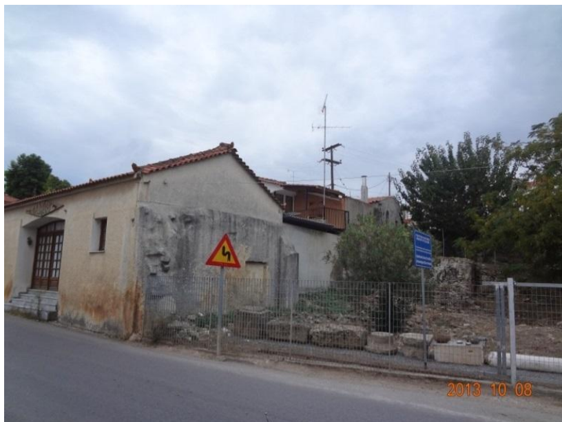
Εικ. 37: Απαλλοτριωμένος χώρος από την αρχαιολογική υπηρεσία, με ερείπια ρωμαϊκών και υστερορωμαϊκών οικοδομημάτων. Βρίσκεται στον κεντρικό δρόμο, πηγαίνοντας για Κορώνη.
