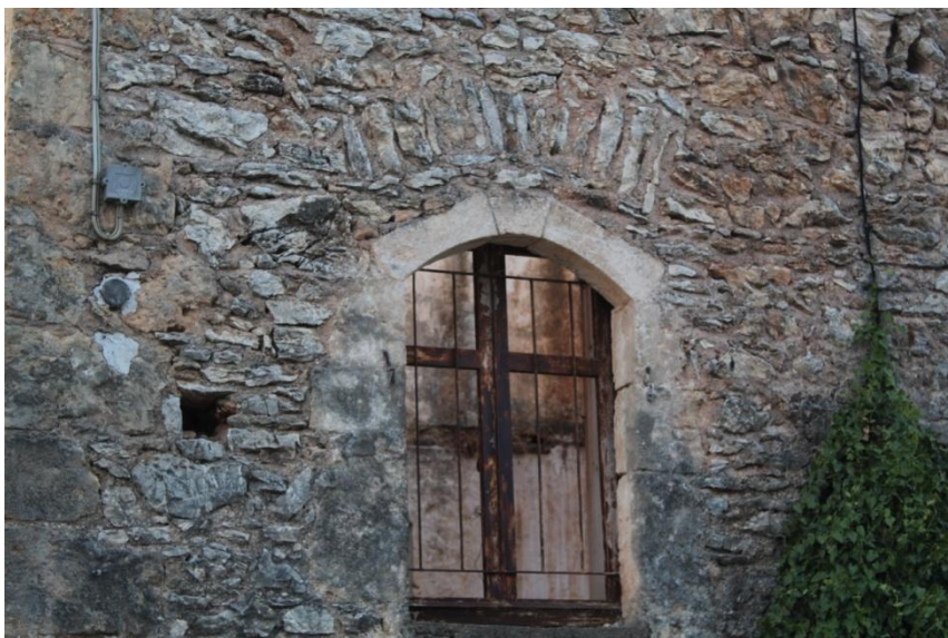
Εικ. 118: Τα παράθυρα της οικίας Μολώνη, όμοια με πολεμίστρες που παραπέμπουν σε πυργόσπιτα.
