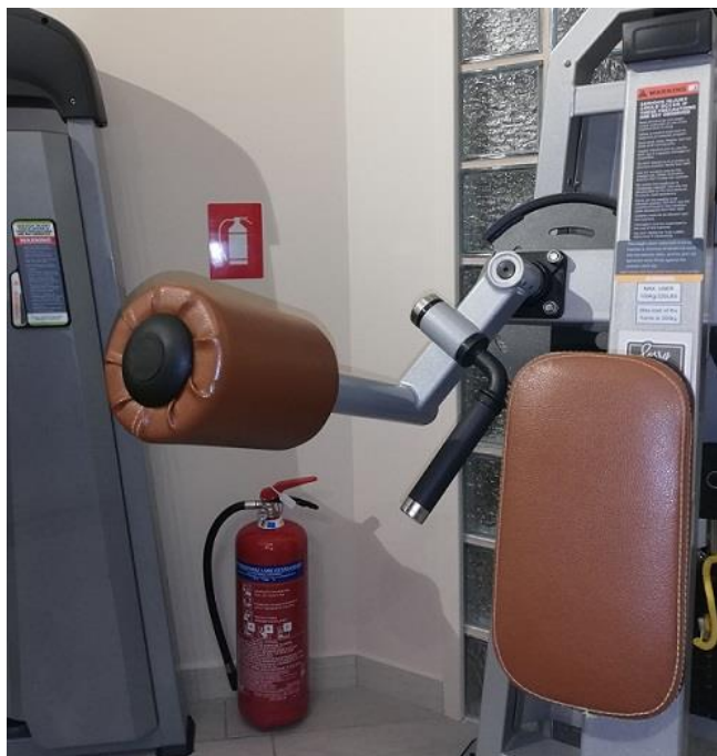
Εικόνα 1: Πυροσβεστήρας ο οποίος συνοδεύεται από την κατάλληλη σήμανση.
