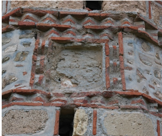
Εικόνα 38: Τετράγωνο διάχωρο της ανατολικής πλευράς απογυμνωμένα σήμερα από το υλικό διακόσμησής του.
