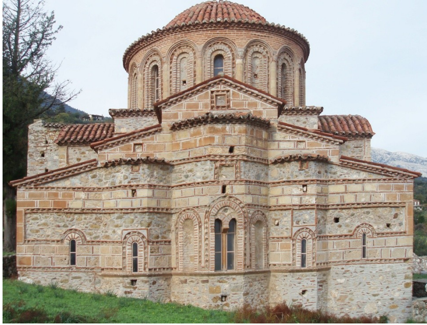
Εικόνα 36: Ανατολική όψη του ναού.
