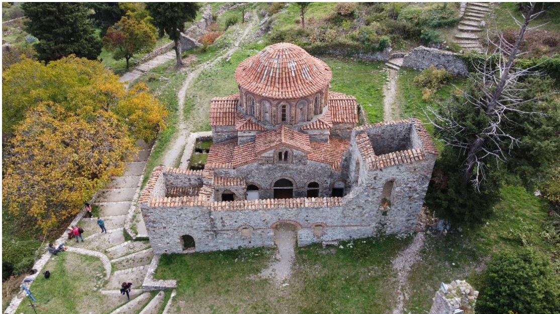
Εικόνα 42: Φωτογραφική λήψη με χρήση drone από δυτικά. Διακρίνεται η μεταγενέστερη προσθήκη του νάρθηκα και τα πυργόσχημα κτίσματα εκατέρωθεν.
