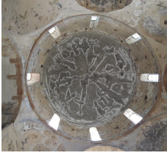
Εικόνα 67: Ο θόλος από μπετόν του τρούλου.
