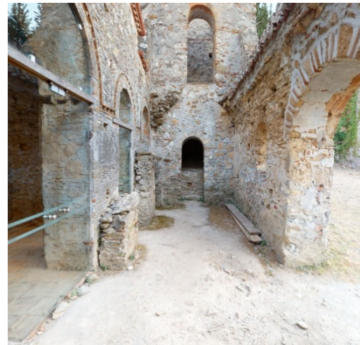
Εικόνα 44: Εσωτερικό του νάρθηκα. Λήψη προς τα νότια. Διακρίνονται τα υπολείμματα του τοίχου για την έδραση του θόλου, καθώς και τα εσωτερικά ανοίγματα του πυργόσχημου νότιου κτίσματος.
