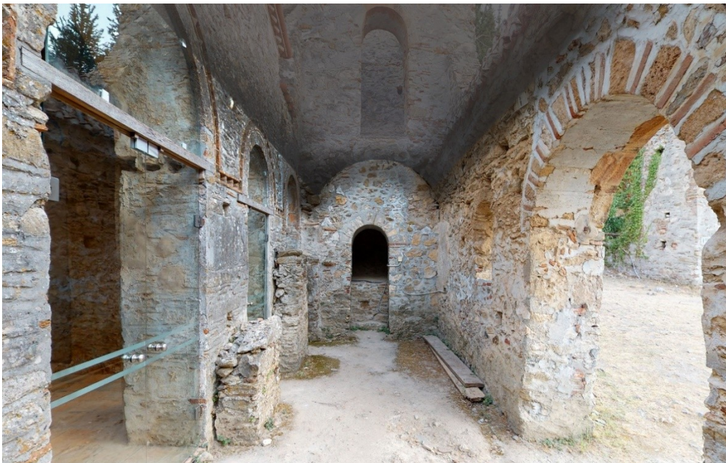
Εικόνα 46: Εσωτερικός χώρος του νάρθηκα του ναού των Αγίων Θεοδώρων. Προσπάθεια αναπαράστασης του θόλου κάλυψής του με βάση τα σωζόμενα στοιχεία.
