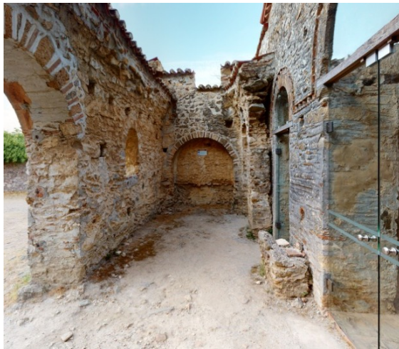
Εικόνα 43: Εσωτερικό του νάρθηκα. Λήψη προς τα βόρεια. Διακρίνονται τα ίχνη γένεσης του θόλου κάλυψής του.
