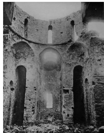
Εικόνα 20: Εσωτερική άποψη των Αγίδων του Ιερού Βήματος.
