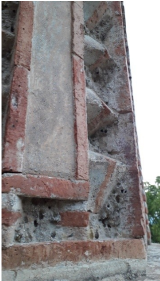
Εικόνα 37: Λεπτομέρεια κεραμοπλαστικού διακόσμου της ανατολικής πλευράς.
