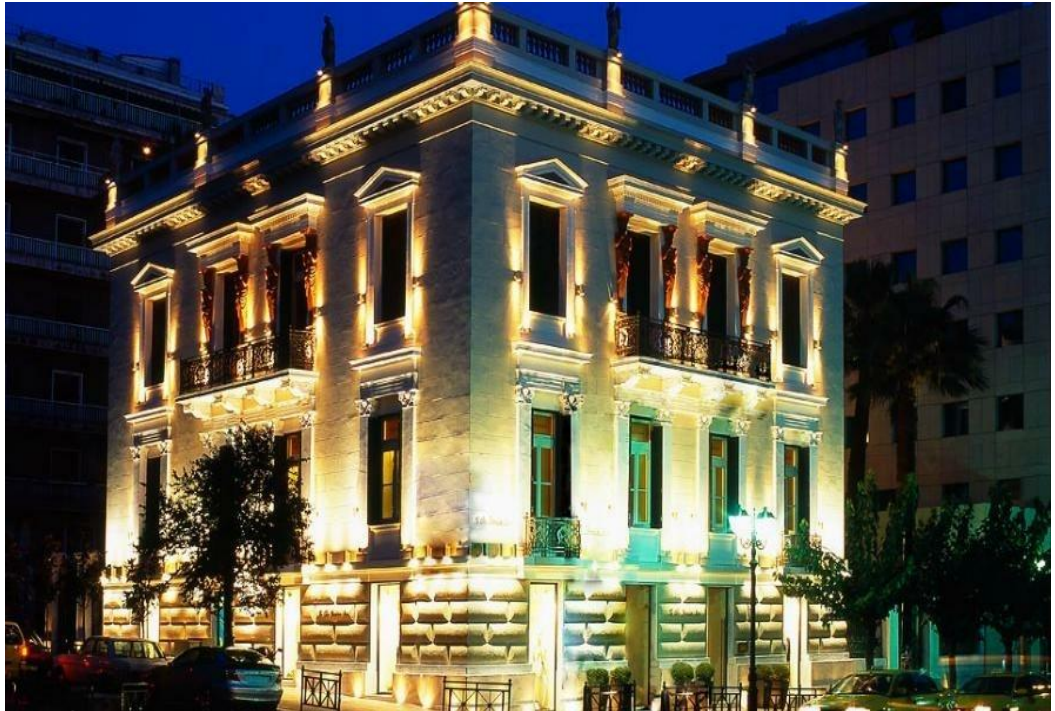
Εικόνα 19: Η έπαυλη που σχεδίασε ο Τσίλλερ για το Βιομήχανο Μεταζά στη συμβολή των οδών Βασιλέως Γεωργίου και Γρ.Λαμπράκη. https://www.efsyn.gr/arheio/mnimeia-tis-polis/200769-sto-arhontiko-poy-eklepse-o-tsaroyhis ( έντυπη έκδοση 23-6-2019 ) (28-4-2022)
