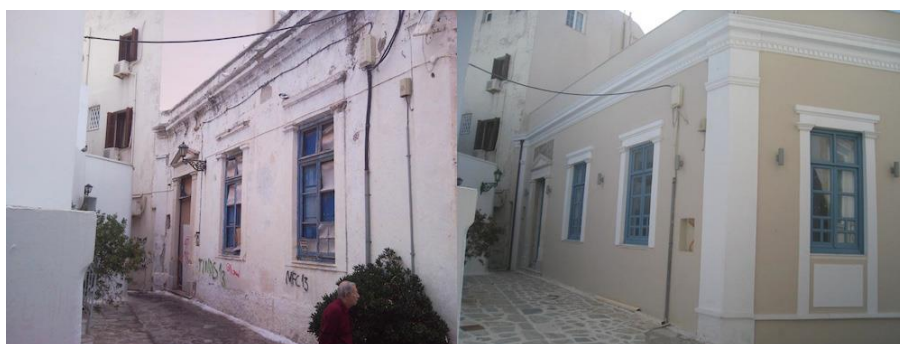
Εικόνα 4.1: Πίσω όψη Μοσχουλείου Σχολής (πριν -μετά). Πηγή: https://vasartis.com/
