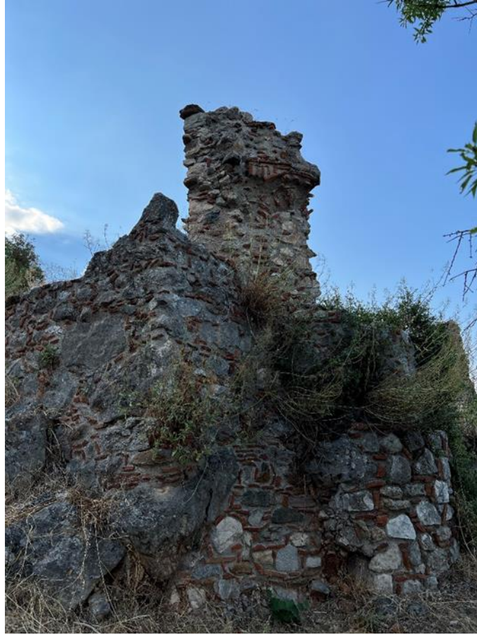
Εικόνα 59. Ναΐσκος Π12. Νοτιοανατολική όψη εξωτερικά.
