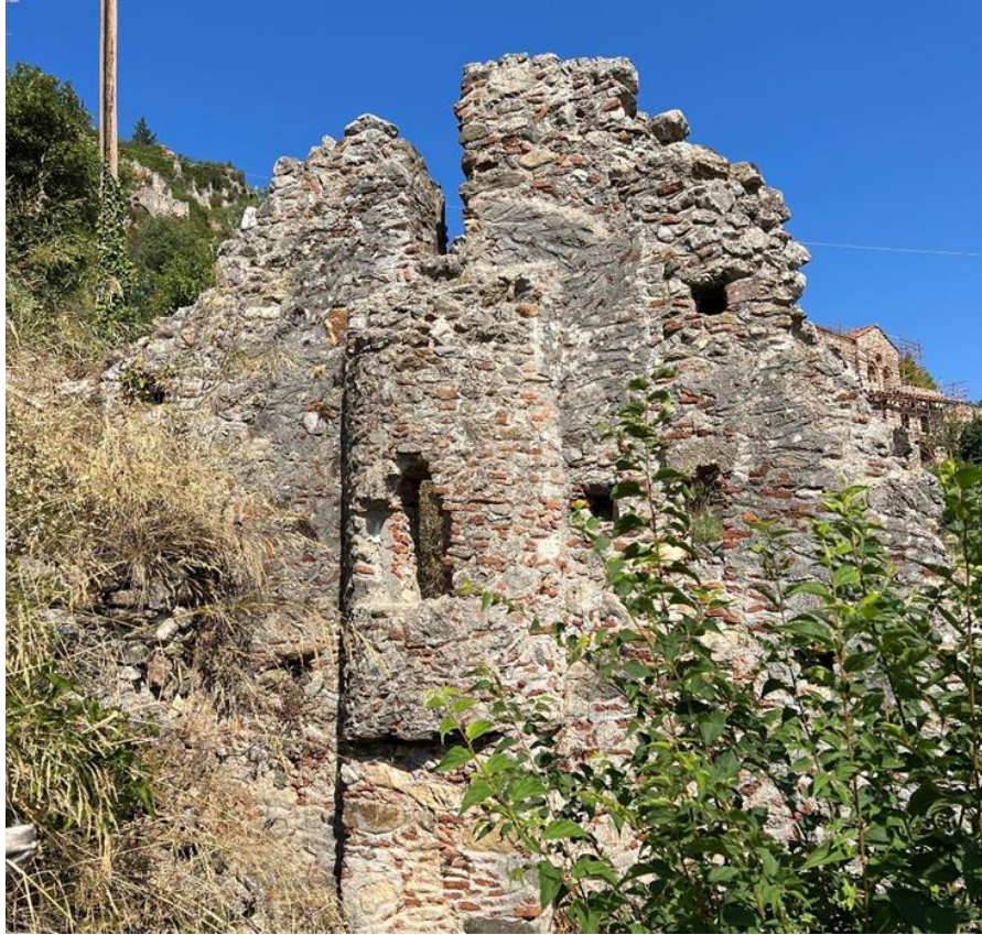
Εικόνα 24. Ναΐσκος Π8. Ανατολικός τοίχος εξωτερικά.
