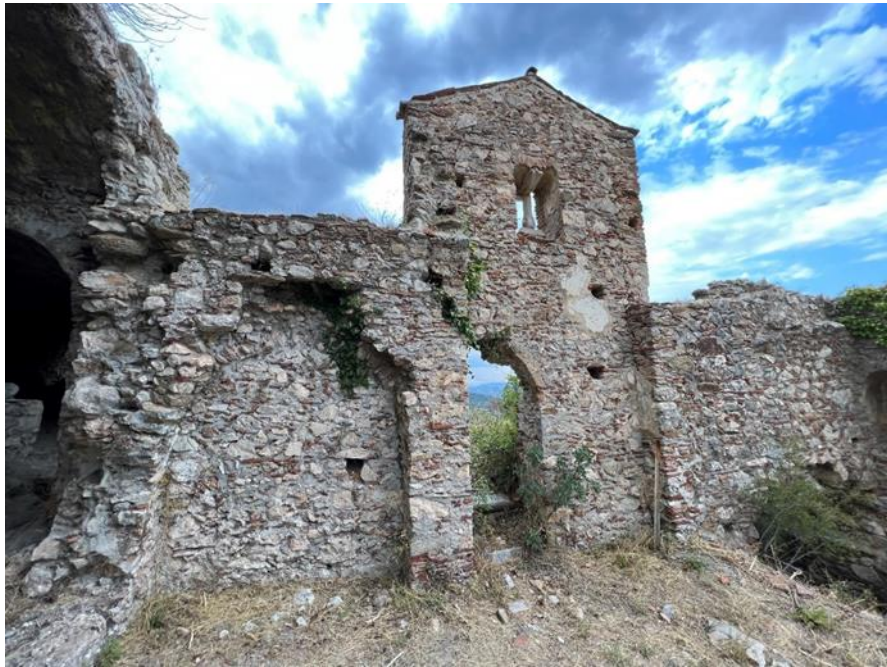
Εικόνα 81. Ναϊσκος Π19 (Αγία Παρασκευή). Βόρειος τοίχος, εσωτερική όψη.
