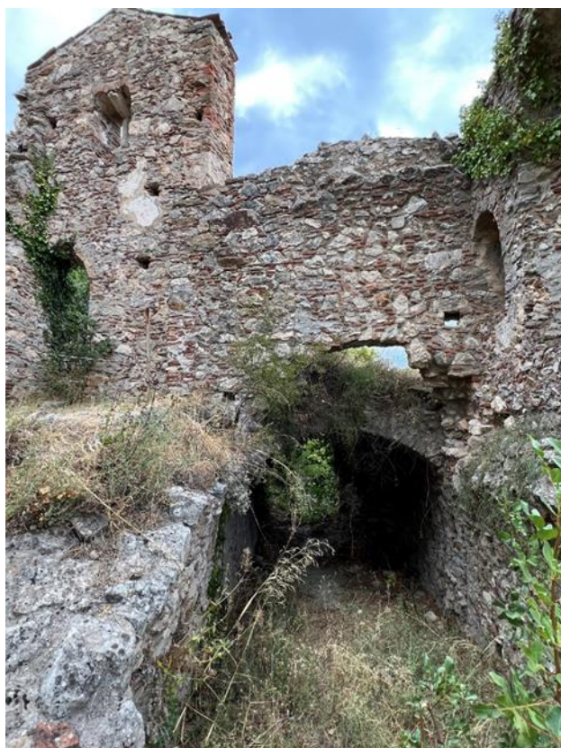
Εικόνα 76. Ναΐσκος Π19 (Αγία Παρασκευή). Θολοσκέπαστος χώρος (διαβατικό) κάτω από τη στάθμη του Ιερού.
