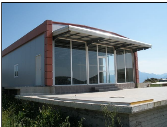
Κατασκευή κυλικείου – Χώρου Αναψυχής
