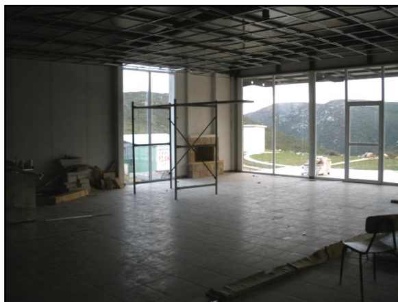
Κατασκευή κυλικείου – Χώρου Αναψυχής
