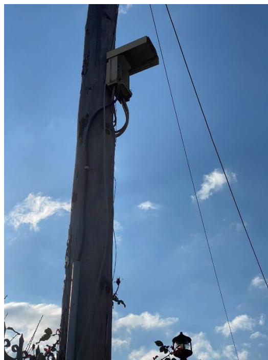
Εικόνα 6.3 Το BOX/Escalit που τερματίζει το υπόγειο καλώδιο PET τύπου 8
