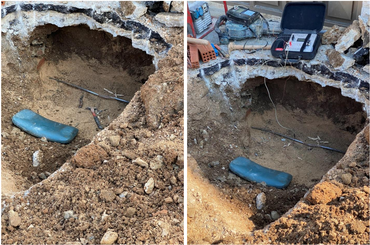
Εικόνα 6.8 Η εκσκαφή του διατρήματος για τον εντοπισμό και την αποκατάσταση της βλάβης. Επαναλήφθηκε η δοκιμή με τη μέθοδο γέφυρας για να επαληθευτεί ο ακριβής εντοπισμός της θέσης σφάλματος. Έπειτα έλαβαν τόπο οι διαδικασίες αποκατάστασης της βλάβης.
